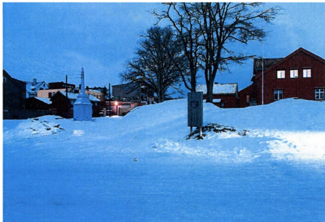
Bilde 22. Transformatoriosk i "vollgraven" på festningsvollens vestsida. Foto: June Åsheim, Tromsø Museum
