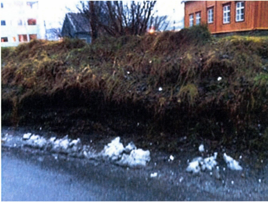
Bilde 28. Kjørespor i jordvollen etter tunge kjøretøyer. Skansens nordøstre side. Foto: Ragnhild Myrstad, Troms fylkeskommune
