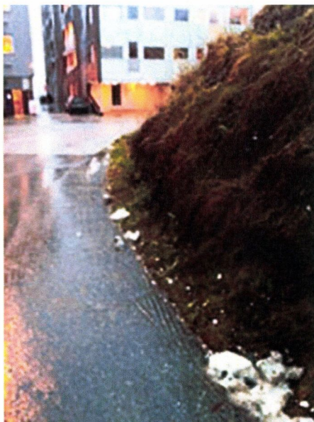
Bilde 29. Skade på jordvollen i øst. Snøplogen? Foto: Ragnhild Myrstad, Troms fylkeskommune
