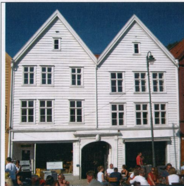
Bygning 4A til venstre, bygning 5A til høyre. 2008
