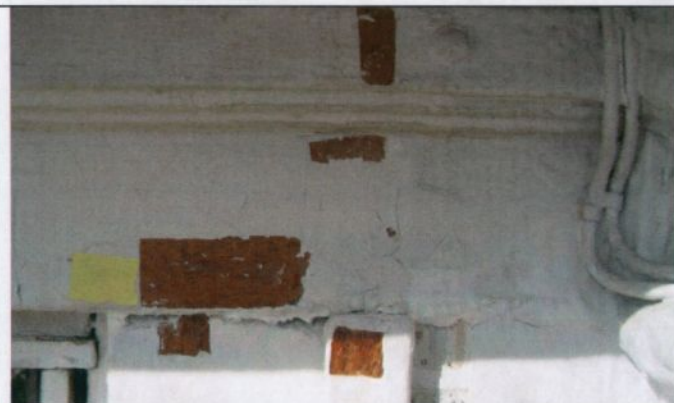
Mahognyelementer rundt vinduet i 1.etg. 4A
