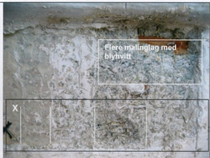
Sekundær list satt inn da da portalen ble løftet opp på sydsiden og gesimsen ble forsterket med jembeslag/knekter. Dette må være gjort tidlig.
