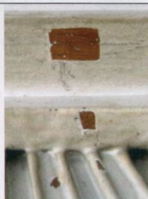
Panel og listverk ved dør, 1.etg.4A, er mahogny
