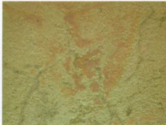
Fig. 5. St. Georg-figuren. Detalj av avvasket maling- og kalklag. Før behandling
