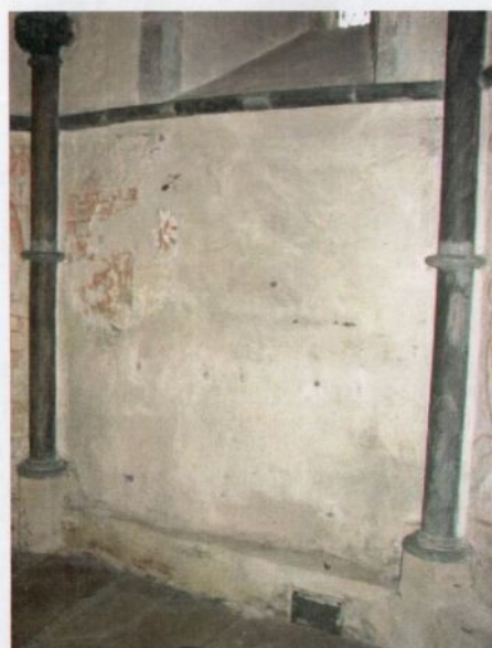
Fig. 5. Monteringshull etter panelovner
