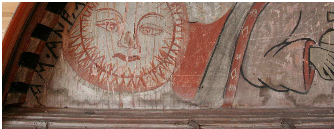
Fig. 23: Før konsolidering in situ . Kraftige skittskjolder i nedkant. Foto: J. Brønne, NIKU, 2007
