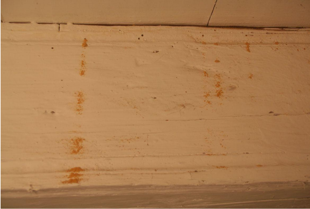
Figur 9. Boremel etter insektsangrep er observert mange steder på takbjelkene. Dette bør undersøkes av fagfolk med spesialkompetanse på området.
