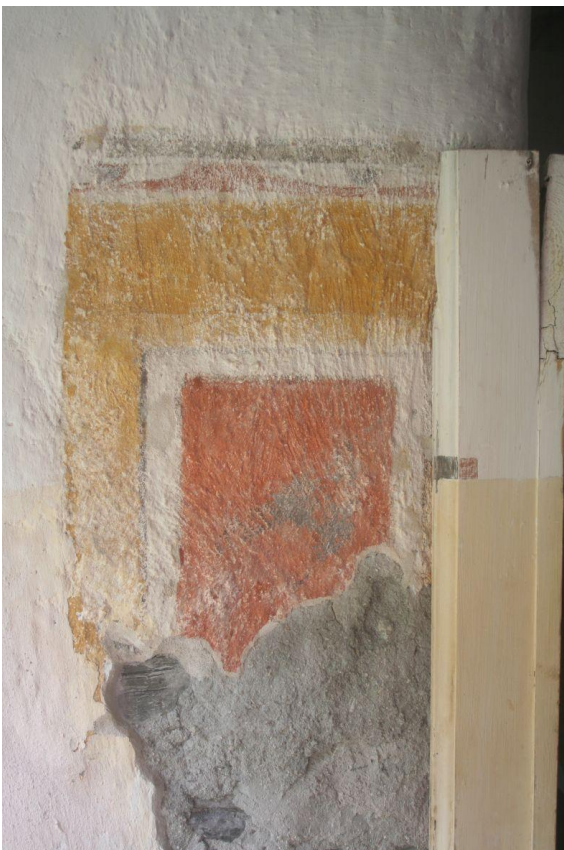
Figur 5. Avdekket og avgrenset malt brystning i nordportalen. Etter behandling i 2011. Brystningen er samtidig med og en imitasjon av første malinglag på den eksisterende trebrystningen i koret.
