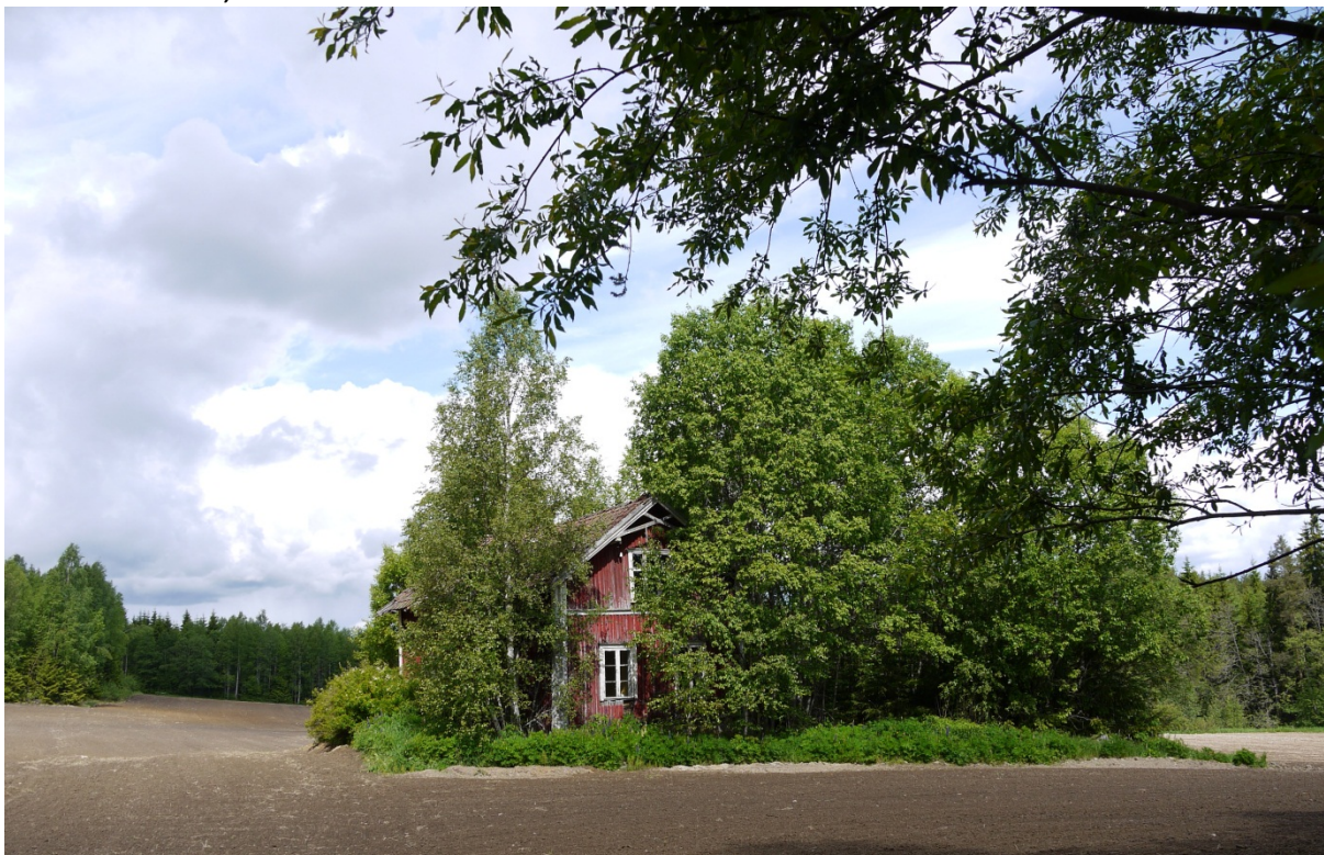
04200011006: Bondens bygninger utgjør 72 % av de gjenstående SEFRAK-bygningene i Eidskog i 3. omdrev. Andelen sterkt truete bygninger i denne kategorien er noe lavere enn det samlede gjennomsnittet for kommunen. Flere av de truete og sterkt truete bygningene er bygninger som ikke lenger er i bruk, slik som dette våningshuset som nå er omgitt av dyrket mark på alle sider. Foto: ÅD, NIKU 2012.
