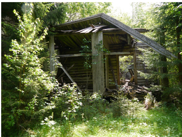
04200013015: Overgangen mellom sterkt forfall og ruin er glidende, men når taket er falt inn og bygningen ligger forlatt og i gjengrodd terreng, er det grunn til å registrere bygningen som tap. Foto: FC, NIKU 2012.
