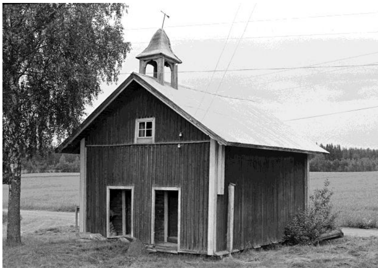
04200013032: Bygninger som flyttes ut av tunet registreres som tap i forbindelse med kontrollregistreringen i Gamle hus da og nå . Dette stabburet i Trandum krets er et slikt eksempel. I 2. omdrev var bygningen demontert for flytting, og ble registrert som tap. I 3. omdrev er flytting ikke registrert som tapsårsak for noen av de tapte bygningene i Eidskog. Foto: SEFRAK.
