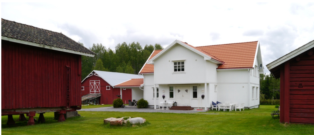
04200015030: 47 % av de gjenstående SEFRAK-bygningene i Eidskog kommune er endret, men kun 3 % har store volumendringer, slik som dette påbygde våningshuset i Vestre Matrand krets. Foto: FC, NIKU 2012.
