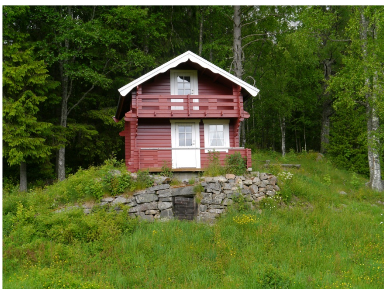
04200005008: Her er den gamle kjellerbua revet og en ny bygning er oppført på stedet. Foto: KF, NIKU 2012.
