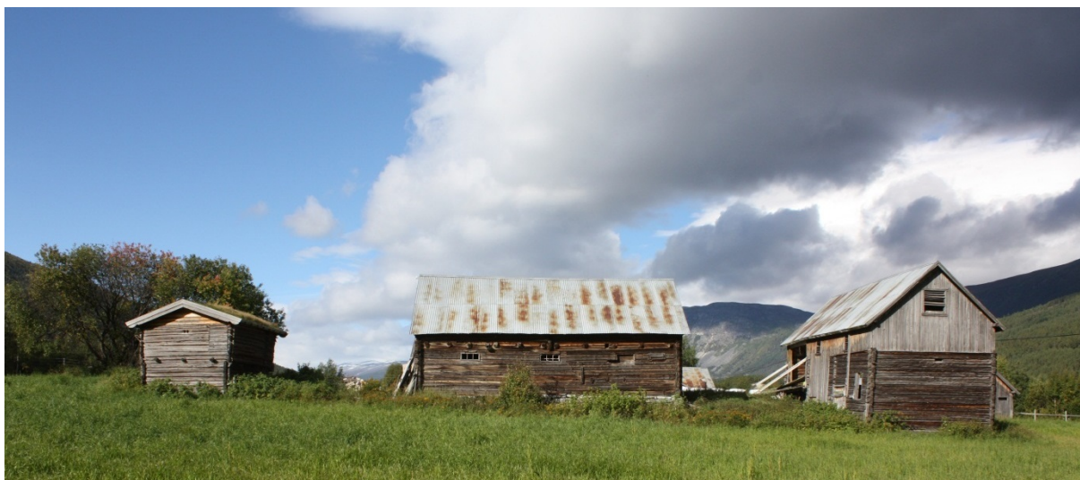
05130008037: Tapsandelen er høyest for driftsbygninger i landbruket i spredtbygde områder. Bygningene på Eiesar i Nordberg krets er i god stand og lite endret. Foto: RM, NIKU 2012.
