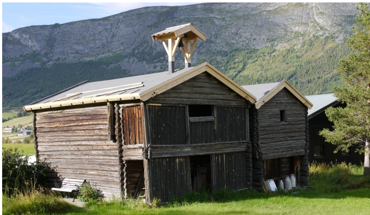
05130001049: I Skjåk kommune har kontrollregistrering av SERFAK-bygninger blitt gjennomført i 2002, 2007 og 2012. Stabburene på Gjeilo søndre er intakt og har nye tak, etter stormen Dagmars herjinger i julen 2011. Foto: ÅD, NIKU 2012.
