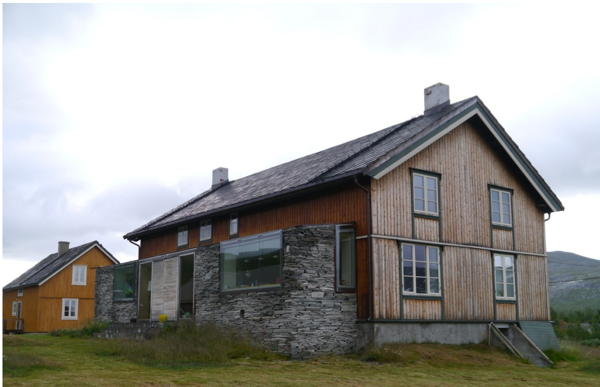
05130011131: Som i 1. og 2. omdrev er våningshus/bolighus en bygningsgruppe med høy andel endrete (52 %). 22 % av våningshusene har mindre volumendringer, slik som dette tilbygget på fjellstuen på Grotli, mens i 24 % av tilfellene er det bare bygningens overflater som er endret. Foto: KF, NIKU 2012.
