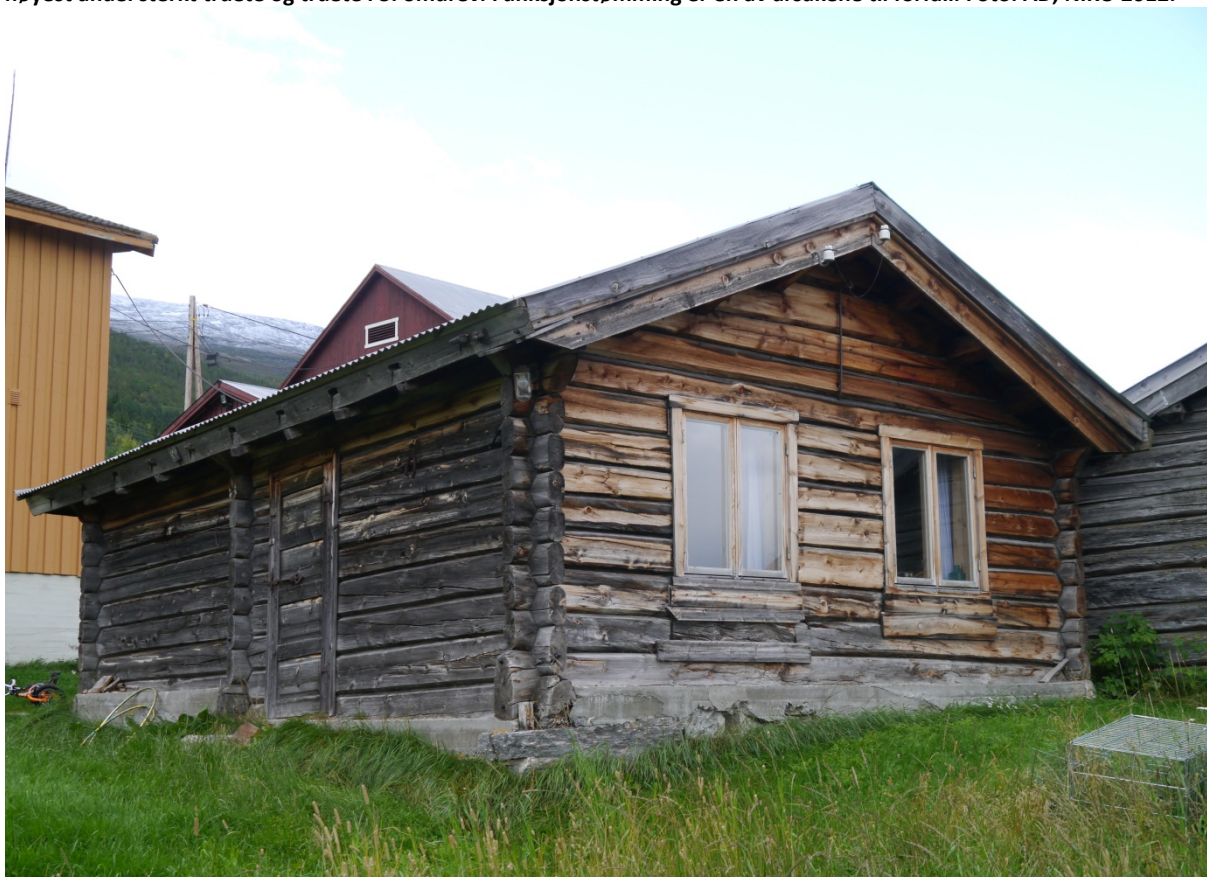
05130005039: Våningshusene har gjennomsnittlig best bygningsteknisk tilstand av SEFRAK-bygningene i Skjåk. Dette våningshuset i Øyom krets er registrert som intakt i alle tre omdrev av kontrollregistreringen. Foto: KF, NIKU 2012.
