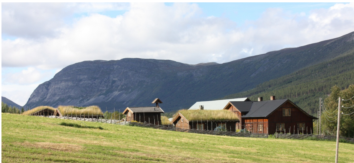
05130008020: Tre mindre uthus på Nedre Flekkøy i Nordberg krets ble registrert som tapt i 1. omdrev. Ingen av de tre gjenstående SEFRAK-bygningene har store endringer og alle er i god stand. Foto: RM, NIKU 2012.
