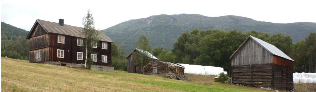
05130006056: Skjåk er fra gammelt av en utpreget jord- og skogbrukskommune, men antall jordbruksbedrifter i kommunen har vært synkende. 97 % av de undersøkte SEFRAK-bygningene i kommunen i 3. omdrev har opprinnelig vært knyttet til landbruk, fiske og fangst, slik som dette gårdsbruket på Solsiden i Holemork krets. Foto: RM, NIKU 2012.
