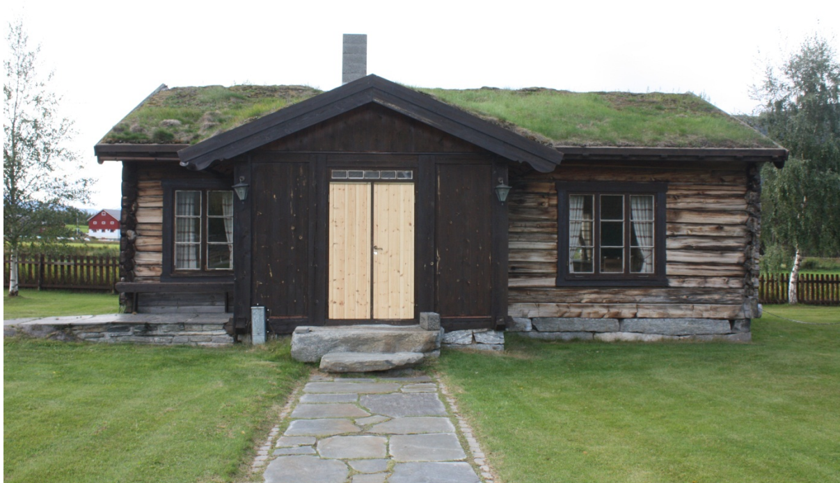
05130008085: I noen tilfeller er deler av bygningen revet. I Skjåk gjelder dette 17 bygninger, blant annet Kyrkjestugu i Nordberg, hvor den østlige enden av bygningen er fjernet. Inngangspartiet er også endret, og de tidligere takplatene er skiftet ut med torv. Foto: RM, NIKU 2012.
