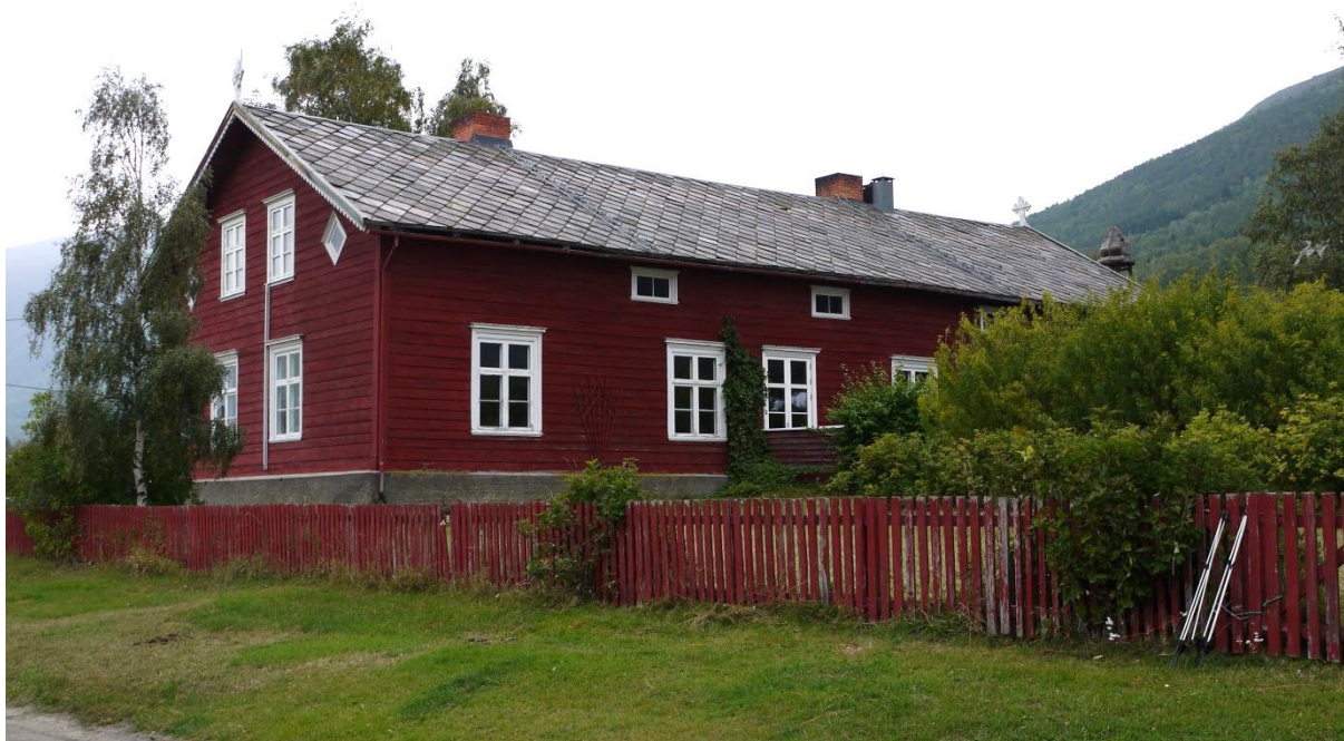
05130003120: Våningshuset på Skjåk prestegård på Marlo er den ene av kun tre gjenstående SEFRAK-bygninger i kategorien embetsverk/institusjon i Skjåk, etter at Gamle Marlo skole ble registrert som tapt i 1. omdrev. De to andre bygningene i denne kategorien er stabburet på prestegården og Kyrkjestugu på Nordberg. Foto: ÅD, NIKU 2012.
