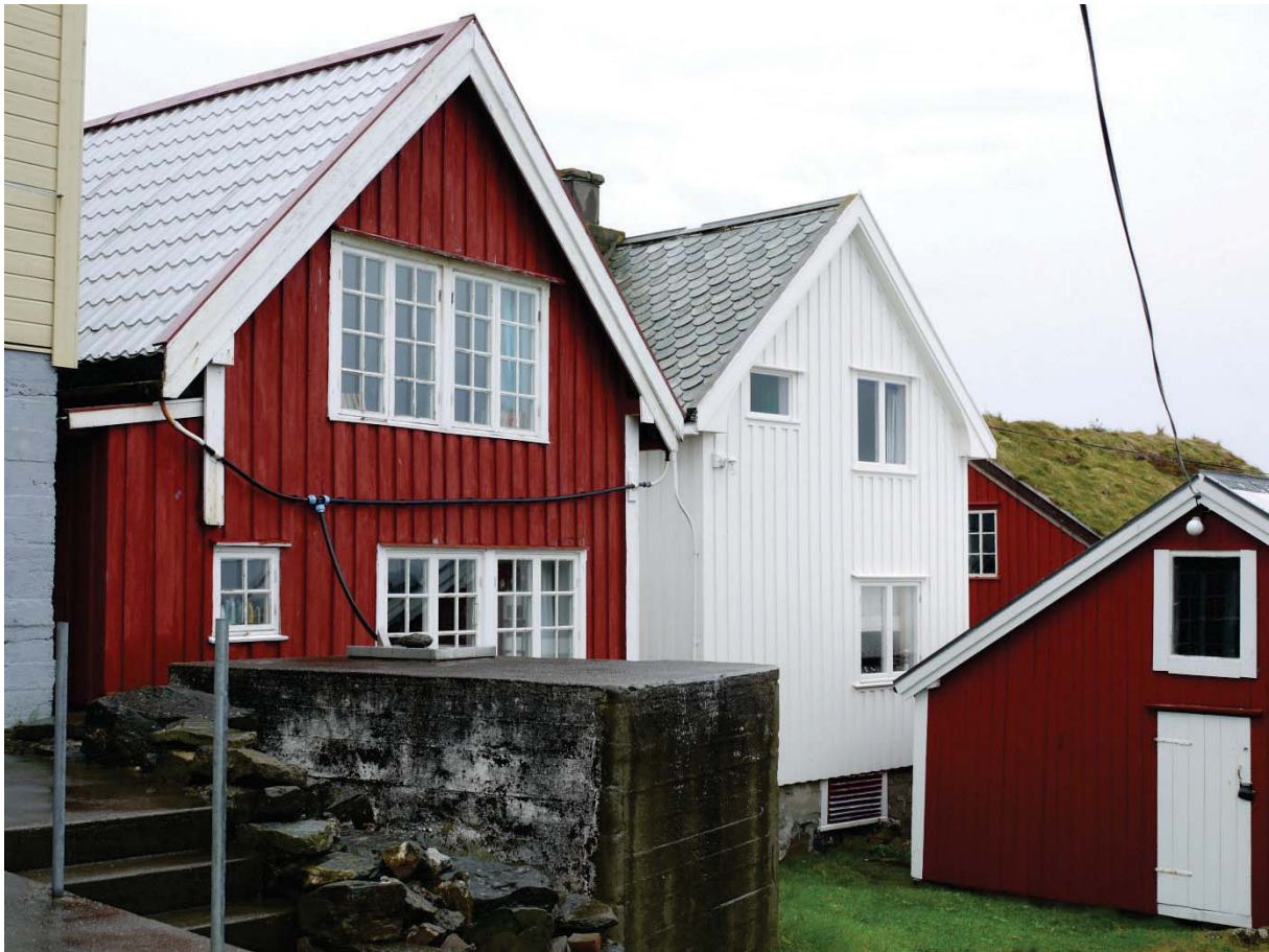
15480001045: Bjørnsund-øyene tilhører de spredtbygde kretsene i undersøkelsen, selv om bygningene ligger tett i de tidligere fiskeværerne på Nordre og Søndre Bjørnsund.
