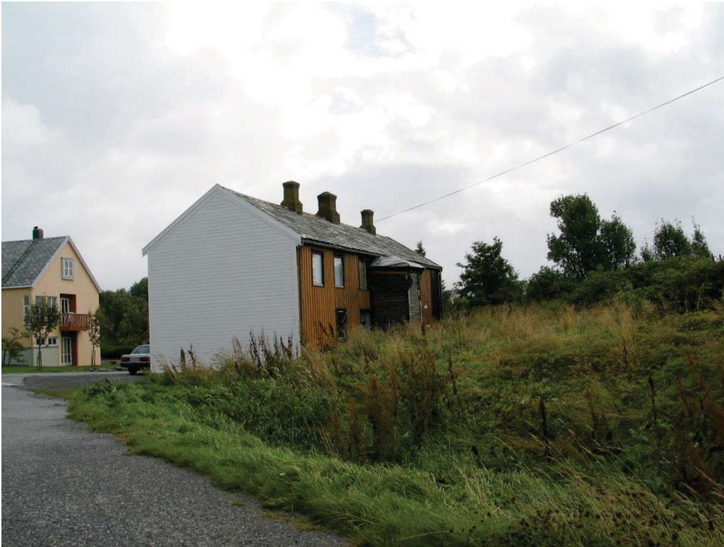
15480016050: Av de ulike bygningstypene, er det bolighus/våningshus som er mest utsatt for endring i Fræna. Dette huset var under rehabilitering i 2005. Foto: Kulturminnekompaniet.
