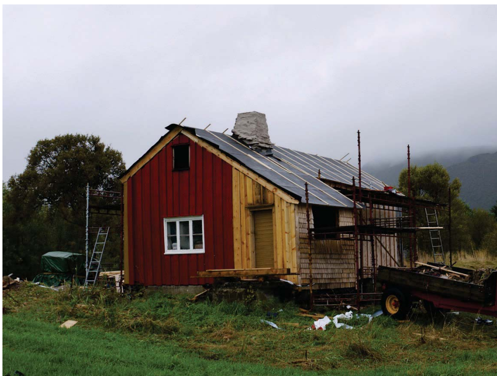
15480019039: Restaureringsarbeidet på dette våningshuset gjør at bygningen har gått fra truet i 2005, til intakt i 2010.
