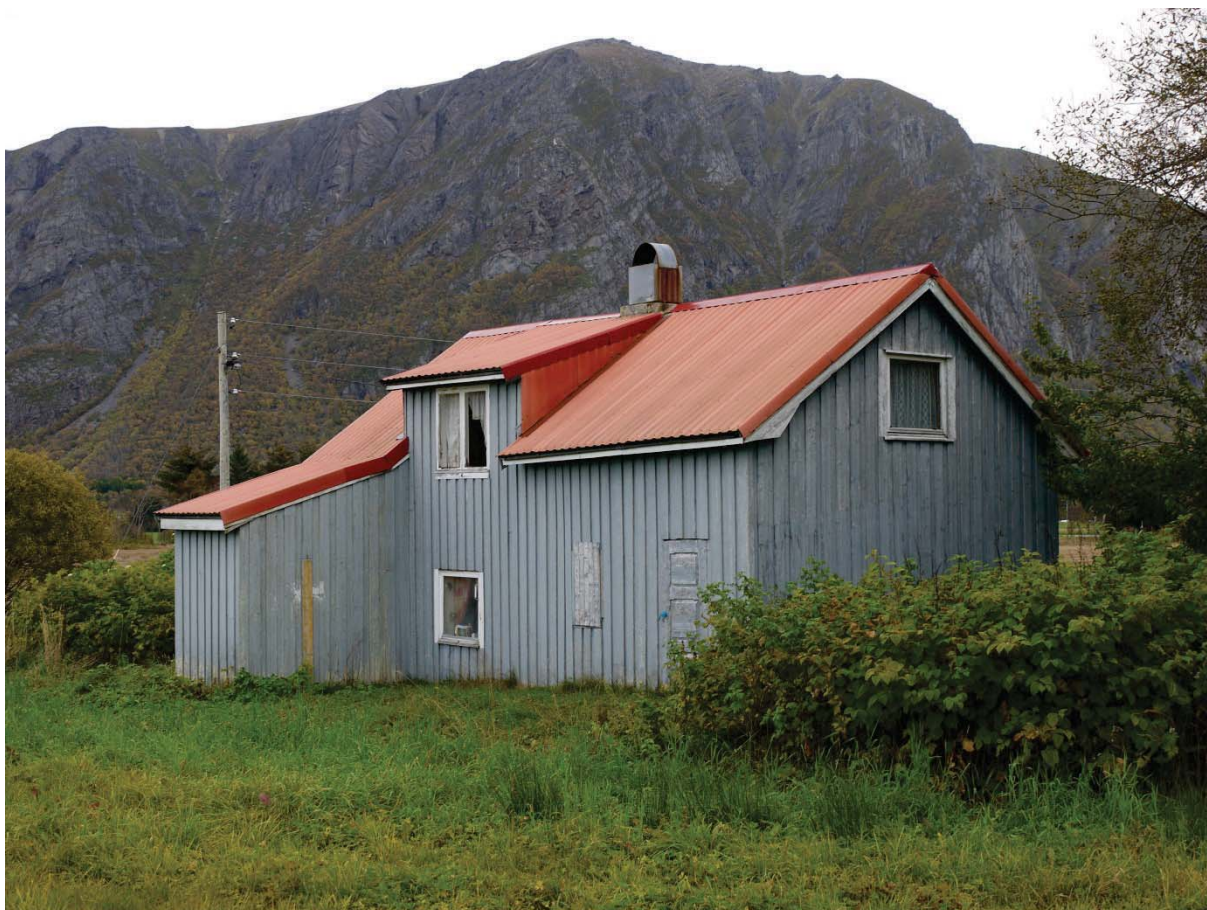
15480020045: Mer enn halvparten av bygningene i 3. omdrev i Fræna er endret. De fleste av endringene er imidlertid relativt små (C-endring), slik som på dette våningshuset i Farstad, hvor selve bygningsvolumet er intakt.
