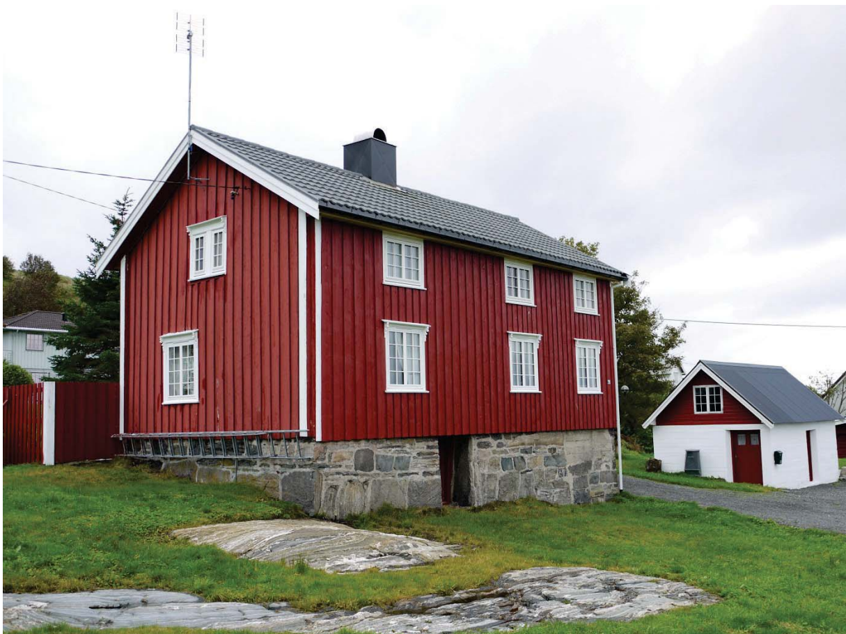
15480016012: 73 % av de 40 bygningene i undersøkelsen som ligger innenfor bevaringsområdet i Bud sentrum er registrert som endret i 2010. De fleste endringene er av minste grad (C-endring). Ett eksempel er denne bygningen. To av bygningene i området er sterkt endret (A-endring).
