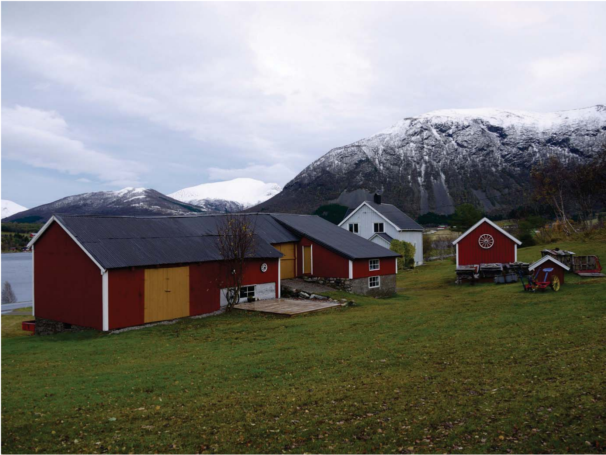
15480009002,15480009003: I 2010 ble 44 % av de gjenstående bygningene i Fræna registrert som uendret. Løa og stabburet på denne gården er blant disse. Andelen av uendrete bygninger er dermed 6 % lavere enn i 2005.
