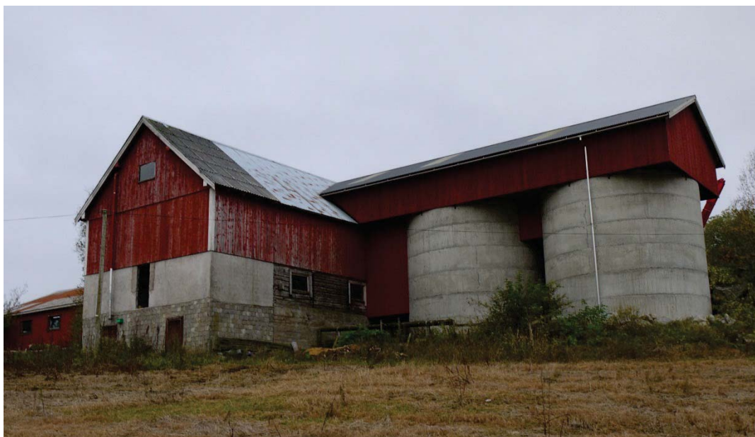
15480012027: Antall endrete bygninger i Fræna har økt, fra 43 % i 2005, til 56 % i 2010. Denne driftsbygningen har blitt påbygd i takt med utviklingen i landbruket. Her er det registrert stor endring (A-endring) fra 1. omdrev.
