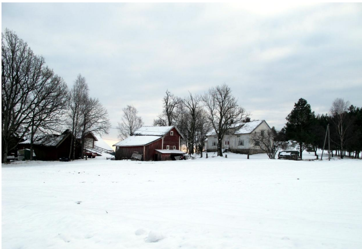
105-1404-011, 012, 013. Fra Skjeberg, bygningene i tunet, våningshus, bryggerhus, stabbur og driftsbygning forfaller, men jordveien holdes intakt.
