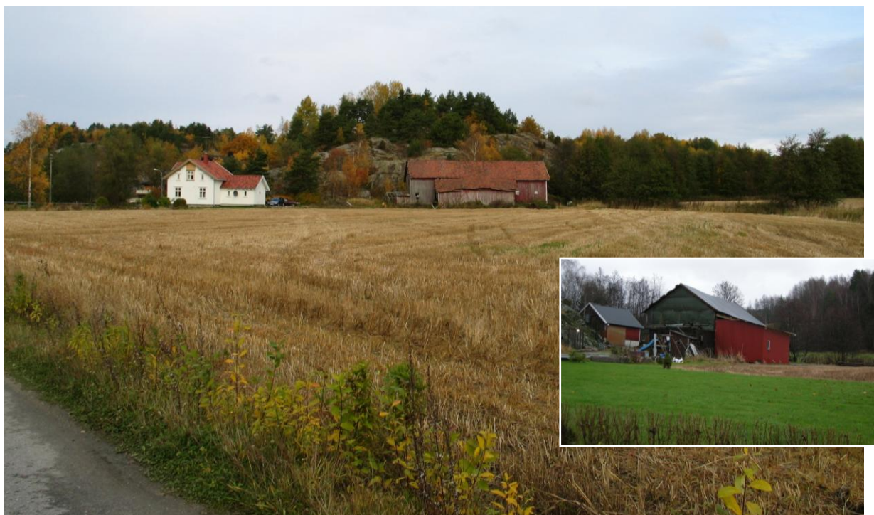
130-510-021,023. Vister i Tune. Våningshuset og driftsbygningen på gården ligger inn mot knausene i ytterkant av matjorda, en beliggenhet karakteristisk for gårdsbebyggelsen i deler av Østfold. Det store bildet er fra 2004, og driftsbygningen var da preget av forfall. I 2009 er deler av den revet, mens resten settes i stand.
