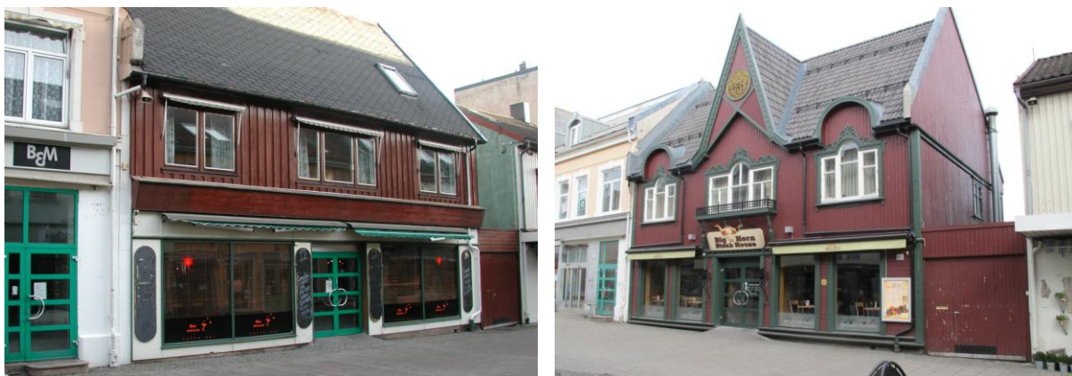
105-0205-055. Bygård i gågata – til venstre i 2004, til høyre i 2009. Huset er ikke utvidet, det er bare gatefasaden som har gjennomgått endringer med bl.a. den lille arken og skifte av vinduer. Endringskategori C.
