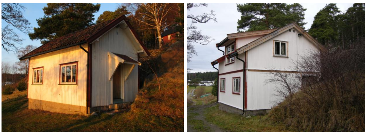
115-206 001. Sommerbolig på Sjøstrand ved Horneskilen. Huset skal være bygd som bryggerhus på et fiskerbondebruk tidlig på 1800-tallet, men var i bruk som fritidshus ved registreringen i 1991. Det var uendret i 2004 (foto til venstre). I 2009 er det utvidet i bredde og påbygd med ark. Det har bevart stilpreget det hadde ved registreringen. Arealutvidelsene er store, men siden det opprinnelige huset fortsatt er gjenkjennelig er endringen klassifisert som type B.
