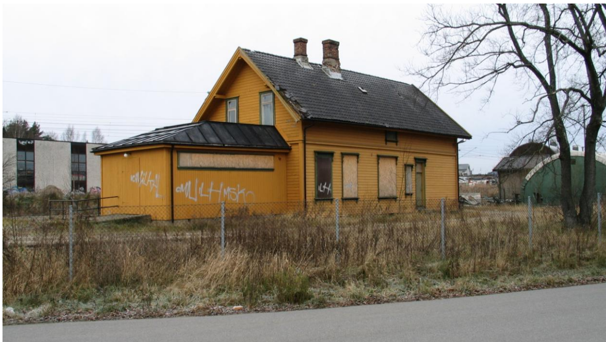
130-0201-024. Stasjonsbygningen på Sannesund var knyttet til Østfoldbanens indre linje som ble åpnet i 1882. Stasjonen ble nedlagt i 2002, og i 2006 var stasjonsbygningen revet. Ved det nye dobbeltsporet var det ikke lenger behov for den. Huset ble tegnet av jernbanearkitekt Peter Andreas Blix.
