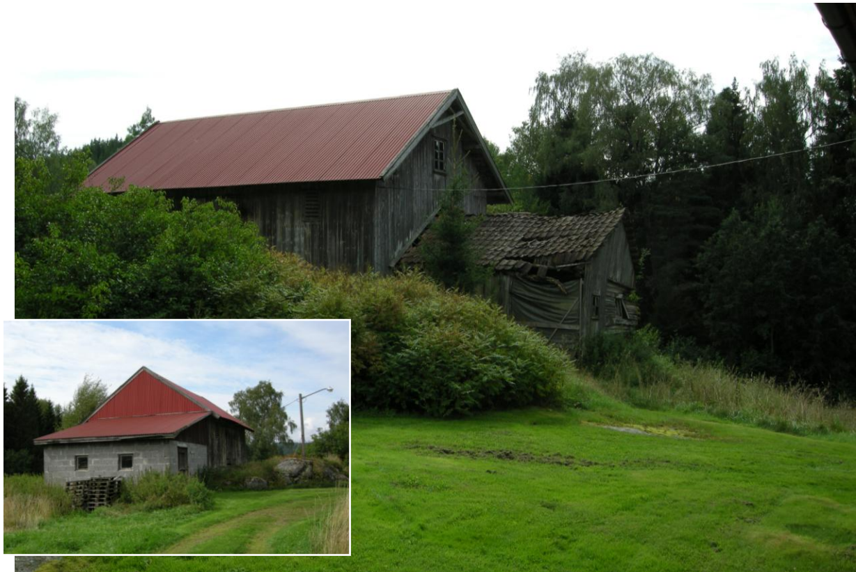
114-104-013. Driftsbygning i Varteig av den gamle typen med tømmerlåve i midten og fjøs og stall i hver sin gavlside. Den eldste delen skal være fra ca. 1850. Særlig stallen er dårlig og holder på å falle sammen. Innfelt den nye fjøsdelen fra 1978. Det var opprinnelig tegl på taket, men den er nå skiftet ut med plater, med unntak for den falleferdige staldelen. I tunet står et nytt husbankhus.
