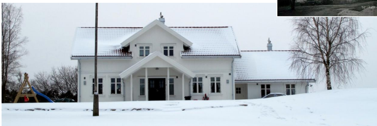
115-101-006. Våningshus i Skjeberg som er pusset opp og der funkisvinduene er skiftet ut med høykors.
