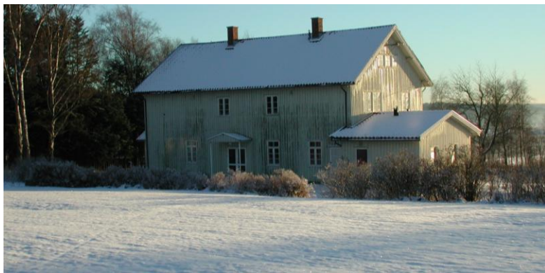
105-1310-002. Dette huset på Værn i Rokkeveien har hatt flere funksjoner siden det ble bygd, bl.a. skole og det har blitt utvidet noen ganger. På 1960-tallet ble det gitt i gave til Skjeberg kommune. Det ble da ombygd og brukt av teknisk etat, bla. parkvesenet. I 2004 sto det tomt, i 2009 var det revet. Foto fra 2004.
