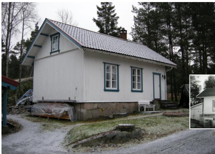
115-201-028. Tidligere skolestue som er pusset opp og tatt i bruk som bolig. Et lite pultutbygg er revet.
