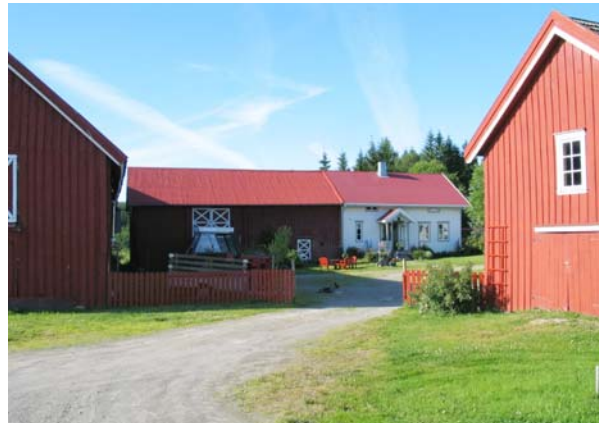
På Vestre Gravbrøt er kårbygningen og treskelåven (1736-008-034, 035) bygd sammen slik at de utgjør en vegg i firkanttunet. Begge hus skal være satt opp samtidig – ca. 1880. Det vanligste er at det er låve og fjøs som er bygd sammen.
