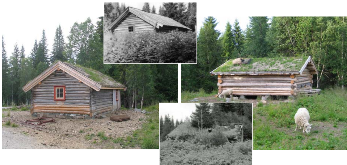
Begge setervollene til Østre og Vestre Gravbrøt i Bolåsen var preget av gjengroing og hus i forfall ved registreringen i 1990. I dag er fjøsbygningene satt i stand. Fjøsset til Østre Gravbrøt (1736-007-053) hadde best utgangspunkt, og her er kun de nederste stakkene byttet ut. Fjøsset på Vestre Gravbrøt (1736-007-055), som nærmest var i ruin, har i hovedsak nytt laft i dag.
