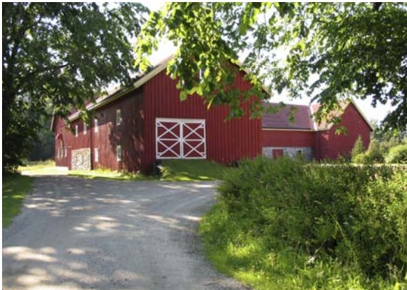
Deler av den store, vinkelbygde driftsbygningen på Vinje (1736-003-071), prestegården i Snåsa, skal være bygd godt ned på 1800-tallet. Den har gråsteinsmurte rom for dyr i begge fløyer. Mange av driftsbygningene i Snåsa er bygd etter tilsvarende lest, og det er lett å tenke seg at prestegårdens har vært forbilde.
