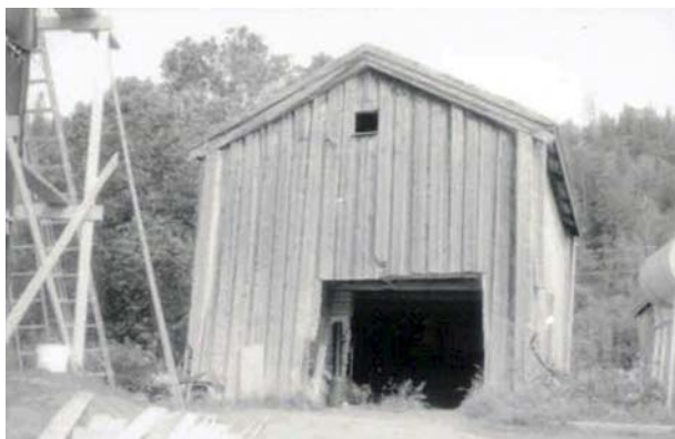
Det ene stabburet (1736-010-012) på Vestre Steinkjær i Imsdalen var tatt i bruk som garasje ved registreringen i 1985. Det er nå erstattet av ny garasje på samme sted. Det andre buret i tunet står uendret. Stabbur har en lav andel av tapene.
