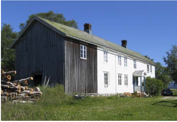
Hovedbygningen på Søndre Aun (1736-009-053). Flere av stuelåna i Snåsa har et uthus, et skott for enden bygd inn under samme tak som hovedbygningen. Som regel med vedbod som her. Det varierer hvor godt synlig dette elementer i eksteriøret.
