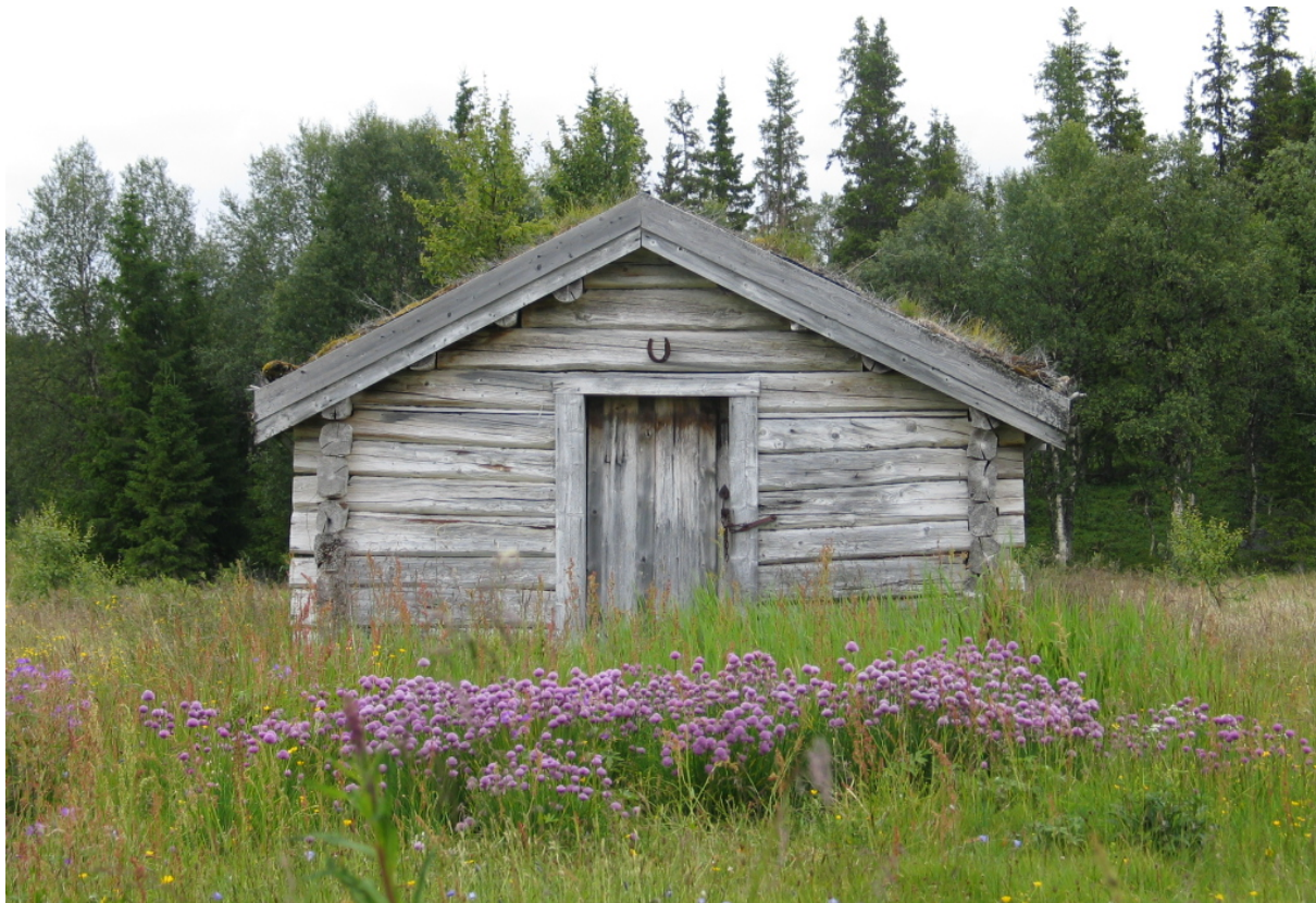
Masstu på fjellgården Gressåmoen. Siden registreringen i 1986 er mange av bygningene på Gressåmoen utbedret og satt i stand. Masstua har bl.a. fått nytt torvtak (1736-007-034).
