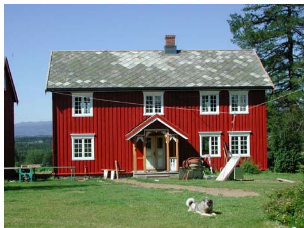
Kårstugu på Søndre Belbu er nylig satt i stand med tilskudd fra STILK-ordningen. Bl.a. er skiftertaket restaurert. (1736-009-046)
