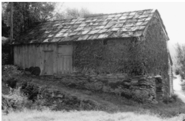
1242-009-076. Driftsbygningen sto på samme småbruk som vedboden nevnt over. Den var bygd på tradisjonell måte i grindkonstruksjon, kledningen var stående trepanel og brake - og på taket lå steinheller. Ved registrering var den i bruk som lager, i 2004 var den borte.
