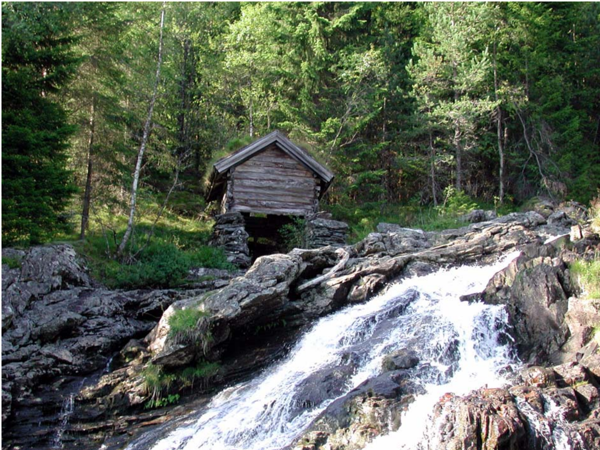
1242-005-036. Kvernhus på Fiske som nylig var vølt ved SEFRAK-registreringen i 1982.
