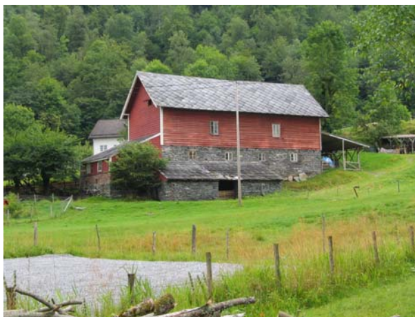
1242-003-012. Denne løa på Ådland er en av de større, eldre driftsbygningene i Samnanger, iflg. registreringen har den grindabygd løe over steinfjøset
