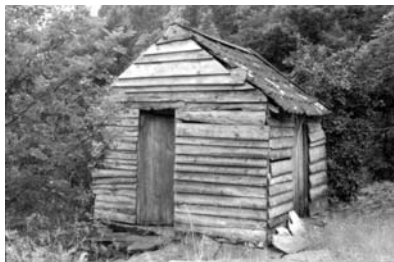
1242-003-227. Tapsandelen på små uthus i tunet er høy – 31 %. Utedoen på Lauvskar var bygd på tradisjonell måte, i grindskonstruksjon, kledt med grovt supanel og tekt med takstein av krumme teglpanner.
