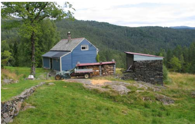
1242-003-298. Driftsbygningen på Bjønås var revet lenge før registreringen i området i 1981. Men deler av de fine fjøsmurene har fått nytt liv som mindre uthus.
