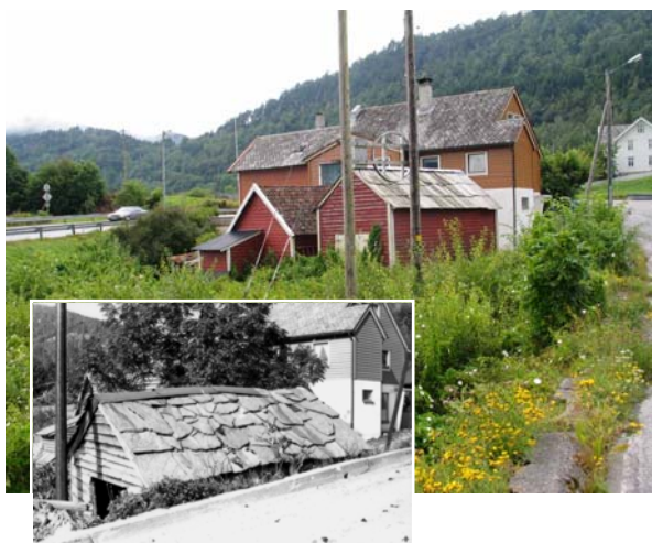
1242-003-016. Naustene på Ådland ble avskåret fra sjøen på grunn av ny veg (til venstre i bildet). I 2004 var det ene revet, innfelt bilde. Naustet var i grindkonstruksjon med villskifer på taket. I bakgrunnen butikken – den var ikke i bruk i 2004.
