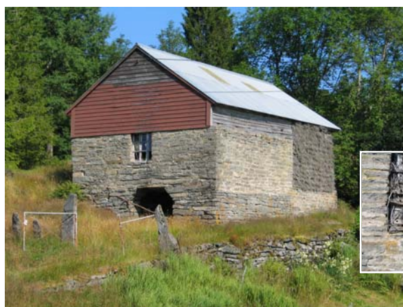
1242-005-002. Løe på Tveitarås, med natursteinsmurt fjøs, grind og brakeledning.
