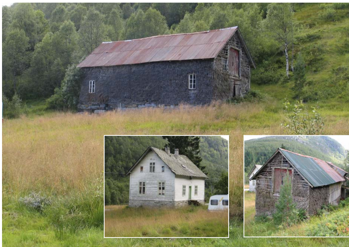
1242-007-079, 080. Våningshus og driftsbygning på bruket Eikedal i Eikedalen. Ved SEFRAK-registreringen var stedet mest i bruk som feriested –i løa var brensel m. m . I 2004 var ikke husene i bruk. Brakeledning på løa begynte å bli dårlig i 1985, og i 2004 var situasjonen forverret. Våningshuset er typisk for den nøkterne sveitserstilen i området. I den ene stua i huset var det omgangskole fra slutten av 1800-tallet til 1920-tallet.
