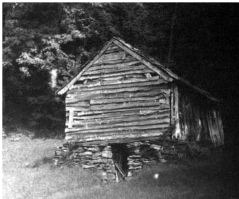
1242-003-038 Løa over var bygd i grindkonstruksjon med villskifer på taket og flor/fjøs i kjeller. Husmannsplassen den sto på, ble etter hvert feriested og løa ble revet. Et nytt hus er bygd på stedet, dels på de gamle murene.
