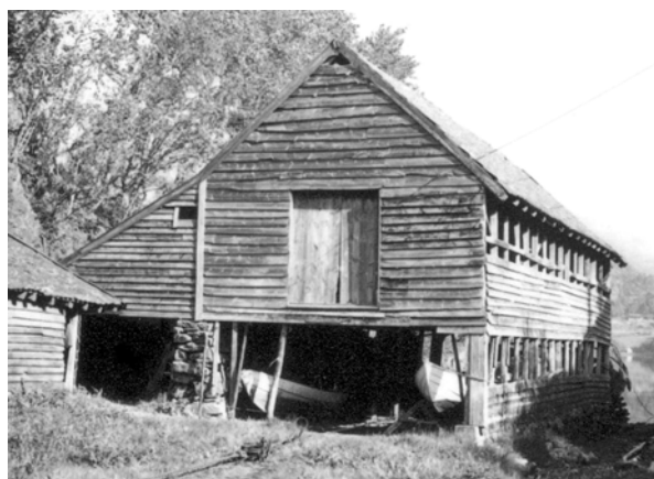
1242-002-181. Notabu og naust i Liøyni. I andre etasje skal det iflg. registrering ha vært verksted og redskapsrom. Huset ble etter hvert i heller dårlig stand, og ble til slutt revet.
