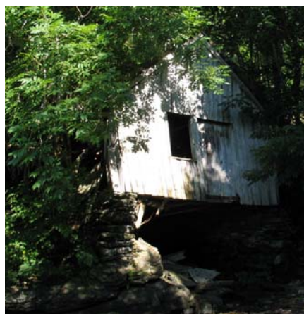
1242-002-220. Naustet var i rimelig god stand i 1979, i 2004 må det betegnes som truet. Småskogen har rykket nærmere. Som driftsbygningen er naustet i grindkonstruksjon, dels med villskifer dels med tegl på taket.
