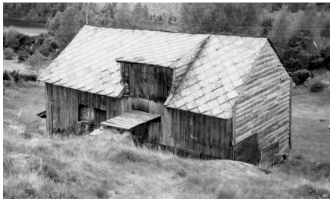
1242-001-119. Driftsbygning på Sagen. Den var bygd i grindkonstruksjon med flor av teglstein innafor reisverket og låvebru. Ved SEFRAK-registreringen var den ikke lenger i bruk, og i 2004 var den borte.
