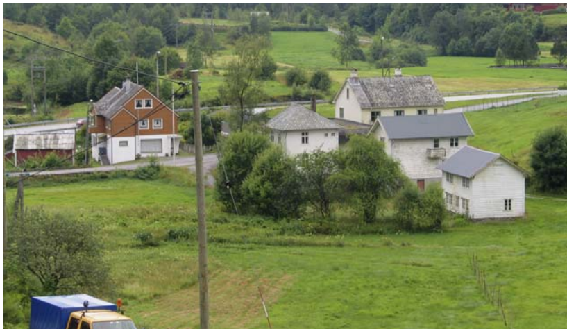
1242-003-048, 049, 050, 051. Fra det tidligere hotell- og handelsområdet på Ådland. Det er mer perifere enkelthus som står tilbake, selve hotellet ble revet ned for noen år tilbake. Til høyre betjeningsbolig for de ansatte, butikk og lagerhus. Til venstre nyere butikk som er sammenbygd med et eldre bolighus, foran ligger naust, som viser at sjøen tidligere gikk hit opp. Her ble fylt opp, på grunn av den nye riksvegen.
