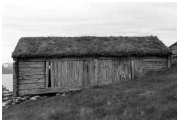
1902-4508-014. Det store åtringsnaustet i Grøtsundet som var bygd i skjelterverk gikk tapt i en brann. Det står meget få naust i den gamle skjelterteknikken tilbake, noe som gjør tap av disse særlig merkbare.
