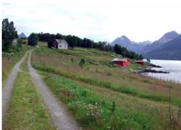
1902-3303-002. Fraflytta bruk i Sørfjorden/Moskavuotna. Våningshuset har stått tomt lenge, og forfaller.
