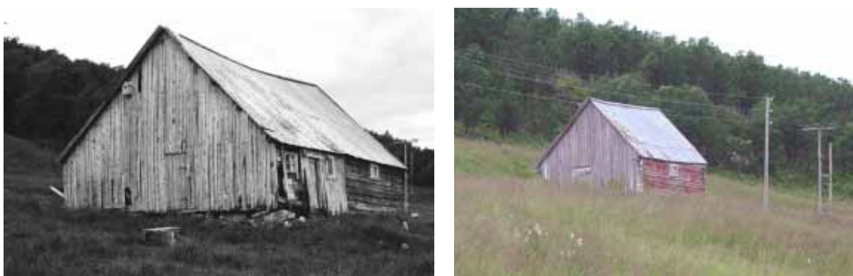
1902-4503-041. Drifisbygningen (fjosen) på Myran ved Kvalsundet var ikke lenger i bruk ved SEFRAK-registreringen i 1992. I 2001 var halve huset, trolig bindingsverksdelen revet. Endringen er klassifisert som endringstype B.
