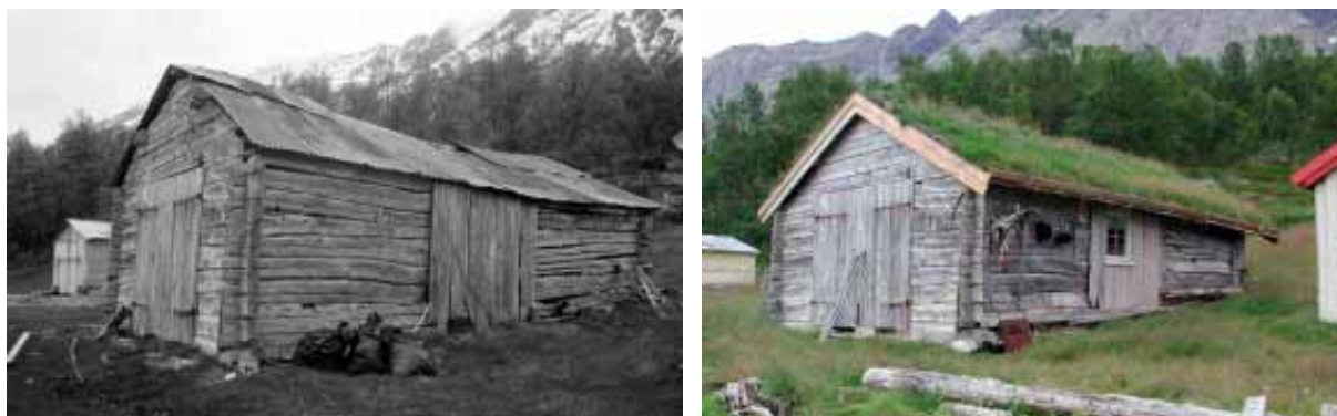
1902-3303-001. Naustet i Lakselvbukt i Sør fjorden/Moskavuoitna er et stort tømmernaust. Bildet til venstre viser naustet ved SEFRAK-registreringen i 1993. Siden er det er pusset opp, og den gamle bølgeblekken på taket er erstattet med torv. Endringen er klassifisert som endringstype C. Naustet ligger sammen med andre langt yngre naust.
