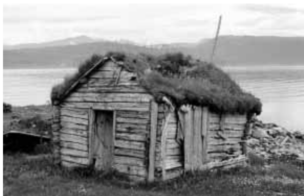
1902-2010-003. Bua på Tofte ved Kvaløysundet var ikke lenger i bruk ved SEFRAK-registreringen i 1992. Taket var begynt å bli dårlig, og til slutt falt den ned.
