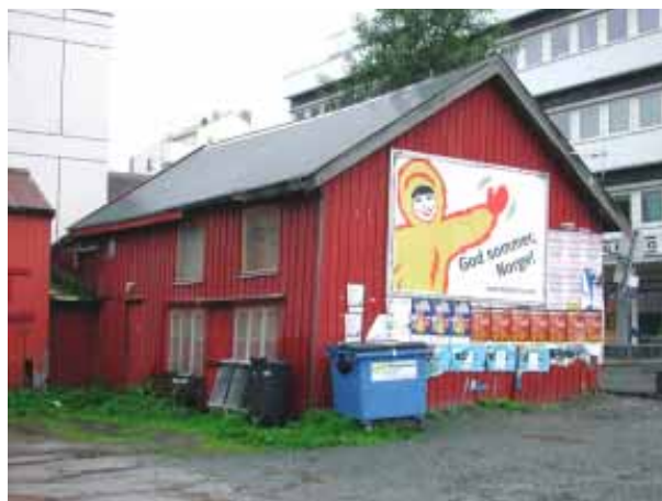
1902-0116-030. Skjåen til Storgata 58 ligger mot Grønnegata. Den skal opprinnelig ha vært tilknyttet Hotell Norden. Til venstre skimtes et annet bakgårdshus som også tilhørte dette hotellet. Uthus i bakgårder er en utsatt husgruppe, flere er blitt borte og av de gjenstående er mange i dårlig stand.
