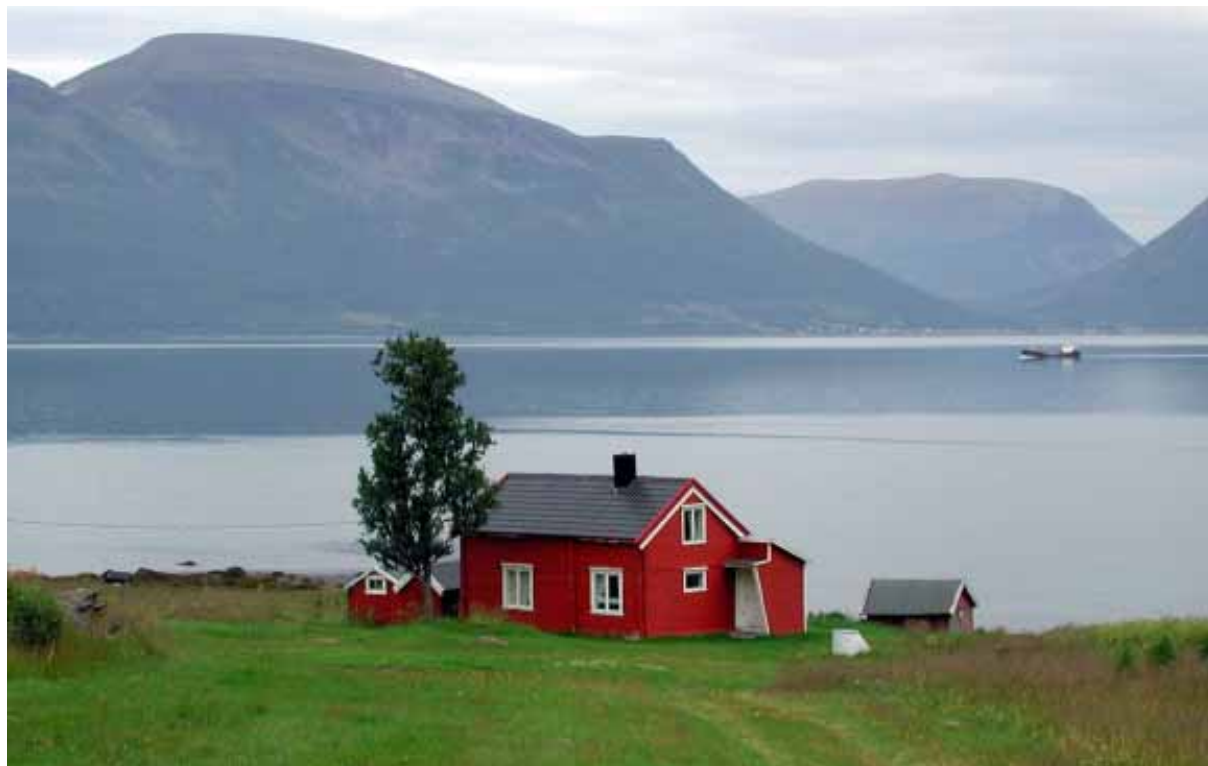
1902-3002-001-4, Snarby ved Grøtsundet. Småbruket er i dag feriested. Av de gamle husa i tunet står våningshuset og to buer tilbake. Siden registrering er takbelegget skiftet.
