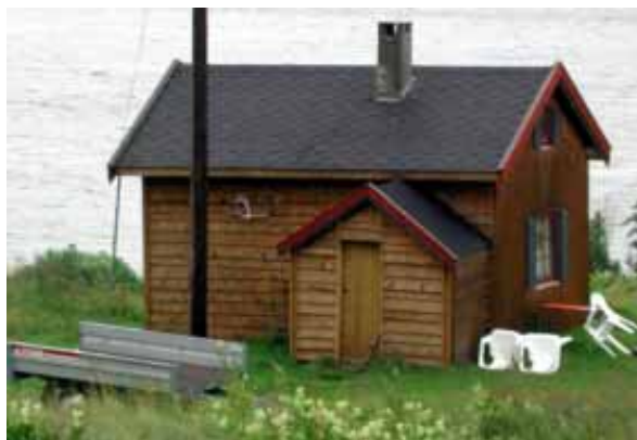
1902-4004-023. Den lille stua på Havnnes er i dag et feriehus. Det er gjort noen få endringer siden registreringen i 1993, takbelegget av papp er skiftet med ny shingelpapp, på tømmerveggen er det slått på "villmarkspanel", noe som også er brukt på bislaget der det før var tømmermannspanel. Endringene er klassifisert som endringstype C.
