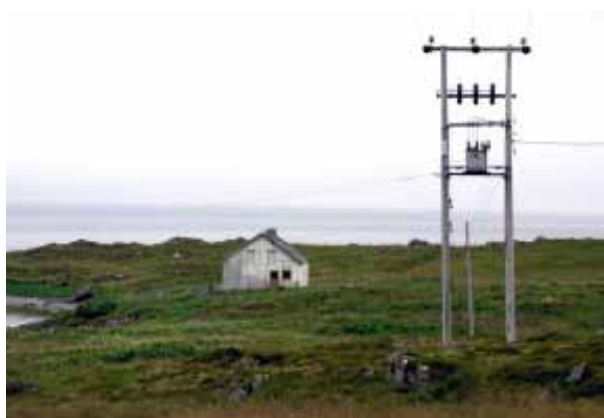
1902-4504-013. Skolestua på Rebbenenes ligger for seg selv. Den var i bruk som skole til 1942, siden som bolighus, men er nå ute av bruk.
