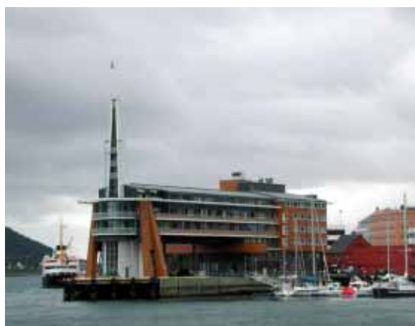
Lenger sør der den gamle moloen lå, stikker Rica Ishavshotell fram, bak dette Amalie hotell som ligger mot den gamle Post- og telegrafbygningen som var under oppussing til kunstmuseum i 2001.
