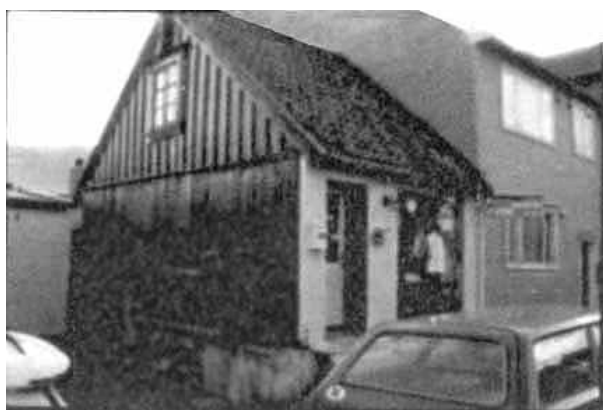
1902-0119-019 og 018. På Prestenggata 39 (til venstre) er alle ytre elementer skiftet ut siden registreringen i 1979 – nye vinduer, ny kledning og nytt taktekke. Endringene er klassifisert som endringstype C. Huset har ikke lenger karakter av butikk. Prestenggata 37 til høyre, har økt bygningsvolumet med en stor takark, i tillegg til fasadeendringer – bl.a. er de gamle fukisvinduene utskiftet. Endringene er klassifisert som endringstype B.
