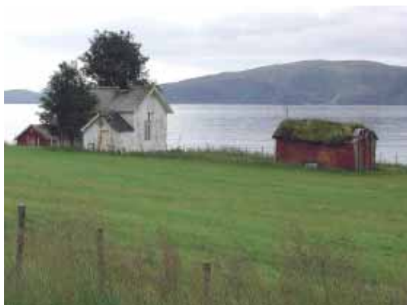
1902-4102-013. Skjåen på Nergård i Buvika (til høyre) forfaller, torvtaket er i dårlig forfatning. Skjåen kan ha hatt en boligfunksjon opprinnelig. Bruket har lenge vært fraflytta, og bare blitt brukt i ferietida.
