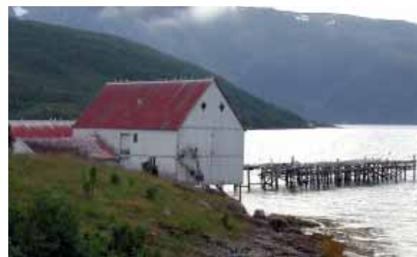
1902-3301-001. Brygga til Jøvik handelssted i Ullsfjorden. I gruppen naust og brygger er det flest naust, og det er relativt få brygger i grunnlagsmaterialet.
