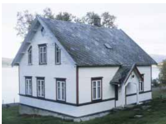
1902-3202-020. Våningshuset på Gjerdrum, Vikran er pusset opp. Der panel og vinduer er skiftet, er de kopier av de gamle. Huset er klassifisert som uendret.
