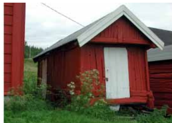
1902-3002-002. Bu på Snarby som er bygd i den gamle skjelerteknikken. Til venstre slik den sto ved SEFRAK-registreringen i 1989 med torv på taket. I 2001 er den pusset opp, og torvtaket er byttet ut med metallplater, en endring klassifisert som endringstype C.
