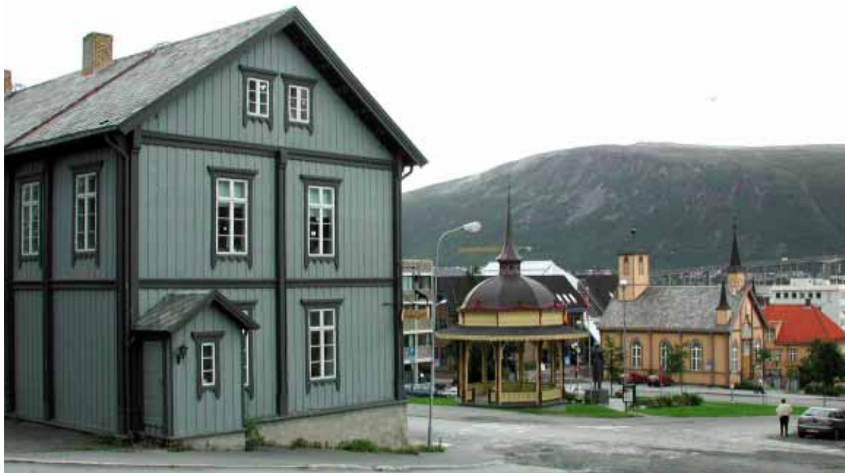
1902-0115-033, 058. Rundt Rådhusparken i Tromsø ligger mange sentrale bygninger fra byens mer offentlige historie. De har ulike grader av formelt vern. "Rådstua", det gamle rådhuset fra 1863 nærmest. Musikkpaviljongen fra 1890 har hatt en omflakkende tilværelse siden 1960-tallet, men ble i 1995 flyttet tilbake sin opprinnelige plass. Nedenfor ligger den katolske kirken og tilhørende bispegård.
