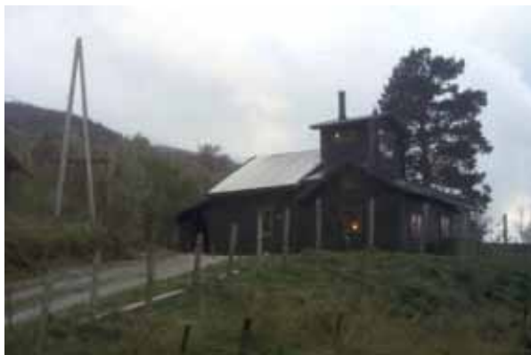
1902-3105-043. Våningshuset på Hjelnesbukta i Ramfjorden er totalt ombygd siden registreringen i 1992. Det har fått et stort tilbygg mot nord, ny liggende panel, nye vinduer, papp på taket og "tårn". Endringene klassifiserer til endringstype A.
