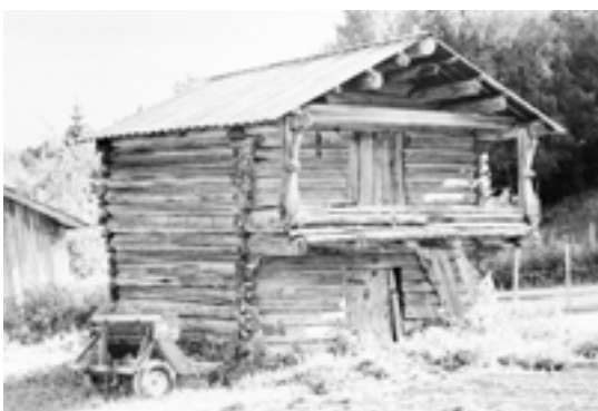
0542-023-049. Stabbur med loft på Krøssjordhaug i Abjørsbygd. Huset er et av de eldste i materialet, trolig fra 16–1700-tallet, med gammel dekor bevart, bl.a. på dørbladene. Torvtaket var svært nedslitt ved SEFRAK-registreringen og huset har siden fått nytt bordtak. Endringen er klassifisert som endringstype C.
