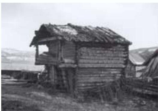
0542-023-049. Stabbur med loft på Krøssjordhaug i Abjørsbygd. Huset er et av de eldste i materialet, trolig fra 16–1700-tallet, med gammel dekor bevart, bl.a. på dørbladene. Torvtaket var svært nedslitt ved SEFRAK-registreringen og huset har siden fått nytt bordtak. Endringen er klassifisert som endringstype C.
