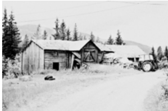
0542-020-082. Låven på småbruket Gottenborg i Bjørge hadde sval (skåle) i bindingsverk på langsida mot tunet. Fra slutten av 1800-tallet ble slike svaler vanlige i Nord-Aurdal. I dag er denne svala fjerna, endringen er klassifisert som endringstype B.
