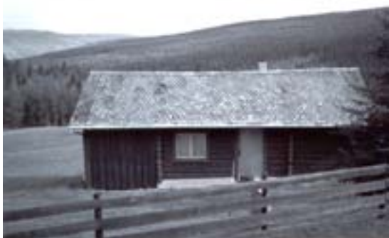
0542-023-093. Selet på Moe-Lie i Åbjørshemåsen, hadde skifertak ved registreringen i 1978. Skifting av taktekke er den mest vanlige endringen i endringstype C, og svært ofte gjelder det utskifting av gamle skifertak med nyere platetekke. Husene bevarer, men karakterendringen er merkbar.
