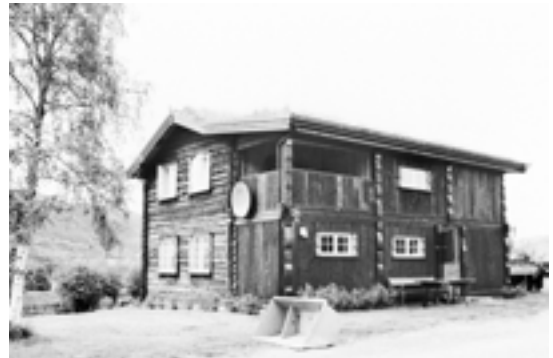
0542-022-065. Gamlebygningen på Rotehaugen i Vestringsbygdi var ikke bebodd under SEFRAK-registreringen. I 1995 ble det tatt helt ned og bygd opp med tilbygg i "svalgangsform" langs hele tunsida. Det ble satt inn enkelte nye vinduer og tekt med torvtak, ved SEFRAK-registreringen var det rester av lappheller. Selv om endringen mot tunet er stor, framstår huset i hovedsak i sin gamle skikkelse mot bygda. Endringen er klassifisert som B.
