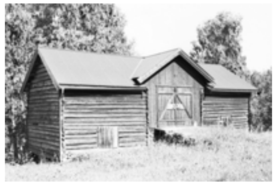
0542-023-032. Låven på Haugen i Åbjørbygdi er en klassisk tredelt tømmerlåve med kjørebru midt på. Etter SEFRAK-registreringen er skjifertaket skiftet ut med plater og det har kommet et takløft over låvebrua. Huset er klassifisert som endringstype C.
