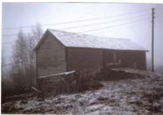
0542-023-032. Låven på Haugen i Åbjørbygdi er en klassisk tredelt tømmerlåve med kjørebru midt på. Etter SEFRAK-registreringen er skjifertaket skiftet ut med plater og det har kommet et takløft over låvebrua. Huset er klassifisert som endringstype C.
