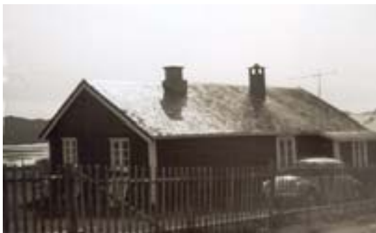
0542-002-014. Sel Rognås-stølen, Langstølene i Ulnes sameige. Selet, som skal være fra slutten av 1800-tallet, har trolig vært ombygd og påbygd flere ganger. Etter SEFRAK-registreringen har det fått et større utbygg i vinkel, ny kledning m.m. og lapphellene er erstattet med shingelpapp. Endringen er klassifisert som endringstype B.
