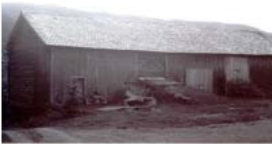
0542-007-025. Den store tømmerlåven på Strond var ikke i bruk ved registreringen i 1981. Siden er den bygd om til redskapshus. Endringene gjelder først og fremst tunsida, der låvebrua er fjernet og det er bygd garasjeporter. Sida mot bygda er uendret. Skifertaket er skiftet ut med bølgeblekk. Endringen er vurdert som endringstype C.
