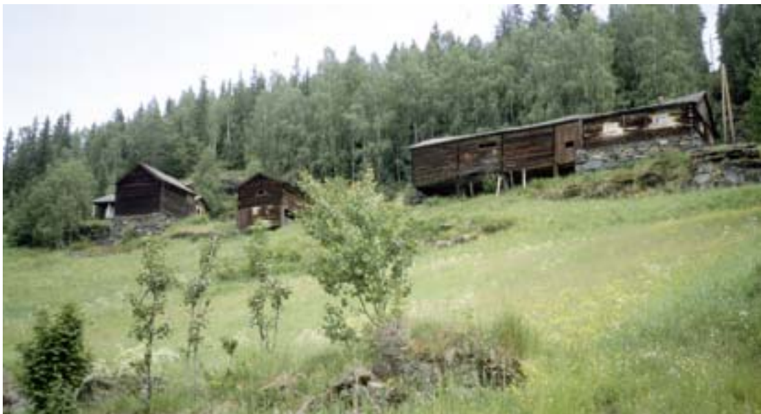
0542-012-179. Ton i Skrautvål. Her er mange, bygninger og hustyper fra et eldre sjikt enn vanlig, men stedet er fraflytta, jordveg og hus forfaller.
