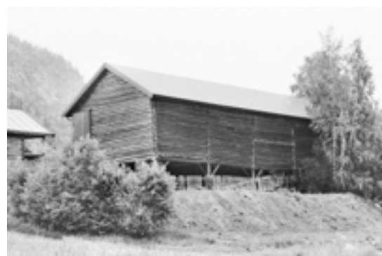
0542-007-025. Den store tømmerlåven på Strond var ikke i bruk ved registreringen i 1981. Siden er den bygd om til redskapshus. Endringene gjelder først og fremst tunsida, der låvebrua er fjernet og det er bygd garasjeporter. Sida mot bygda er uendret. Skifertaket er skiftet ut med bølgeblekk. Endringen er vurdert som endringstype C.
