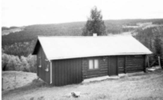
0542-023-093. Selet på Moe-Lie i Åbjørshemåsen, hadde skifertak ved registreringen i 1978. Skifting av taktekke er den mest vanlige endringen i endringstype C, og svært ofte gjelder det utskifting av gamle skifertak med nyere platetekke. Husene bevarer, men karakterendringen er merkbar.
