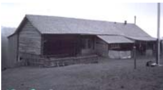
0542-023-027. Driftsbygningen på Haugene i Åbjørsbygdi hadde ved SEFRAK-registreringen en klassisk tredelt tømmerlåve, med fjøs som en forlengelse i den ene enden – under samme takhøyde (bildet til venstre). I 1982 ble det gamle fjøset erstattet av et nytt sauefjøs på samme plass (bildet til høyre), men med andre dimensjoner. Den gamle tømmerlåven forble uendret. Endringen som helhet er klassifisert som B.
