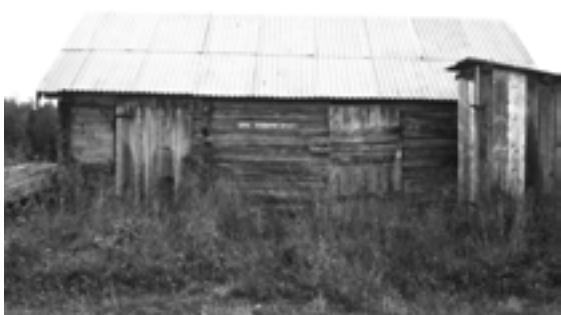
0542-012-084. Fjøs på Nedre Leirstølen, ved Leirin. En gammel vedskåle med halvtak er erstattet av et nytt tilbygg i endeveggen. Ellers er huset uendra, men i standsatt. Endringene er klassifisert som endringstype B.
