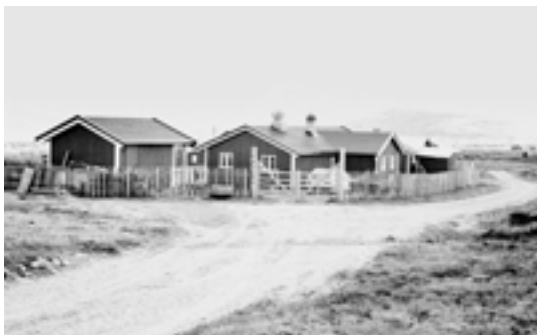
0542-002-014. Sel Rognås-stølen, Langstølene i Ulnes sameige. Selet, som skal være fra slutten av 1800-tallet, har trolig vært ombygd og påbygd flere ganger. Etter SEFRAK-registreringen har det fått et større utbygg i vinkel, ny kledning m.m. og lapphellene er erstattet med shingelpapp. Endringen er klassifisert som endringstype B.
