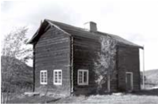
0542-022-065. Gamlebygningen på Rotehaugen i Vestringsbygdi var ikke bebodd under SEFRAK-registreringen. I 1995 ble det tatt helt ned og bygd opp med tilbygg i "svalgangsform" langs hele tunsida. Det ble satt inn enkelte nye vinduer og tekt med torvtak, ved SEFRAK-registreringen var det rester av lappheller. Selv om endringen mot tunet er stor, framstår huset i hovedsak i sin gamle skikkelse mot bygda. Endringen er klassifisert som B.
