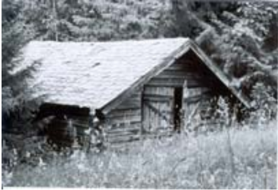
0542-019-107. Utløe på Nørre Åvåk. I 1989 ble to mindre engstykker slått sammen og dyrka opp, og den gamle løa revet. Noen av de gamle utløene har gått tapt på denne måten.
