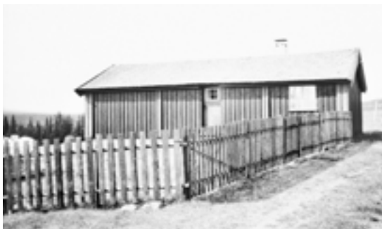
0542-023-153. Sel på Fugleistrøen, Åbjørstølan. Et par år etter registreringen i 1978 ble huset pusset opp, med full utskifting i interiøret, oppretting av tak og vegger og nye vinduer og ytterkledning. Det gamle skifertaket ble beholdt og husets størrelse og form er den samme. Endringen er klassifisert som endringstype C.
