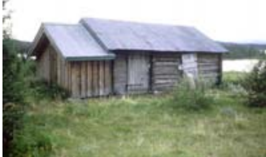
0542-012-084. Fjøs på Nedre Leirstølen, ved Leirin. En gammel vedskåle med halvtak er erstattet av et nytt tilbygg i endeveggen. Ellers er huset uendra, men i standsatt. Endringene er klassifisert som endringstype B.
