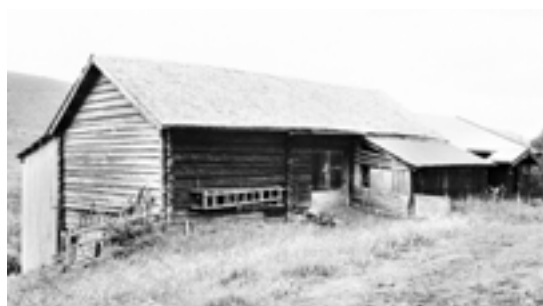
0542-011-038. Selet på Magatjednet, Ranheimsåsen skal være fra 1840-årene. Stølen ble brukt som hytte og slåtteplass ved SEFRAK-registreringen. Siden da er husene satt i stand, det er lagt ny skifer på taket og inngangspartiet, der det før var et lite takløft, er bygd ut med en "n asasval" av tradisjonell type. Endringen er klassifisert som B.
