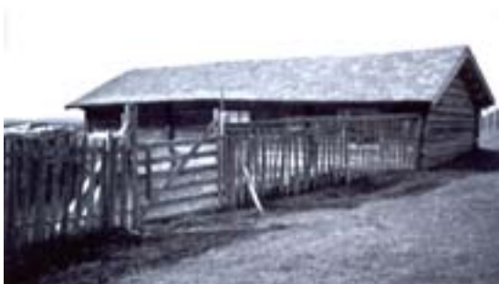
0542-023-153. Sel på Fugleistrøen, Åbjørstølan. Et par år etter registreringen i 1978 ble huset pusset opp, med full utskifting i interiøret, oppretting av tak og vegger og nye vinduer og ytterkledning. Det gamle skifertaket ble beholdt og husets størrelse og form er den samme. Endringen er klassifisert som endringstype C.
