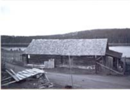
0542-022 145. Fjøs på Gjølækstølen i Vestringsbygdi sameige. Fjøset var i drift ved SEFRAK-registreringen. Det er bygd på med ny fjøsdel i lengderetning, den gamle delen er intakt. Endringen er klassifisert som endringstype B.
