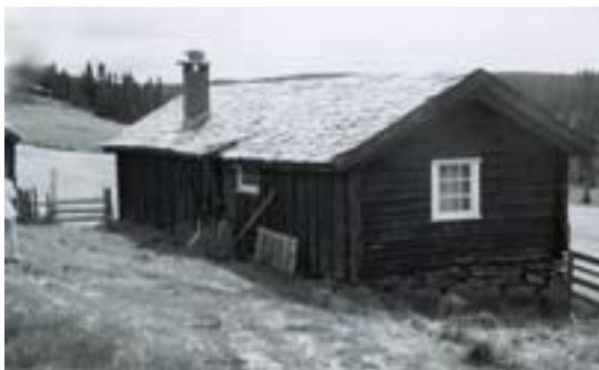
0542-011-038. Selet på Magatjednet, Ranheimsåsen skal være fra 1840-årene. Stølen ble brukt som hytte og slåtteplass ved SEFRAK-registreringen. Siden da er husene satt i stand, det er lagt ny skifer på taket og inngangspartiet, der det før var et lite takløft, er bygd ut med en "n asasval" av tradisjonell type. Endringen er klassifisert som B.
