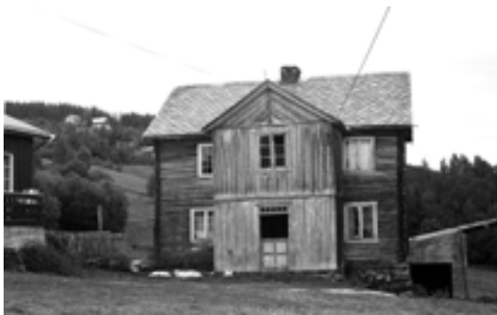
0542-001-049. "Bygningen" på Oppheim i Ulnes. Da det skulle bygges nytt bolighus midt på 1980-tallet ble det gamle våningshuset solgt for nedrivning og flytting. Det revne huset skiftet deretter flere eiere, og det er i dag uvisst om det er satt opp. Lignende opplysninger ble gitt for flere av husene som er tatt ned for flytting.
