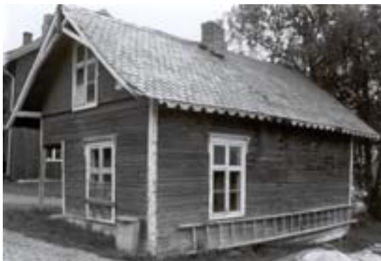
0542-018-045. "Susen" sto ved skystasjonen Frydenlund og var kombinert ishushus, serverings- og overnattingshus for skysskarene. Det kom siden i veien for atkomsten til et nytt hus i området og ble vedtatt fjernet. På dugnad i regi av laget "Verne-Vøla" ble det flytta til Valdres Folkemuseum i 1989, og inngår i dag i hussamlingene til museet.
