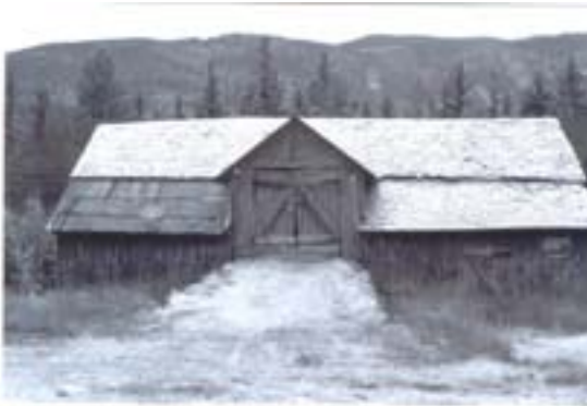
0542-020-082. Låven på småbruket Gottenborg i Bjørge hadde sval (skåle) i bindingsverk på langsida mot tunet. Fra slutten av 1800-tallet ble slike svaler vanlige i Nord-Aurdal. I dag er denne svala fjerna, endringen er klassifisert som endringstype B.
