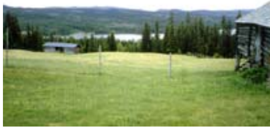
0542-023-149. Lør på Bruhalltrøe, Åbjørstølan. Den består av to løer satt mot hverandre, med åpen skut til lessing av høy i mellom. Løetypen er karakteristisk for stølene i Nord-Aurdal. Lør ble registrert i 1978 og har siden skiftet det gamle skifertaket med plater. Endringen er klassifisert som endringstype C.
