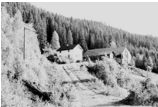
0542-004-048. På Gausaker i Lo er stuebygningen pusset opp med nytt taktekke og kledning m.m. Den brukes som bolig, mens driftsbygningen er sterkt preget av manglende funksjon og forfall.
