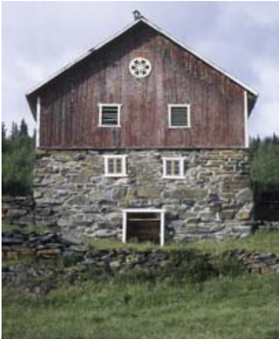
Til venstre: Låve i Skrautvål. Det skjedde en stor fornyelse av driftsbygningene i Nord-Aurdal rett etter 1900. De fleste av de mest karakteristiske sveitserlåvene, med for eksempel steinfjøs og Valdresrose i gavlfeltet er ikke registrert og derfor heller ikke med i MOV-undersøkelsen. Det ble bygd mange slike i de første tiåra av 1900-tallet. Flere står ennå, og er markante i gårdslandskapet i bygda.
