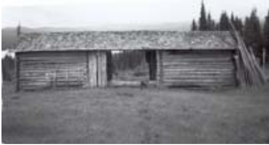
0542-023-149. Lør på Bruhalltrøe, Åbjørstølan. Den består av to løer satt mot hverandre, med åpen skut til lessing av høy i mellom. Løetypen er karakteristisk for stølene i Nord-Aurdal. Lør ble registrert i 1978 og har siden skiftet det gamle skifertaket med plater. Endringen er klassifisert som endringstype C.
