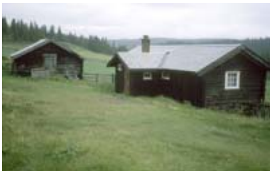
0542-011-038. Selet på Magatjednet, Ranheimsåsen skal være fra 1840-årene. Stølen ble brukt som hytte og slåtteplass ved SEFRAK-registreringen. Siden da er husene satt i stand, det er lagt ny skifer på taket og inngangspartiet, der det før var et lite takløft, er bygd ut med en "n asasval" av tradisjonell type. Endringen er klassifisert som B.
