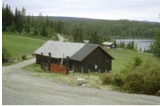
0542-022 145. Fjøs på Gjølækstølen i Vestringsbygdi sameige. Fjøset var i drift ved SEFRAK-registreringen. Det er bygd på med ny fjøsdel i lengderetning, den gamle delen er intakt. Endringen er klassifisert som endringstype B.
