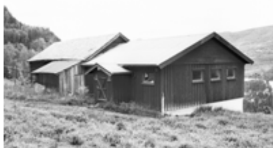
0542-023-027. Driftsbygningen på Haugene i Åbjørsbygdi hadde ved SEFRAK-registreringen en klassisk tredelt tømmerlåve, med fjøs som en forlengelse i den ene enden – under samme takhøyde (bildet til venstre). I 1982 ble det gamle fjøset erstattet av et nytt sauefjøs på samme plass (bildet til høyre), men med andre dimensjoner. Den gamle tømmerlåven forble uendret. Endringen som helhet er klassifisert som B.
