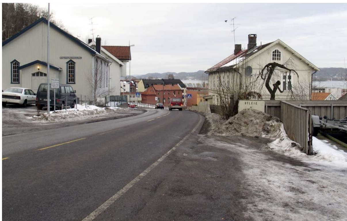
Nyveien erstattet Søndre Klev i 1860, og ble da den viktigste innfartsvegen fra oplandet til Holmestrand. Den er bygd etter chausséprinsippet som innebar jevnere stigning og slakere kurvatur. Nordre Klev er i dag stengt for biltrafikk og Nyveien er fortsatt den viktigste innfartsvegen til byen fra platået.
