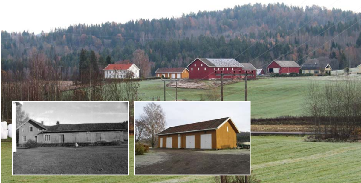
Sidebygningen på Nedigården Hegg besto ved registreringen av en drengestue på halvannen etasje, bygd sammen med en lang fløy med bryggerhus og diverse skjul og uthus. Den utgjorde "baksida" i firkanntunet. Huset sto for fall, og bare deler av uthusfløyen var i bruk. I dag er drengestua og bryggerhuset revet, mens uthusfløyen er pusset opp med opprinnelig materialvalg. (0702-310-023)
