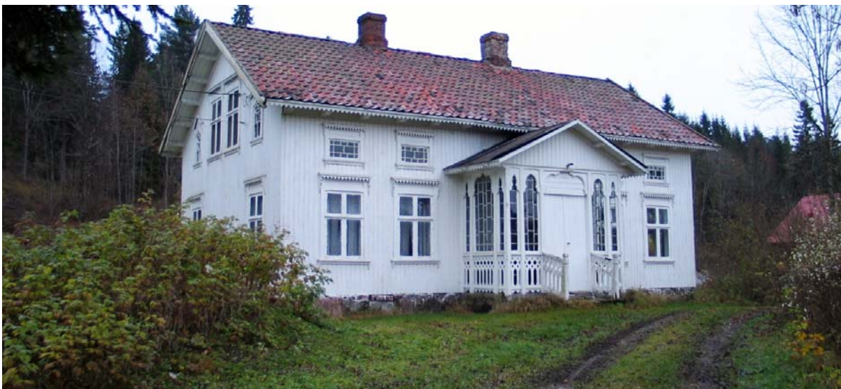
Våningshuset på Solberg Mellom er et særlig forseggjort og midtgangshus i sveitserstil fra ca. 1890. Mange våningshus på gårdsbruk i Botne er bygd etter denne lesten. Få er bevart i så opprinnelig stand. (0702-302-016)
