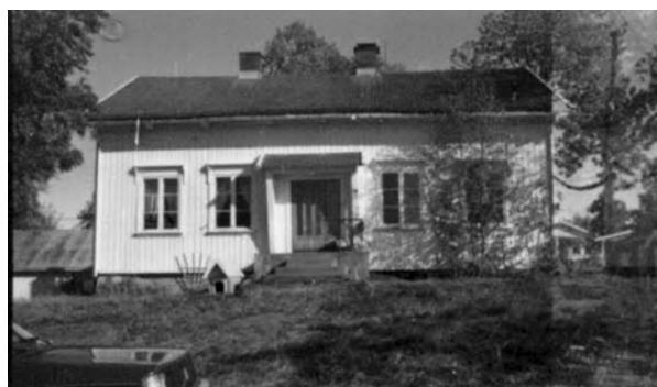
Gjøklepp ligger i randsonen for tettbebyggelsen mot jordbruksbeltet på plataet og eies av kommunen. Framhuset var et tradisjonelt midtgangshus med bryggerhusfløy. Det var delt i flere utleieleiligheter ved registreringen i 1991. Huset er i dag revet, andre hus i tunet brukes til undervisningsformål. (702-210-001)
