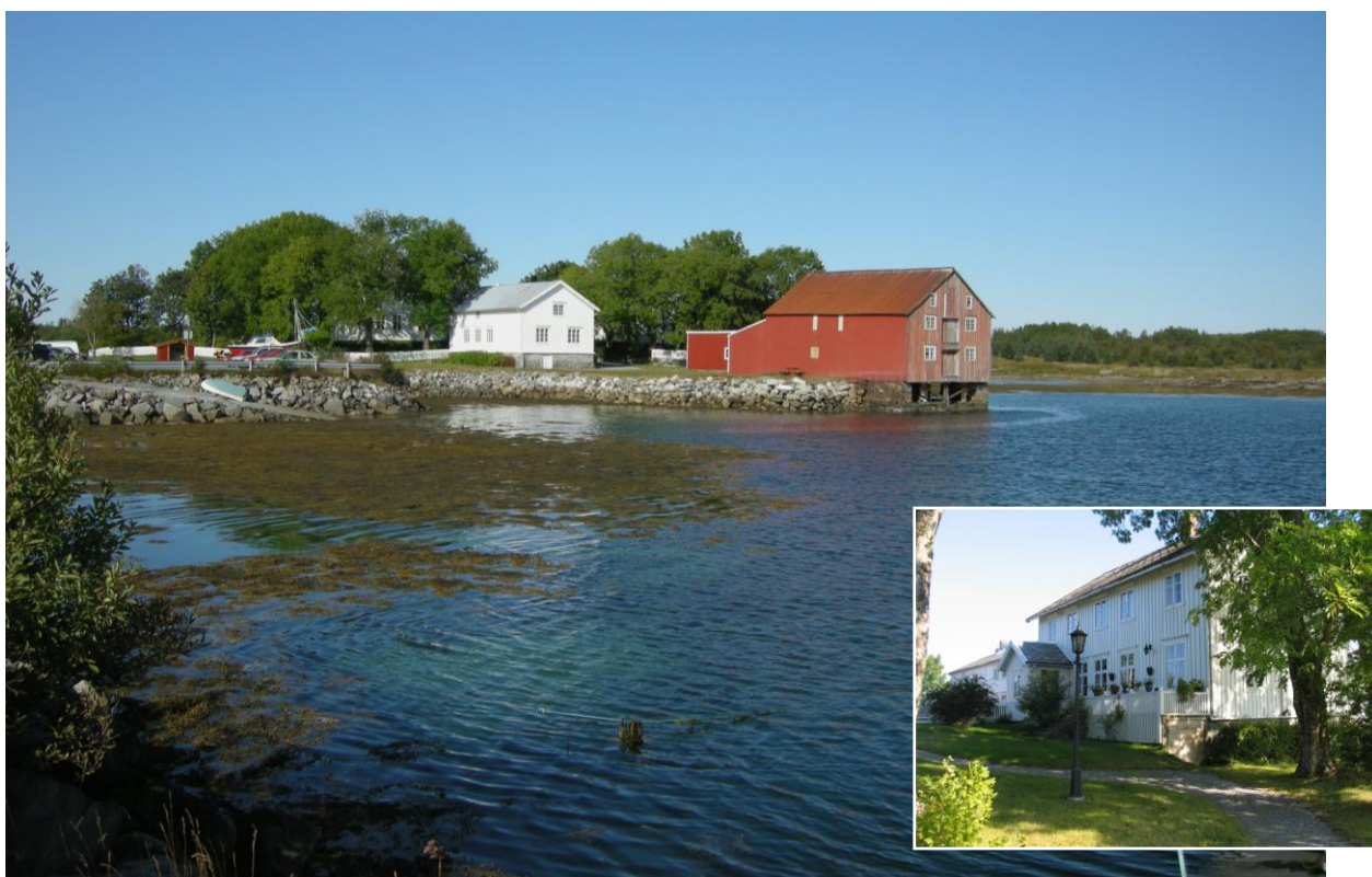
Fra handelsstedet Rørøy, brygge og butikk (1815-103-002,012). Brygga har fått støtte fra Norsk Kulturminnefond til reparasjon av en av de kraftige steinpilarene. De gamle handelsstedene er i kommuneplanen nevnt som ei gruppe som bør tas hånd om. Innfelt det yngste våningshuset fra 1860, rekkverket er fornyet siden 2003.
