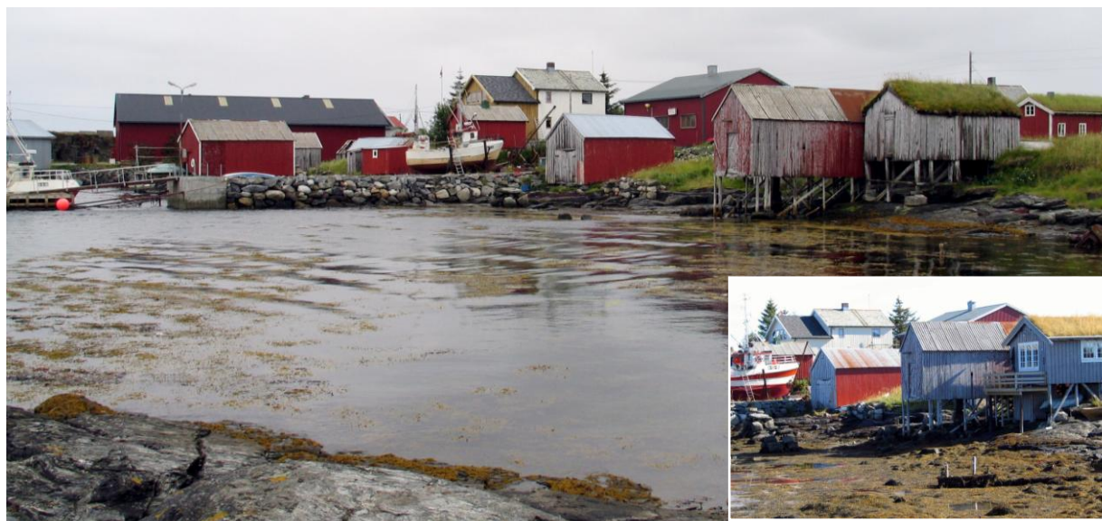
1815-108-045. Det store bildet viser situasjonen i 2003. Den lille brygga til høyre i bildet er siden da blitt ombygd, dvs. bindingsverkdelen er revet, men tømmerkjerna er bevart og pusset opp og vinduer satt inn. Endringsgraden ligger mellom A og B, og endringstype B er valgt. Miljøet ligger på nordsiden av Vegaøya.
