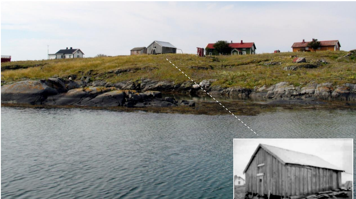
1815-110-020. Fjøset på Mudvær viste seg å være for dårlig til å settes i stand, i 2008 var det revet. Foto over fra 2003, til høyre fra registreringen i 1992..
