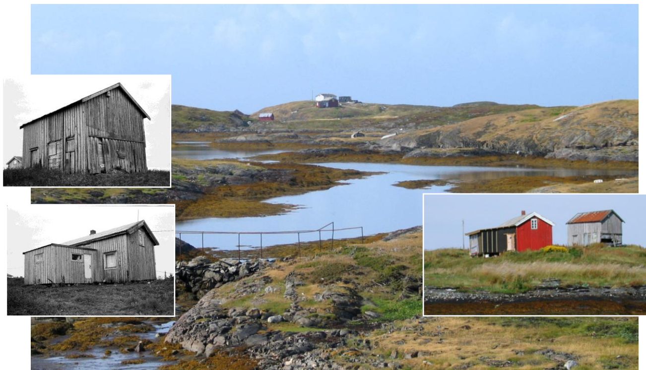
Ytterøya Hysværøyan (1815-110-090-092). Et av bolighusene var pusset opp i 2003, det andre under utbedring. Driftsbygningen som ikke hadde vært i bruk på lenge, var i dårlig stand. I 2008 var tilstanden forverret, taktekket borte, og den er nå definert som ruin i undersøkelsen. Innfelte foto (til venstre) viser situasjonen ved SEFRAK-registrering i 1992, til høyre fra undersøkelsen i 2003. Det viser det ene bolighuset under oppussing, og driftsbygningen.
