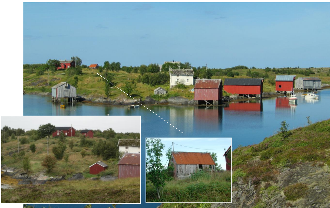
1815-107-045. Skott ved Hogsetsundet. Opplysningene om huset er sparsomme, ved registreringen i 1991 var det ute av bruk, og i 2003 sto det alene tilbake sammen med våningshuset. Øvrige hus i tunet var revet eller i ruin (stort foto og innfelt til høyre). I 2008 var våningshuset pusset opp, men skottet ryddet bort og nytt uthus bygd på stedet (innfelt foto til venstre). (Skott er lagerhus som inngår i kategorien "Mindre uthus i og nær tunet")
