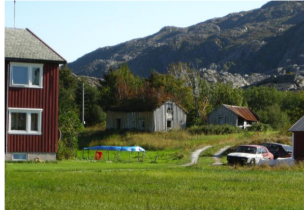
Eldste generasjon våningshus og stabbur (1815-109-012, 013) på Kjelkedalen. Begge husene var ute av bruk ved SEFRAK-registreringen 1988, og ble alt da betegnet å være i dårlig stand. Våningshuset er antatt å være fra slutten av 1700-tallet eller begynnelsen av 1800-tallet, stabburet fra begynnelsen av 1800. Bolighuset til venstre er fra slutten av 1800, men ble totalt ombygd da det ble flyttet hit i 1950-årene.
