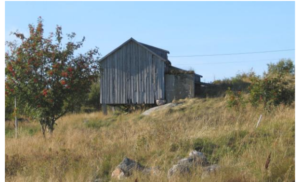
1815-103-030. Fjøs (driftsbygning) som har vært brukt som lager for ved og diverse i noen år. Kledningen er svært dårlig. Den tilbygde sisternen har torv på taket. Det er flere eksempler på vannsisterner i Vega-materialet, særlig tilknyttet våningshus, men også driftsbygninger.
