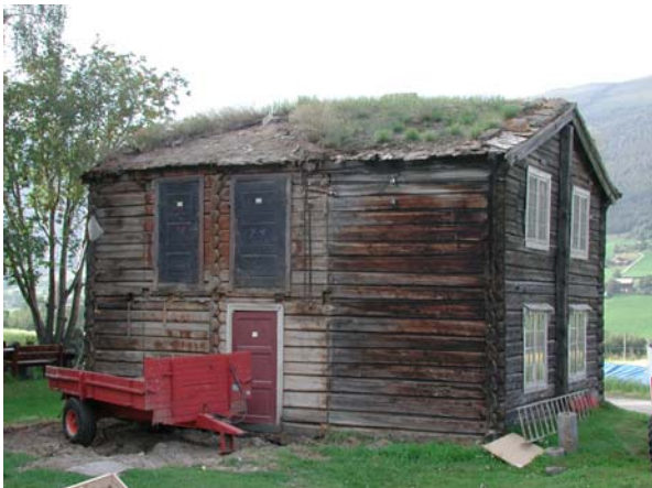
0513-004-036. Gammelstugua på Nigard Dagsgård står for tur til å pusses opp. Gangen i bindingsverk er nettopp revet. Hus under endring inngår som "står, endringsstatus ukjent" i undersøkelsen.
