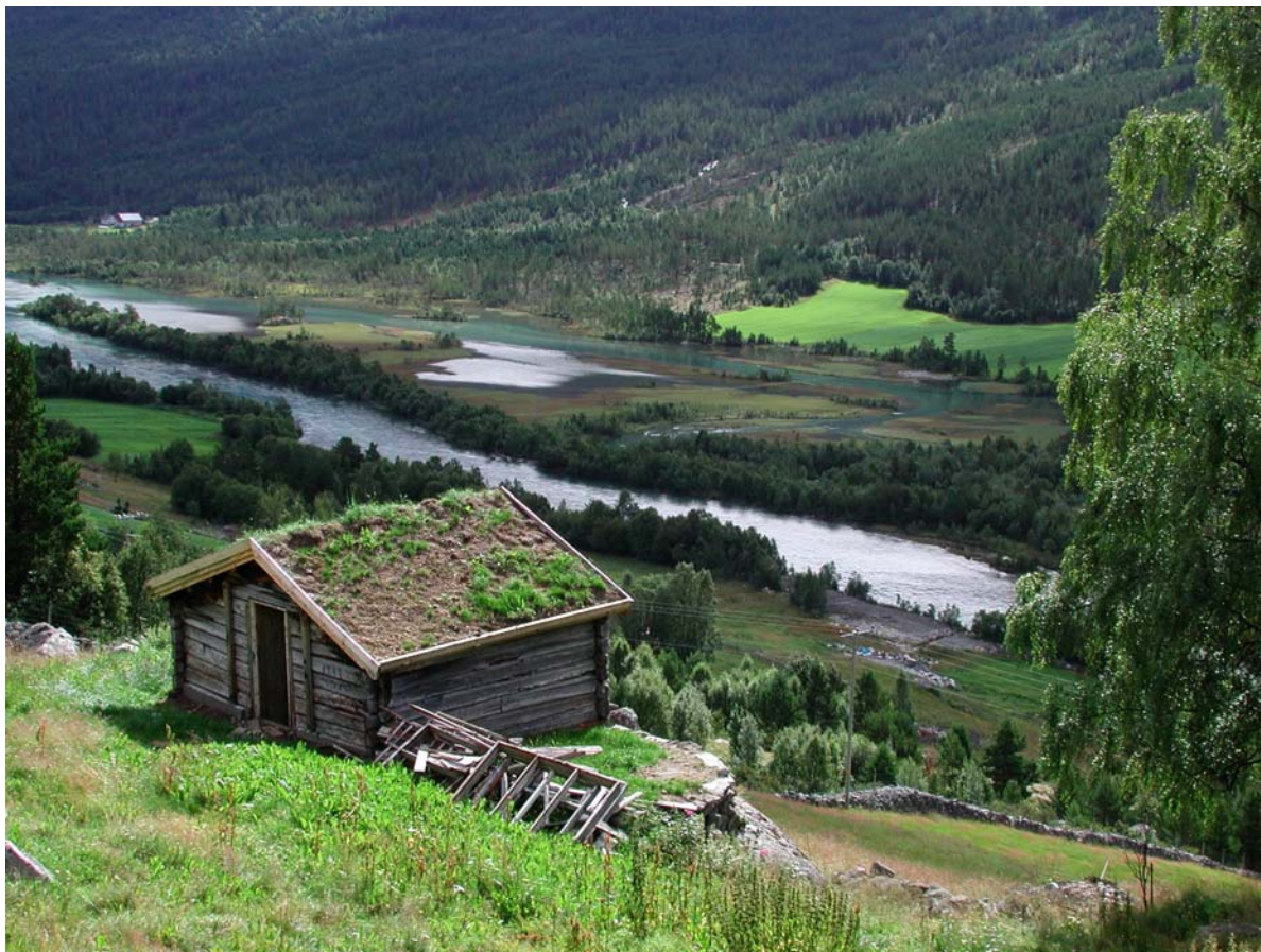
0513-010-100. Torvtaket på tørrstugu til Lillerust i Bråtagrendi var nettopp fornyet sommeren 2002.
