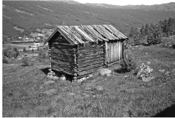
0513-008-078. Småbruket Espeset, i lia over Dagsgårdsøy garden, var gått inn i hovedbruket igjen alt på 1930-tallet. Ved registreringen i 1979 var stedet i bruk som havnehage. Stabbur og løe sto ute av bruk og i forfall. I dag er bare tuftene tilbake.
