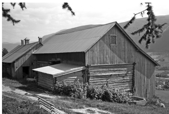
0513-003-079. Låven på Geilbakken måtte vike plassen da det skulle bygges nytt bolighus i tunet ved eierskifte sist på 1980-tallet. Det gamle våningshuset ble da kårhus for tidligere eier. Geilbakken er en av de gamle husmannsplassene øverst i lia på Solsida
