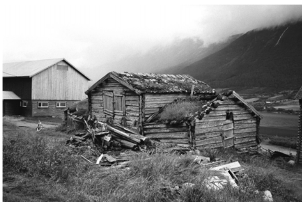
0513-002-027. Storfeffjøset på Bøje var i bruk til 1966, men sto tomt ved registreringen i 1979 og var da i dårlig forfatning. Byggestilen er spesiell med "hekk" etter lokal betegnelse, det store arkoppbygget til før. "Hekk" i ulike varianter, som utbygg og oppbygg, på fjøs, stall og låve er karakteristisk for byggeskikken i Skjåk.
