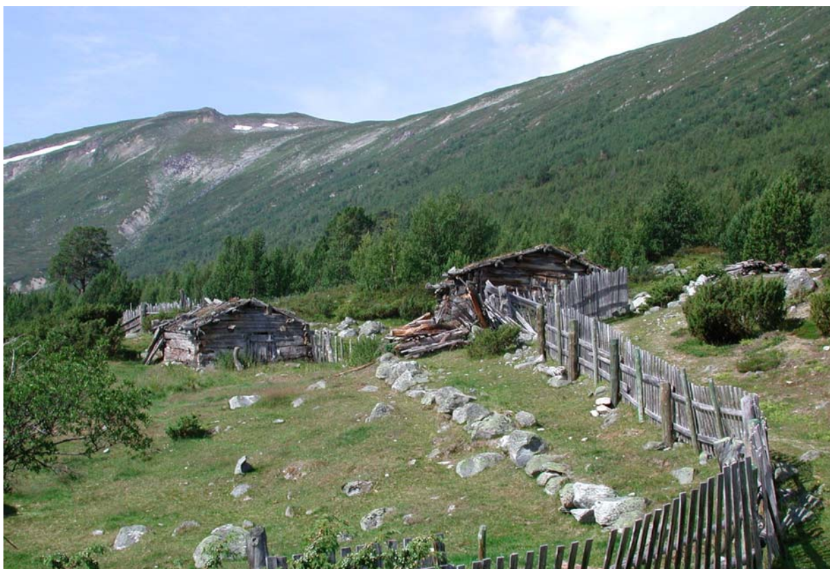
513-010-065, 066. Geitefjøsset (til venstre) og løa (til høyre) på den innerste setra på Framrusten var ute av bruk ved registreringen i 1981. I 2002 er taket og en vegg på geitefjøsset rast sammen, og huset har gått inn i undersøkelsen som tapt. Løa (til høyre) har ennå form av hus, men er sterkt truet. Det er karakteristisk at setra lengst inn og vekk fra kjørevegen er den som først blir oppgitt.
