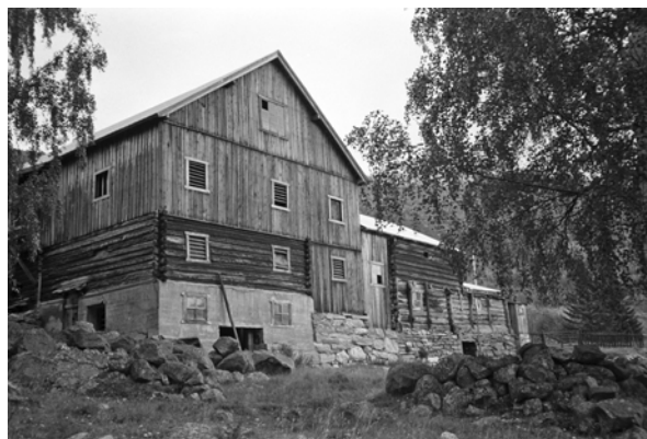
0513-007-036. Det er registrert få enhetsslåver (kombinerte driftsbygninger) i Skjåk. De som er med fikk i hovedsak sin form ved tilbygg/endringer etter 1900, slik som denne på Nedre Kittilstad. Ved registreringen i 1979 var grunnmuren begynt å sige, og huset er i dag erstattet med nytt uthus.
