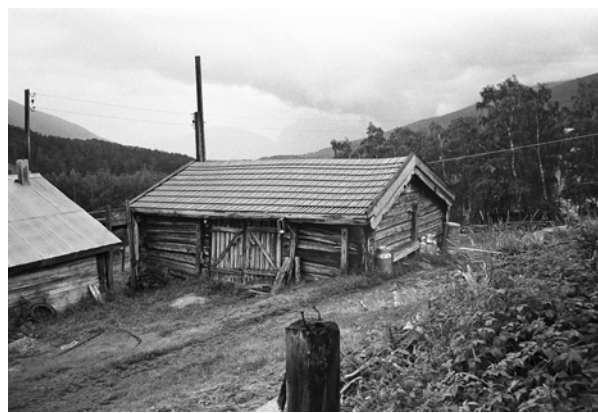
0513-007-010. Geitefjøs på Nedre Bruheim sto i vegen da det ble bygd ny driftsbygning. Fjøsset var ikke i bruk ved registreringen i 1979. Det er typisk for de mange små husene for ulike dyreslag i Skjåk-tunet, flere av disse har måtte vike plassen ved nybygging i tunet.
