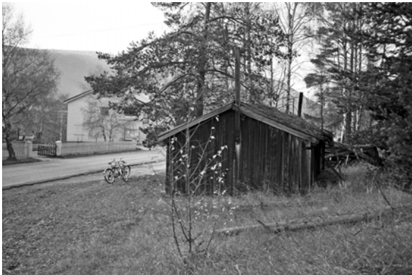
0513-006-076. Sigridstugu og Lagertestugu var to mindre bosteder nær vegen like ved Vollungsbru. Sigridstugu var ikke i bruk ved registreringen i 1978, den var i dårlig stand og er nå revet. Lagertestugu holdes i hevd som feriested. Det er registrert få småkårshus i denne kategorien i Skjåk.
