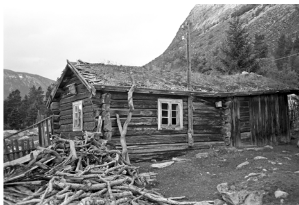
0513-011-121. Eldhuset på Øiberget ble registrert i 1981 og skal da ha vært i bruk. Det er av tradisjonell eldhustype i Skjåk, med selve eldhusrommet i laft og en skåle i bindingsverk. Huset ble revet fordi tilstanden var dårlig. Eldhus, bakstehus og tørrstuguer har tapsandeler over gjennomsnittet.
