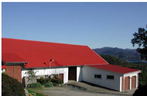
1102-034-057. Driftsbygningen på Eskeland i Høle er bygd ut med garasje ved siden av den gamle hevdaløa. Samtidig er de gamle teglpannene skiftet ut med platetekke.
