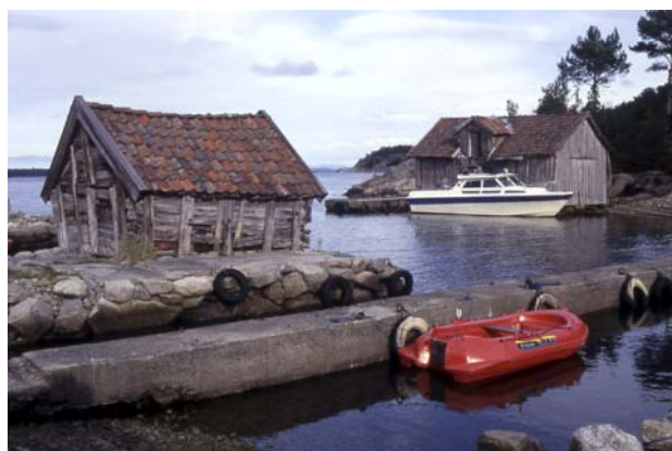
1102-030-043, 046. Lauvåsvågen, sjøbu og sjøhus. Både Strandgata 109 og Lauvåsvågen er høyt prioritert i kulturminnevernplanen og ligger i områder som er regulert til spesialområde bevaring.
