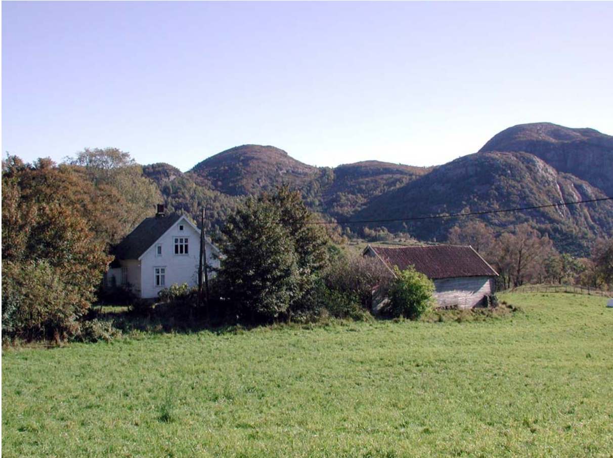
1102-029-032. Løa på den gamle husmannsplassen Heiane under Haualand i Riska var i bruk som sauehus ved registreringen i 1980, men er i dag uten funksjon. Våningshuset holdes i hevd, en typisk situasjon på mange nedlagte småbruk. Opprinnelig var løa sammenbygd med et eldre bolighus, som ble revet i 1926 da huset som står nå ble bygd.
