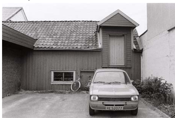
1102-001-128. Uthuset i Gjesdalvegen 15, var innrettet mot bondehandelen ved innfartsvegen mot Sandnes. Det er et typisk byuthus bygd for mange funksjoner: Stall for kundene, lager for kjøpmannen, torvhus, kjerrehus og vaskehus. Huset er i dag revet. Tapsandelen for denne typen uthus er blant de høyeste, godt over gjennomsnittet.
