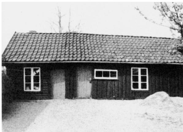
1102-017-083. Fjøs og vaskehus på "Asser-Hana" var sammen med driftsbygningen revet før 1987. Det sto i et tett firkanttun, typiske for sentrumsnære gårdsanlegg i Høyland. Tunet var alt ved registreringen omgitt av boligbebyggelse. Området er siden ytterligere fortettet.
