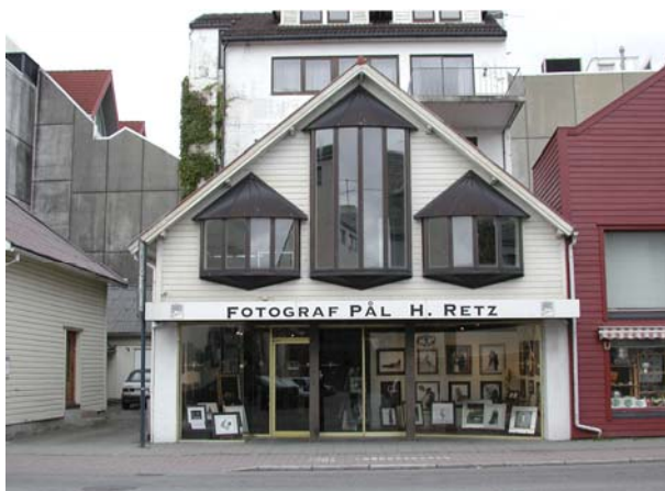
1102-001-176. St. Olavsgate 18, Sandneskasse på 1970-tallsmanér. Husets eksteriør er ikke endret siden SEFRAK-registreringen i 1984 og inngår i undersøkelsen som uendret.
