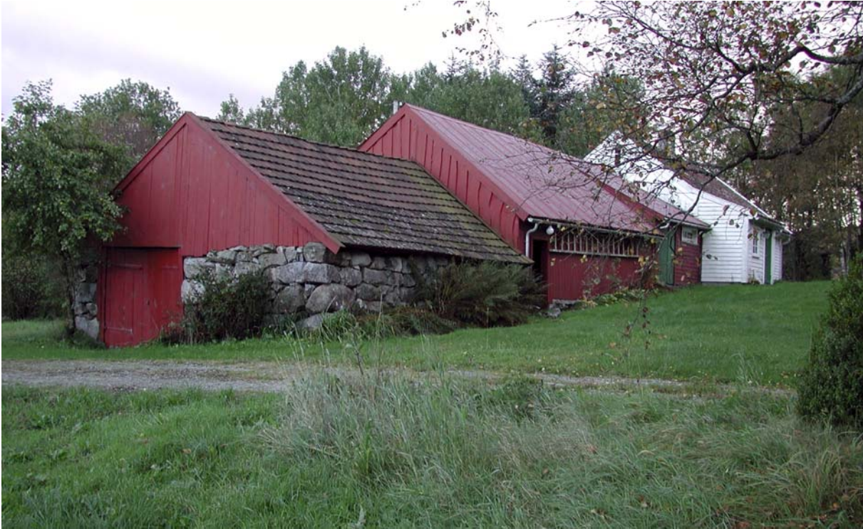
1102-006-022–025. Sammenbygd rekke av våningshus, fjøs, løe og hevdaløe på Hodl i Kjosavika, Høyland. Sammenstillingen av bolighus og driftsbygninger har lange tradisjoner i Rogaland. I registreringsmaterialet er den først og fremst dokumentert på husmannsplasser og småbruk. Hodl i Kjosavika har i dag det mest intakte anlegg av denne typen i Sandnes. Husrekka var nylig pusset opp ved registreringen i 1981, og fjøset ble da innredet til gjesterom. Anlegget er ikke endret siden den tid.
