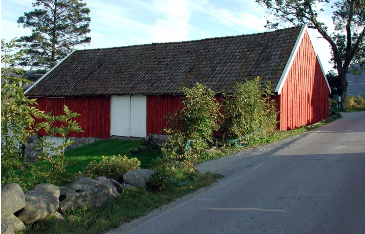
Driftsbygningene i Sandnes har stor grad av særpreget, karakterisert ved bruk av materialer som grind, stein, plankelaft, og hvordan elementene løe, fjøs, hevdaløe (el. hevdhus, rom for gjødsel) og andre rom for dyr er organisert. Denne løa i Bersagel (1102-034-026) fra 1888 er typisk. Takbærende konstruksjon er grind, mens fjøset og hevdaløa, som ligger i bakkeplan under løa til venstre, er i gråstein.
