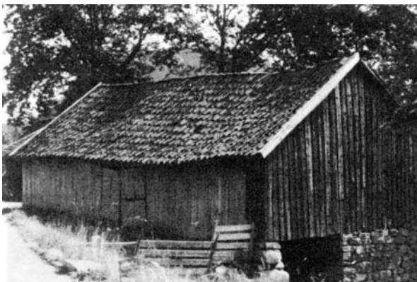
1102-030-088. Løa på Eltravåg i Riska er typisk for driftsbygningene av typen med grindabygd høyrom over hevdaløa og lafta fjøs i motsatt ende. Huset ble revet før 1987 og er erstattet av et nytt, mindre uthus i tunet.
