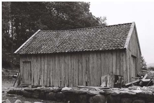
1102-030-009. Sjøhuset på bruk 2 på Usken sto for seg selv, rett nedenfor tunet. Det var en typisk del av kulturlandskapet knyttet til fiskerbøndernes bebyggelse på småbruka langs fjorden. Bua var grindabygd, men konstruksjonen sviktet, huset falt sammen. Det er ikke gjenreist, bl.a. som følge av myndighetenes restriktive holdning til bygging i strandsonen.
