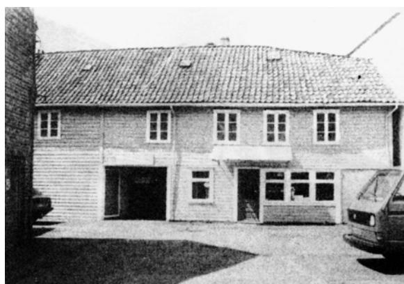
1102-001-148. Langgata 21. Smia, som sto midt i kvartalet mellom Langgata og St. Olavs gate, ble bygd i 1891 og erstattet da en eldre smie. Eierne, Torkild Raugstad, var en dyktig skips- og plogsmed og "Raugstadplogen" var et begrep på Jæren. Smia ble revet under utbyggingen av eiendommen i 1994, i forbindelse med rehabiliteringen av gårdene mot Langgata, som ledd i prosjektet "Sandnesmodellen".
