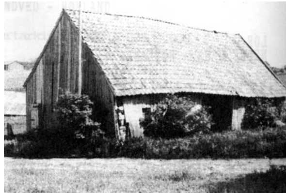
1102-021-025. Treskelåven på Austvoll i Høyland, var i opprinnelig bruk til det ble bygd ny driftsbygning i 1956. Siden ble den en tid brukt til sauefføs og grisehus og sist redskapsskjul, men var revet 2002. Den var en klassisk grindabygd løe med fire grindpar og lafta stall i det ene hjørnet. Huset sto for seg selv, litt utenfor tunet, og brukte vannkraft til treskeverket. Tapsandelen for denne typen hus er over 50 %.
