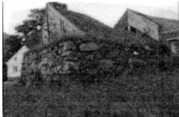
1102-006-006. Hevdaløe, Risholen i Kjosavik, Høle. Huset hadde kraftige gråsteinsmurer og sto inntil fjøset, litt lavere. Denne varianten av hevdaløa er typisk for de eldste driftsbygningene i Sandnes. Huset var dårlig ved registreringen og var revet før 1987.
