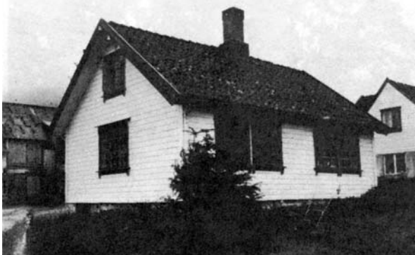
1102-008-001. Som "bolig nr. 2" i tunet i et landbruksområde måtte det eldste "heimahuset" på Sørtun Espaland i Høyland vike plassen. I dag er det to yngre bolighus i tunet. Det var typisk for bolighus med 4-delt planløsning. Langt de fleste registrerte bolighusene i Sandnes er av denne typen. Også hus som bygger på 4-delt planløsning har lange tradisjoner i regionen, men den ble mer og mer utbredt utover 1800-tallet.
