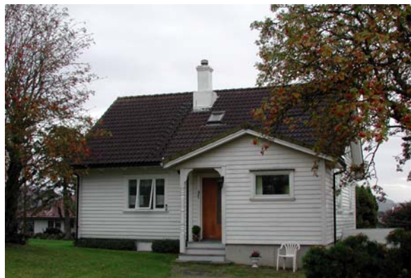
1102-020-001. Våningshus Koppholen, Høyland. Utbygg mot gårdsplassen med nytt vindfang og/eller bad m.m. er en vanlig form for påbygg av eldre bolighus.
