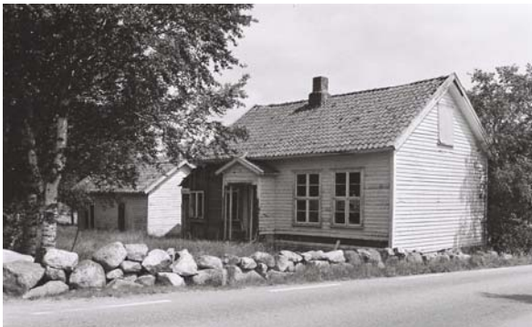
1102-008-016. "Salem", Kyles i Høylands fjellbygd. Huset var bygd som skole og bedehus, men sist i bruk kun som bedehus. Ved registreringen i 1981 var det ute av bruk, og det ble revet få år etter. Uthuset står fortsatt. Skolestuene er den gruppen av offentlige hus som har størst tapsandel i prosent – 38 %.
