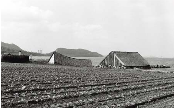
1102-027-007, 009. Naust Riskastranda. Begge naustene var revet før 1987. Det ene var grindabygd, det andre i en kombinasjon av grind og stein. Naustet til venstre var skadet av storm før registreringen.
