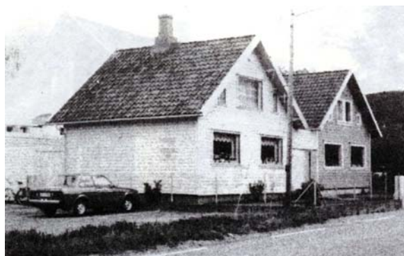
1102-019-041, 043. Langs Gravarsvegen lå før en rekke hus for arbeidere knyttet til teglverksindustrien. Ved registreringen sto kun disse to, i 2002 var bare ett tilbake (det nærmeste, 041). Begge ble bygd i 1890-åra, og representerer en hustype som ble særlig vanlig i bymiljø rundt århundreskiftet, gjerne kalt "Sandneskassa". Flere av tapene i kategorien "Bolighus" gjelder hus av denne typen.
