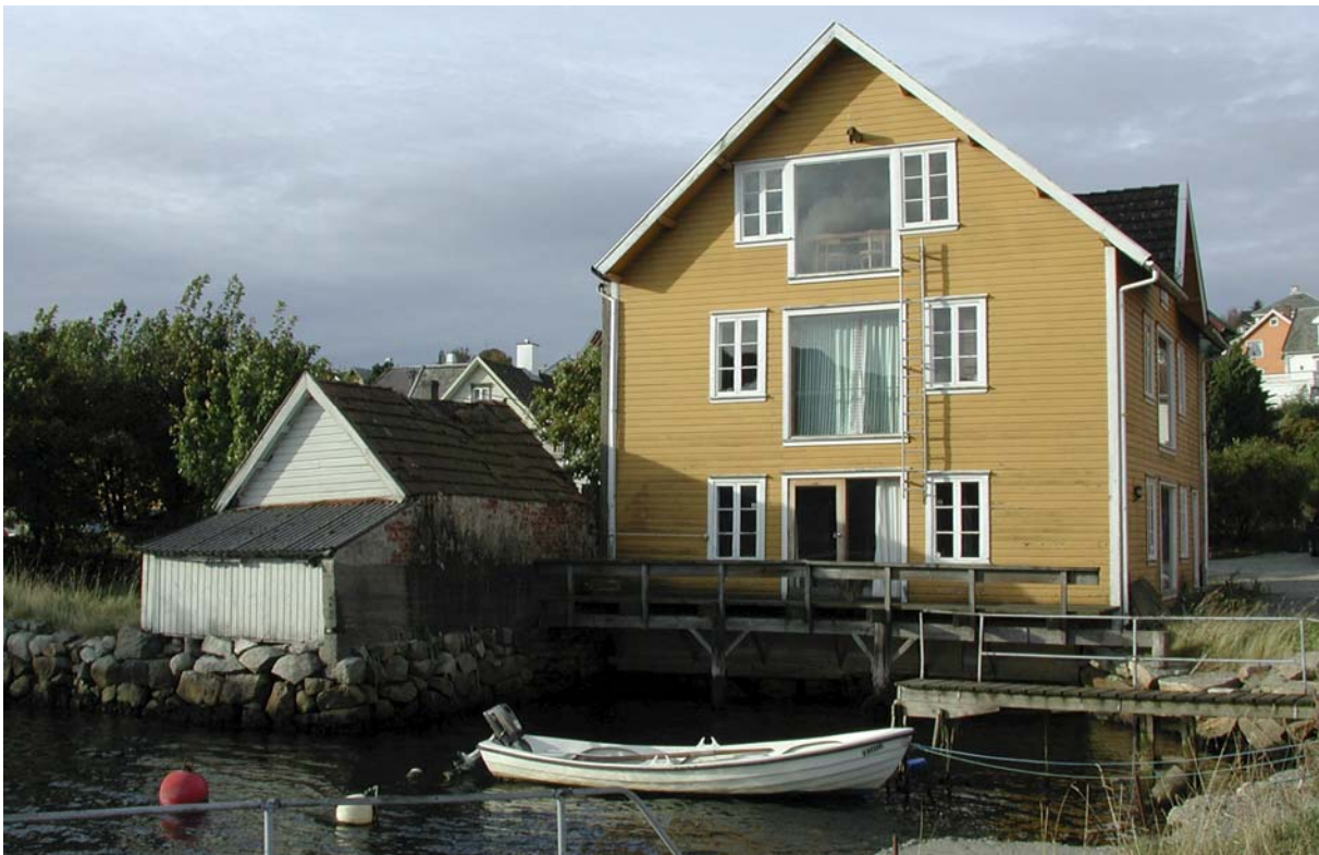
Dette sjøhuset på Simonsbakken er et av få bevarte på Norestraen, og i byen overhode. Det skal først ha vært lager for en av Sandnes større potterier, senere for en havremølle. Ved registreringen i 1983 var det innredet til arkitektkontor. (1102-001-073)
