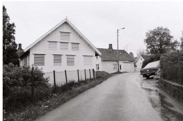
1102-020-011. Tørkehus for garveri i Alex Kiellands gate, Lunden. Garverinæringen i Sandens var ved registreringen representert ved tre næringsbygg. To står fortsatt, mens dette er revet. Området, som var preget av boligbebyggelse under registreringen, er i dag fortettet. Garveriarbeiderboligen i bakgrunnen står fortsatt.
