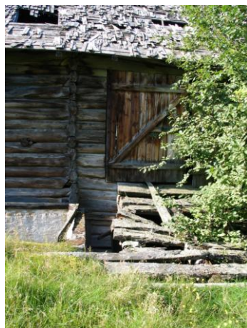
Låve på Lykre. Flistakene er spesielt utsatt og blir sjelden erstattet av nytt flistekke. (0513-007-053)
