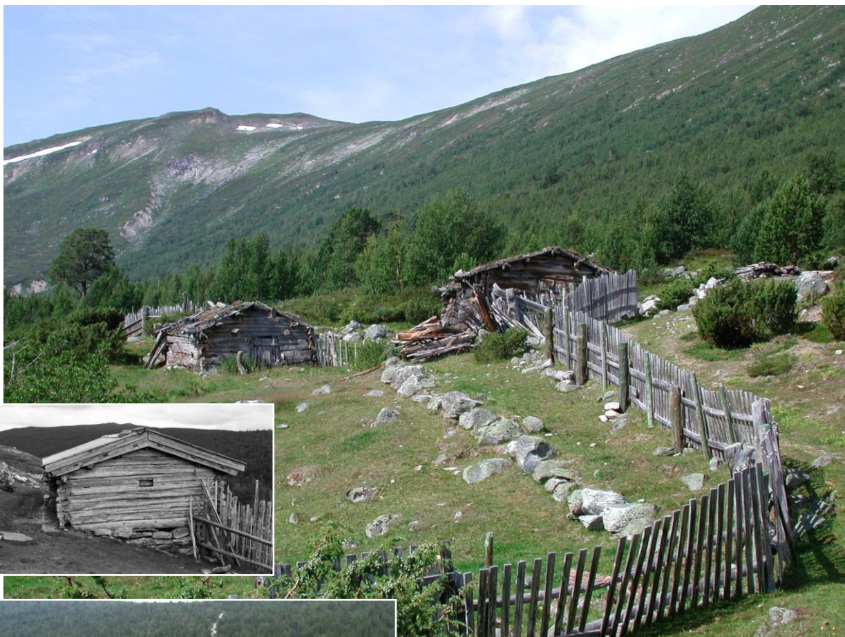
I 2002 (over) sto så vidt det ene av de to innerste seterfjøsene på Framrusten. I 2007 var taket falt inn og begge definert som ruiner. Innfelt situasjonen ved registreringen i 1981. (0513-010-065)
