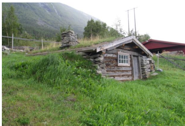
Kombinert eldhus/smie på Søre Risheim var i svært dårlig forfatning 2002. Den er nå satt i stand og ført tilbake med torvtak. (0513-001-007)
