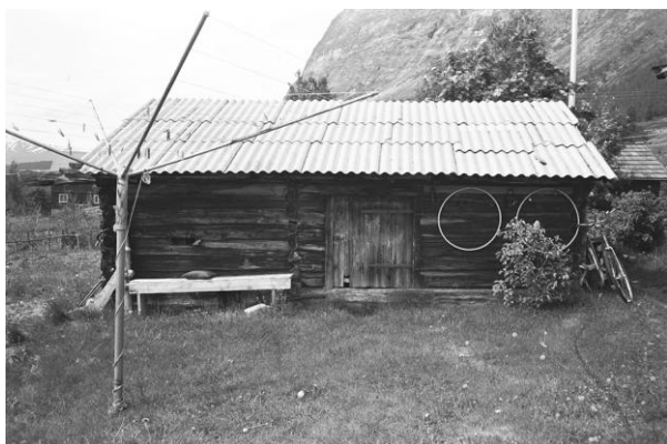
Stabburet på Moen er satt i stand siden 2002. Tidligere eksteriør er ført tilbake ved at "bølgejeterniten" den hadde ved registreringen i 1981 er erstattet med torvtak. (0513-011-084)
