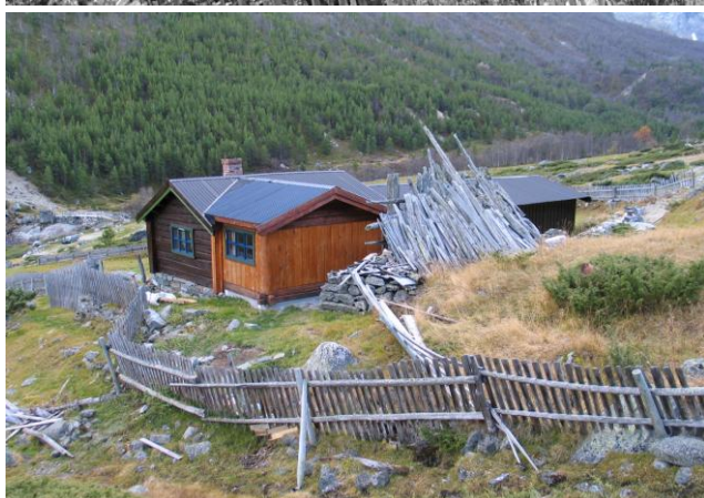
Både seterstua og det sammenbygde fjøset i Lundadalen var satt i stand ved undersøkelsen i 2002 (over) bl.a. med nye platetak. Endringsstatus var da C. Gangutbygget på seterstua, som var uendret i 2002, er i dag erstattet med nytt vinkelutbygg. Endringen er klassifisert som endringstype B. Til venstre øverst seterstua ved registreringen i 1979 (0513-005-058)
