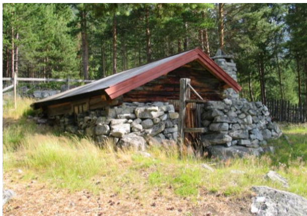
Stadier av gjenoppbygging av smia i Lesplassen. Den ble registrert som ruin i 1981, men hadde rester av tak. I 2007 er alle vegger og skorsteinen på plass. Den inngår nå som endringstype C.(0513-011-089)
