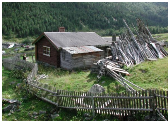
Kuffjøset på denne Sotastølen hadde delvis fått nytt tak i 2002 (foto til venstre), mens geitfjøset var så dårlig at det var revet. Seterstua var uendret. I 2007 (foto til høyre) er kuffjøset utbedret med bl.a. tekke over hele takutstikket, endringstype er C. Seterstua er under oppussing med et tilbygg ved inngangen som klassifiserer til endringstype B. (0513-010-012, 014)
