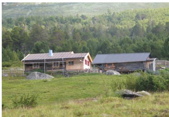
Kuffjøset på denne Sotastølen hadde delvis fått nytt tak i 2002 (foto til venstre), mens geitfjøset var så dårlig at det var revet. Seterstua var uendret. I 2007 (foto til høyre) er kuffjøset utbedret med bl.a. tekke over hele takutstikket, endringstype er C. Seterstua er under oppussing med et tilbygg ved inngangen som klassifiserer til endringstype B. (0513-010-012, 014)
