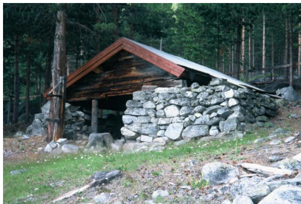
Stadier av gjenoppbygging av smia i Lesplassen. Den ble registrert som ruin i 1981, men hadde rester av tak. I 2007 er alle vegger og skorsteinen på plass. Den inngår nå som endringstype C.(0513-011-089)
