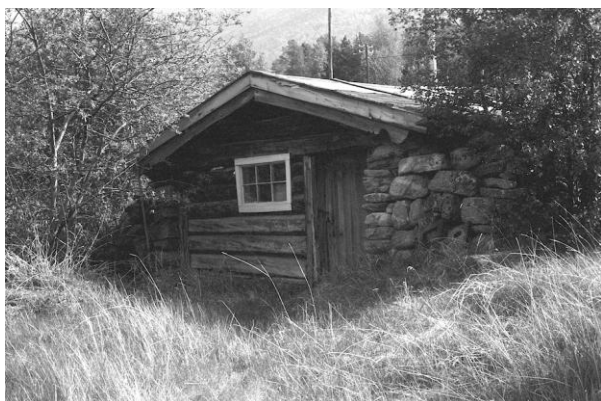
Kombinert eldhus/smie på Søre Risheim var i svært dårlig forfatning 2002. Den er nå satt i stand og ført tilbake med torvtak. (0513-001-007)
