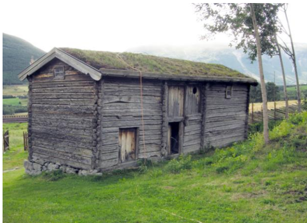
Det er tørt i Skjåk og torvtakene trenger vannning. Stabburet på Øvre Krogstad var satt i stand 2007 bl.a. med fornyet torvtekke. (0513-003-054)
