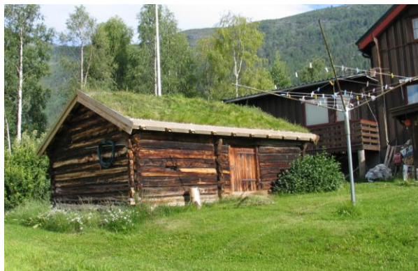
Stabburet på Moen er satt i stand siden 2002. Tidligere eksteriør er ført tilbake ved at "bølgejeterniten" den hadde ved registreringen i 1981 er erstattet med torvtak. (0513-011-084)
