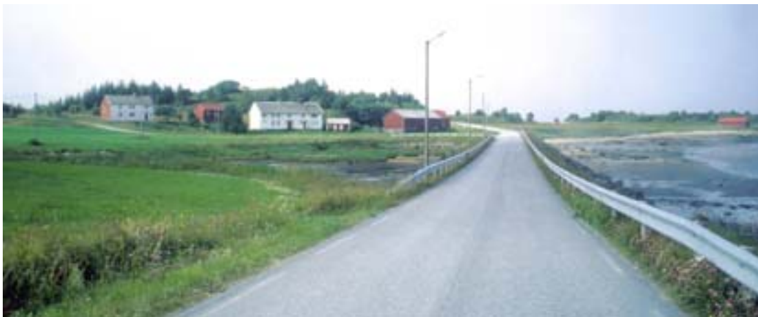
Rv. 664 på Malefeten. Husene på de to bruka ligger på rekke. Den nye vege ligger i strandkanten mellom tun og stornaustet til høyre og naustrekka til høyre utenfor bildet.
