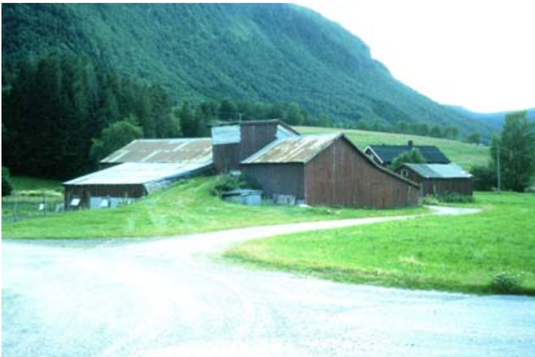
Datering av hus kan være vanskelig. Ofte består de av lag på lag, og deler kan være flytta. Denne løa i Fræna er karakteristisk for den måten mange mindre driftsbygninger i området kan være utbygd på.
