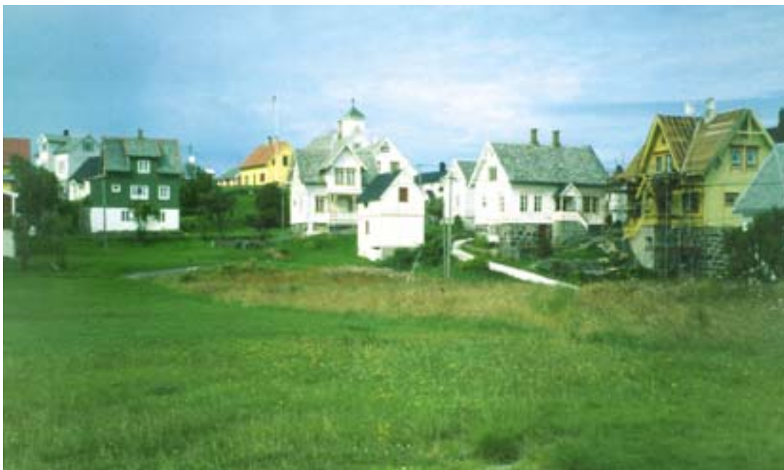
Bebyggelse fra 1900-tallet i det gamle fiskeværret Nordre Bjørnsund. Kapellet i bakgrunnen ble bygd av folket på Bjørnsund i 1907. Bjørnsundøyene er totalregistrert, og 1900-tallsbebyggelsen utgjør her en stor andel av de registrerte bygningene i krets 1. De første tiåra av 1900-tallet var gode tider for Bjørnsund, som da var et økonomisk sentrum i ytre Romsdal, og det ble særlig på Nordre Bjørnsund satt opp flere sveitserhus. Til høyre i bildet er et hus under oppussing. Tømmeret i huset skal komme fra et hus på Averøya, og ble satt opp på Bjørnsund 1909–13. Husene er nå i bruk som feriesteder.
