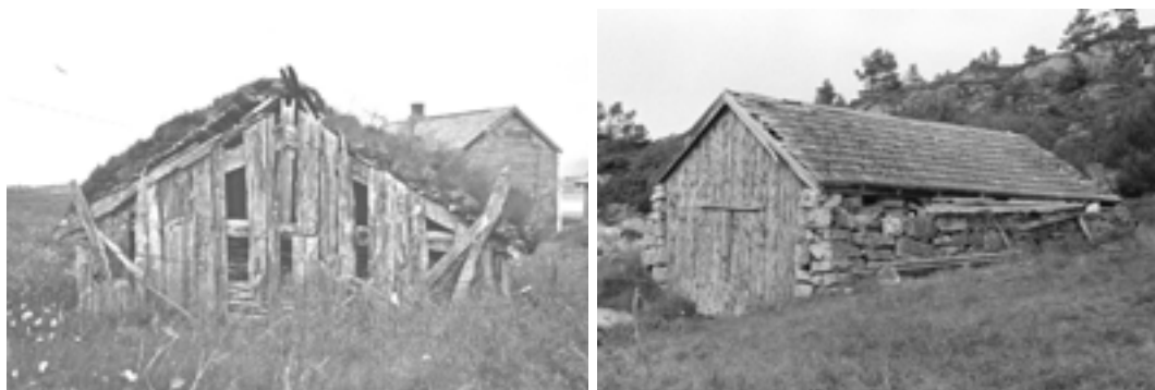
1548-023-015. Til venstre grisehus på Malefeten i Hustad, et typisk eksempel på en hustype som ikke lenger er i bruk. Ved SEFRAK-registreringen var huset i dårlig stand. I 2000 var taket ramla ned, men murene sto tilbake. Til høyre steinmaust i Storvik (1548-006-081), som også ble revet på grunn av dårlig tak. Stort sett har naust og sjøhus en mindre tapsprosent enn driftsbygninger i jordbruket, da dette er hus det fremdeles er bruk for.
