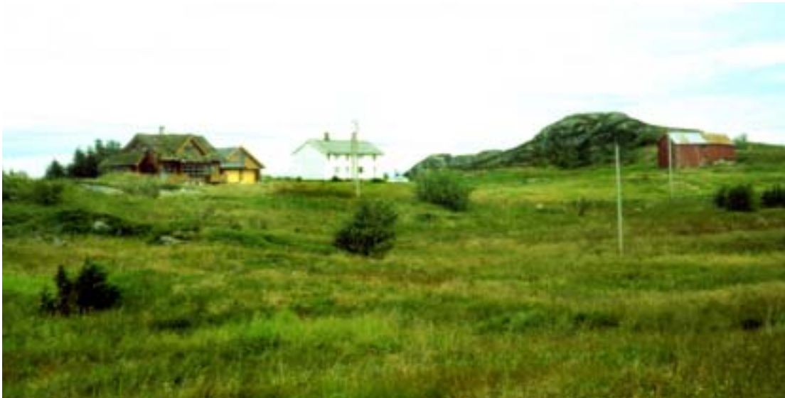
1548-014-001. Øya Drågen ble landfast i 1970 da ei steinfylling ble bygd mellom øya og fastlandet. I dag er flere av småbruka fraflytta, og jordvegen gror til. Bildet viser tunet og litt av innmarka på det nordligste bruket på øya. Ved det gamle lånet er det satt opp et nytt bolighus i stedsfremmed stil og en stor garasje.
