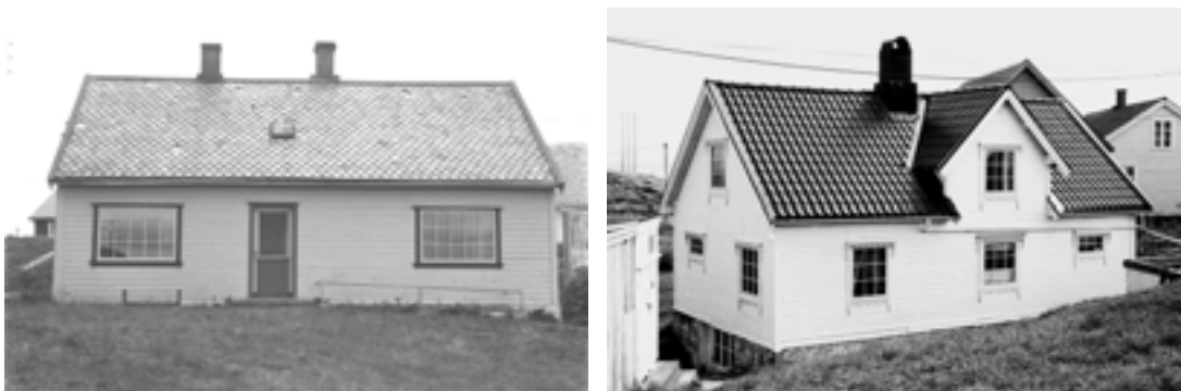
1548-001-028. "Dalahuset" på Nordre Bjørnsund, er fra ca. 1900. Skifer ble etter hvert det vanligste takbelegget på Bjørnsund. Ferskvann var her et problem, og skifertaket skal ha gjort det mulig å samle opp regnvann. Ellers ser man av bildet at det var skjedd endringer med huset før SEFRAK-registreringen. I år 2000 er skiferen skiftet ut med moderne takbelegg, og vindusbelistningen har fått sveitserdekor; en endring klassifisert som endringstype C. Flere hus på Bjørnsund har skiftet ut de gamle skifertaka. (Fotoene er tatt fra hver si langside.)
