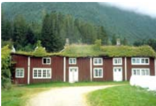
1548-009-010. Våningshus på Malme som i dag står tomt. Fasadeoppdeling og vinduer er typisk for de store låna. Det har bevart det gamle torvtaket, et trekk som etter hvert har blitt heller sjeldent i området. I 2000 er deler av taket sammenrast.
