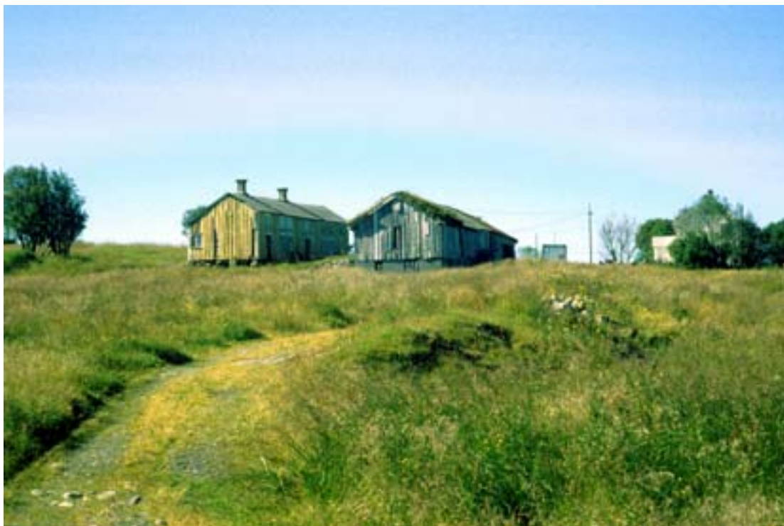
1548-020-063, 064. Den gamle tunplassen på Sandvik i Hustad med eldre bygninger som ikke lenger er i bruk. Jordvegen gror til, og lån og løe forfaller.
