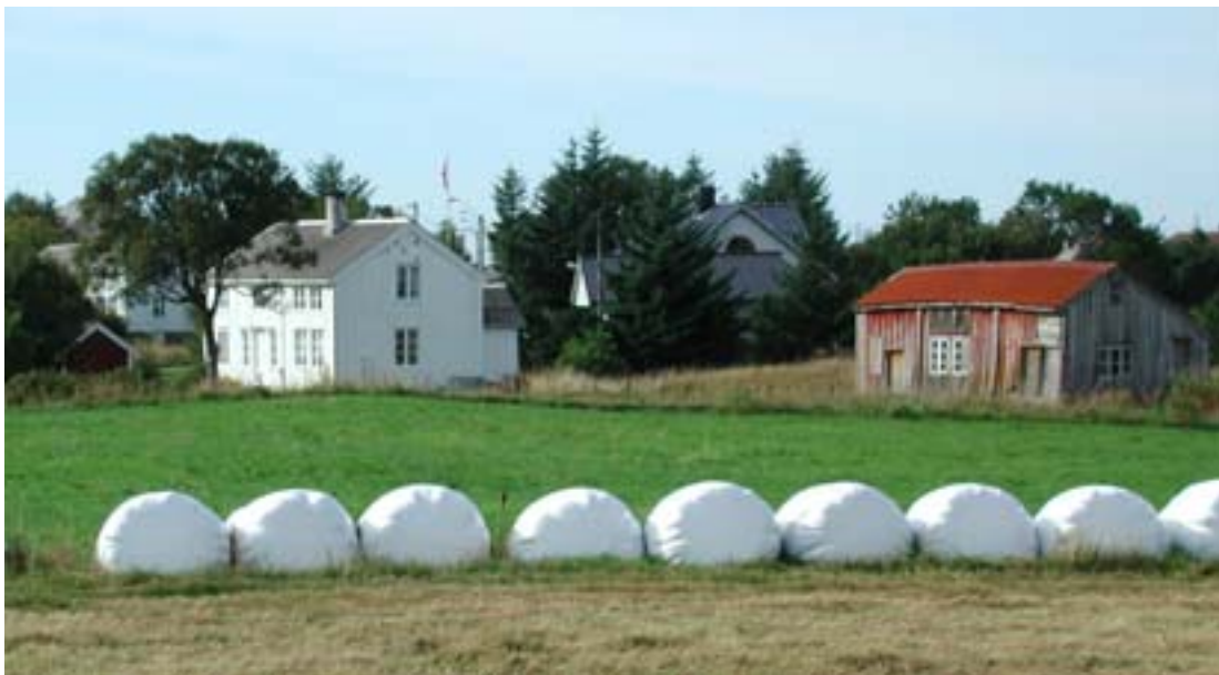
1548-019-038,039. Fra Skotheimsvika i Hustad. Huset til høyre skal være det første våningshuset på bruket. Det har etter hvert fått funksjon av lager, og er preget av forfall. Den store grua står fremdeles. Jordvegen blir leid bort.
