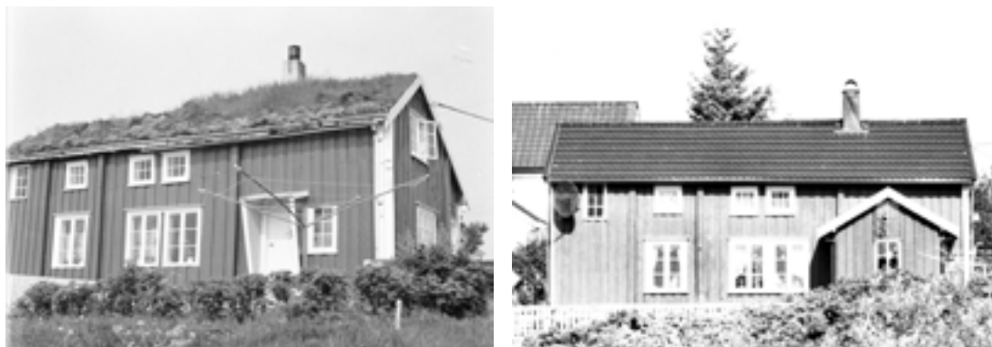
1548-016-009. Fiskerhus på Jekthaug i Budværet. Det skal være fra ca. 1870. I 2000 er huset pusset opp. Torven på taket er erstattet med moderne plater, og det har kommet et mindre utbygg foran inngangsdøra. Endringene er klassifisert som endringstype C.
