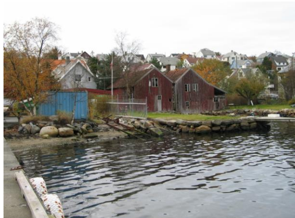
Strandgata 109 på Norestraen er i dag det eneste stedet der den opprinnelige strandlinja er bevart, med rester av brygge, dokk og eldre sjøhus. Tilstanden til sjøhusene er noe forverret siden 2002. (1102-001-069,-070)
