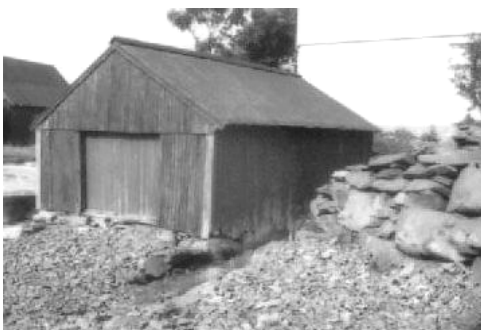
1401-0204-050. Naust i fiskeværet Rognaldsvåg. Siden registreringen i 1992 er det pusset opp. Kledningen som dels var stående trekledning og bølgeblikk, er nå erstattet av liggende trepanel. Endringene er klassifisert som endringstype C. Naustet er i feriebruk.
