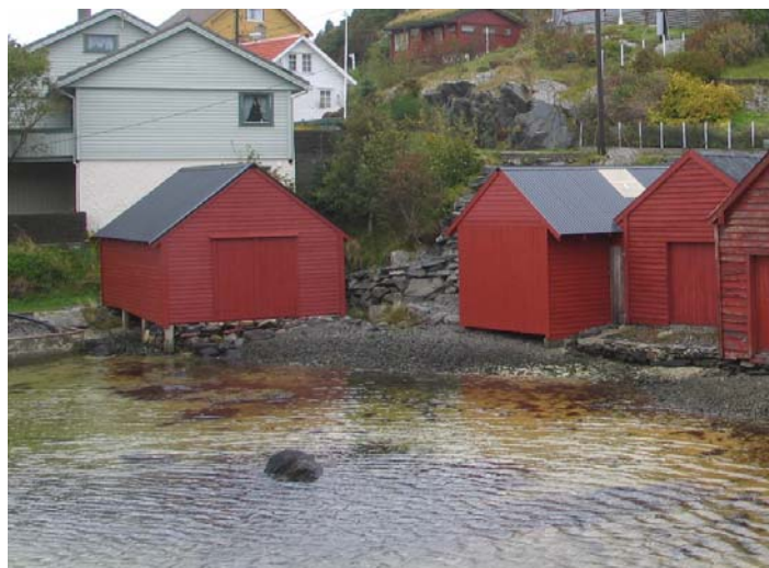
1401-0204-050. Naust i fiskeværet Rognaldsvåg. Siden registreringen i 1992 er det pusset opp. Kledningen som dels var stående trekledning og bølgeblikk, er nå erstattet av liggende trepanel. Endringene er klassifisert som endringstype C. Naustet er i feriebruk.
