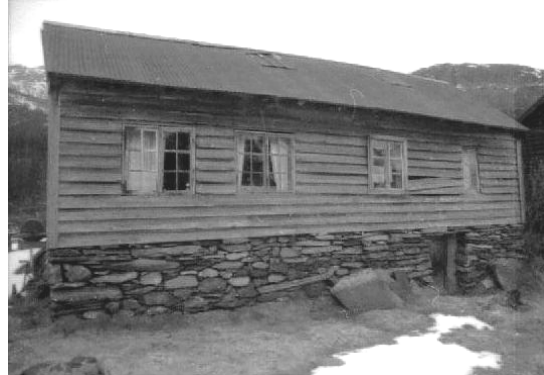
1401-0103-014. Det gamle våningshuset var ikke i bruk ved SEFRAK-registrering, da et nytt våningshus var bygd. I 2003 var det borte. Huset er typisk for de eldre våningshusene i området, med to lafta stuer og kjøkken og gang i midten.
