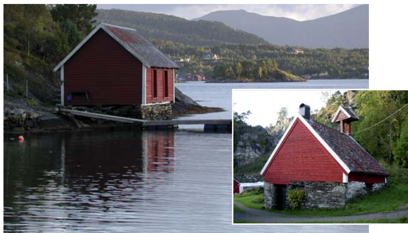
1401-0106-052, 053. Handelsstedet Hellevika mistet sin betydning da Florø by ble grunnlagt. De fleste husa ble stående, men hovedbygningen gikk tapt i ei sprengsalve da brua over til Stavøy ble bygd på 1980-tallet. Flere mer sekundære hus står tilbake, til venstre nothuset og innfelt eldhuset i tunet.
