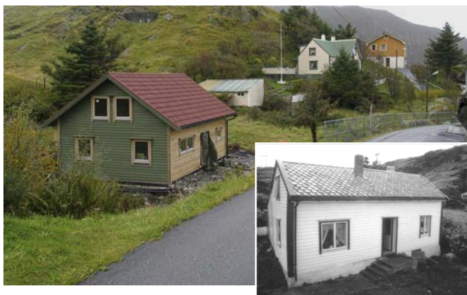
1401-0204-051. Bolig og verksted for skomaker i Rognaldsvåg. Huset skal iflg. eier ved SEFRAK-registrering være svært gammelt, og ble en gang flytta fra Svanøy. Det hadde opprinnelig tre rom, gang i midten med stue på ene sida og kjøkken på andre, og et lite loft. Et langsgående tilbygg på baksida var satt på seinere. I 2003 er huset igjen under oppussing. Noe av det gamle huset står tilbake, men da den gamle delen ikke trer tydelig fram, og det er vanskelig å gjenkjenne huset, er det klassifisert som endringstype A.
