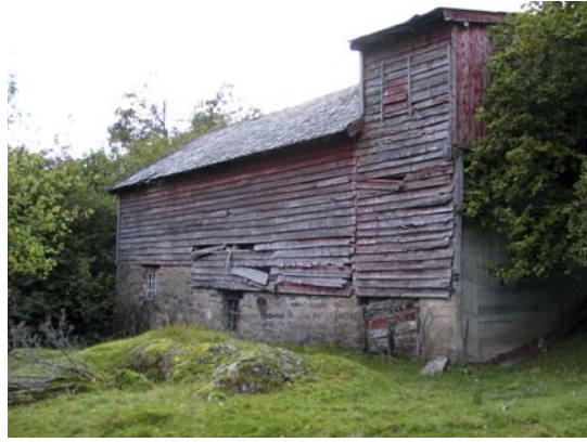
1401-0201-039. Driftsbygningen er ikke lenger i bruk, og forfallet begynner å merkes. Under steinfjøset er det møkkakjeller.
