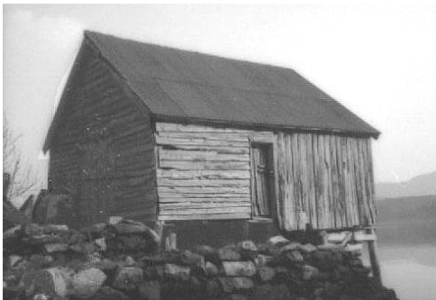
1401-0107-014. Sjøbua ved Høydalsfjorden var del av et feriested allerede ved SEFRAK-registrering. Bildet til høyre viser huset i 2003, nå er den karakteristiske supanelen og tømmermannskledningen skiftet ut med liggende kledning. Dørene er og nye. Endringene er klassifisert som endringstype C.
