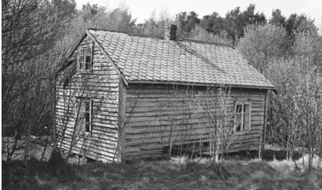
1401-0314-008. Våningshus på Klokkerplassen, Håvikbotten på Brandsøya. Det er typisk for mindre hus, gjerne på husmannsplasser. Det sto tomt ved registrering, og har siden falt i ruin. Omgivelsene er preget av nærheten til Florø med utbygging av både boligfelt og næringsarealer.
