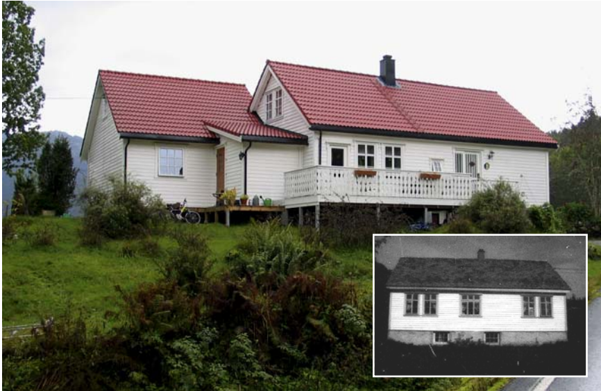
1401-0116-015. Våningshuset på Barlindbotten hadde også funksjon som skolestue fram til 1916, da skolen for området ble bygd. Huset ble pusset opp i 1986, og det innfelte bildet viser situasjonen ved SEFRAK-registreringen i 1992. I 2003 var det utvidet med et tilbygg i lengderetning, vinduene var skiftet, dels med ny plassering og en veranda var kommet til. Endringene har medført en utvidelse av huset, og er derfor klassifisert som endringstype B.
