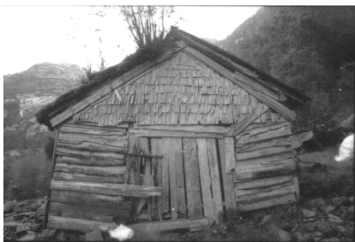
1401-0107-004. Naust ved Høydalsfjorden. Det var bygd i grindkonstruksjon, og var det eneste av de registrerte som hadde bevart eldre preg som torv på taket og sponkledning. Det var ute av bruk ved registrering, og har siden blitt borte.
