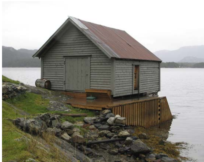
1401-0107-014. Sjøbua ved Høydalsfjorden var del av et feriested allerede ved SEFRAK-registrering. Bildet til høyre viser huset i 2003, nå er den karakteristiske supanelen og tømmermannskledningen skiftet ut med liggende kledning. Dørene er og nye. Endringene er klassifisert som endringstype C.
