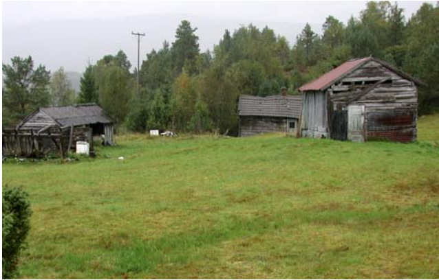
1401-0119-007-9. Tidligere husmannsplass hvor bygninger fra husmannstida fremdeles står. Bak ligger det gamle våningshuset, til høyre løa hvor fjøsdelen har falt sammen og til venstre vedhuset, med vegger av stein.
