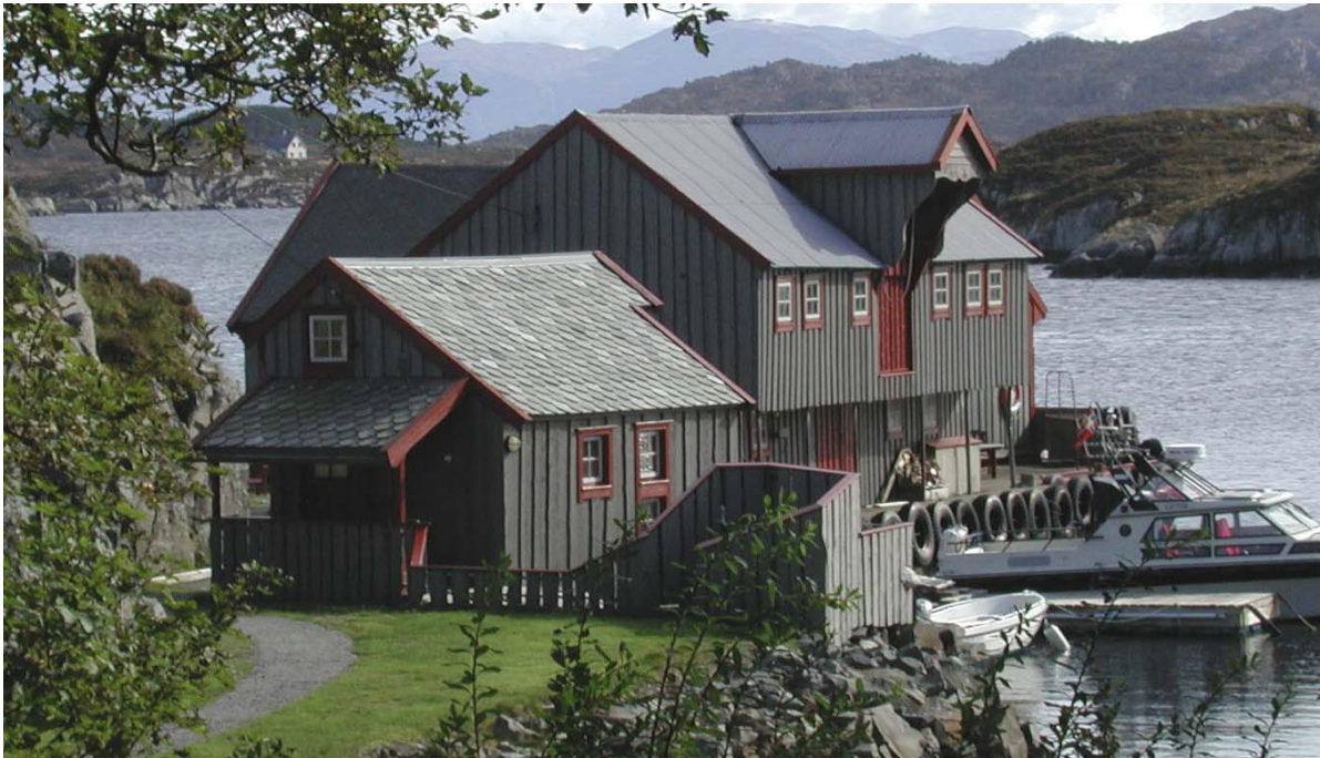
1401-0207-007, 009. Sjøbu og sjøhus på Batalden som er pusset opp og modernisert, og som nå er i bruk i turistnæringen. Sjøhuset skal være ei gammel saltebu fra de rike sildefiskeriene på 1800-tallet, og den står på kraftige steinmura.
