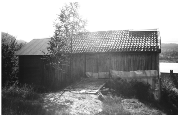
1401-0117-007. Driftsbygningen over var i dårlig stand, og ble etter hvert revet. Driftsbygninger i tunet har blant de høyeste tapsprosentene i Flora.
