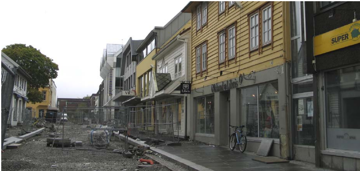
1401-0301-022, 024,026. Det har skjedd og skjer mye i Florø sentrum, parti fra Strandgata. Til høyre Strandgata 44 der vinduene er skiftet til vippevinduer med løse sprosser, nabohuset Strandgata 46 var blitt endret like før SEFRAK-registrering og hadde da fått halvtaket med "midtark" og nye vinduer. Nabohuset brant ned etter registrering, og et nytt hus har reist seg på tomten. Videre oppover gata dominerer nye forretningsgårder som hadde erstattet eldre hus før SEFRAK-registreringen.
