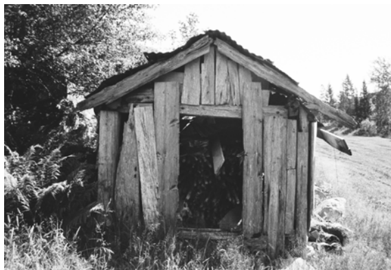
1401-0104-011. Høyløa sto på en husmannsplass, i skille mellom bøen og utmarka. Den var bygd i grindkonstruksjon, og var ved registrering i dårlig stand og ble brukt til lagring av hesjestaur. Garffjøs og høyløer var vanlige før, ved registrering var ikke mange tilbake og i løpet av undersøkelsesperioden har disse hustypene blitt ytterligere redusert.
