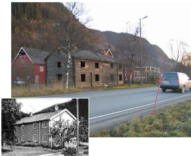
Bebyggelsen på bruket Storsand (1653-005-018) sør for Melhus kirke lå tett i gamle E6. Som en følge av vegarbeidene i området er husene vedtatt revet. Høsten 2003 var hovedbygningen i ferd med å demonteres for flytting. Det var planen å dele huset og gjenreise det som to hus i Sokndal. Også stabburet skulle tas ned, men flyttes til Oppdal.
