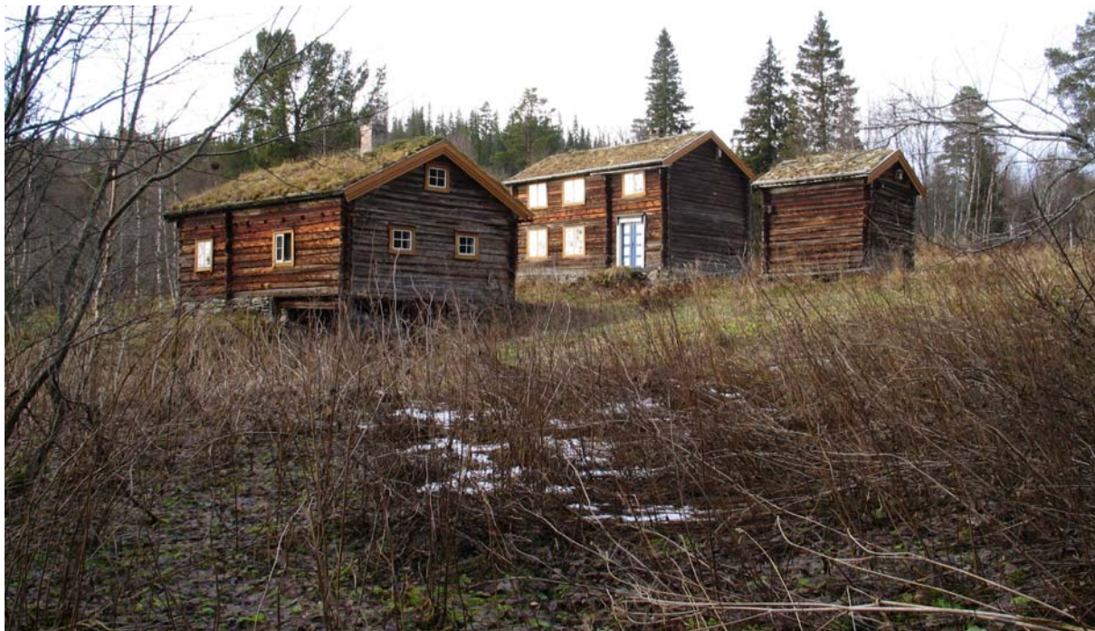
Estensadhagan (1653-029-044-46) ligger som den øverste i lia av to gamle husmannsplasser under Estenstad i Hølonnda. Her er stuebygning, fjøs og stabbur bevart. Husene var pusset opp og plassen tatt i bruk som feriested ved registreringen i 1982. Bl.a. var fjøset satt i stand som soveanneks. Låven er borte, men plasseringen av de gjenværende husene røper også her et firkanttun. Stuebygningen er en av relativt få som har bevart treromsplanen, med stue, gang og kjøkken. Det er typisk at det er på husmannsplassene vi finner denne typen i dag. Selv om bygningsmiljøene er godt bevart både på Dulufløtten og Estensadhagan er jordveien ute av bruk og i ferd med å gro til.
