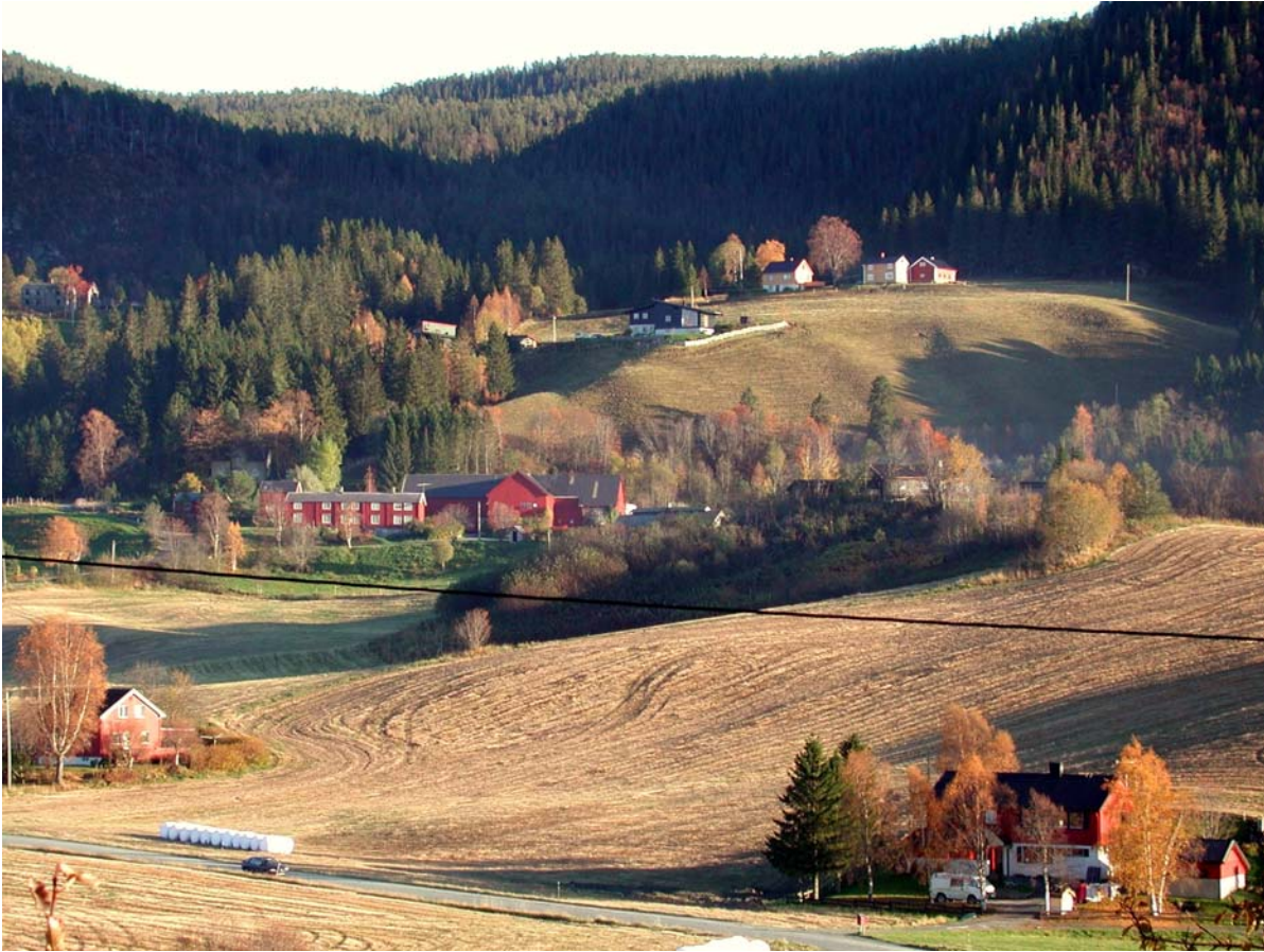
Blandet bebyggelse på Havdøl nord i Melhus. Sentralt i bildet ligger institusjonen Oppigard arbeidssenter, der det gamle trønderlånet (1653-012-020) har fått ny funksjon og inngår i anlegget sammen med et større nybygg. Havdal gård driver økologisk jordbruk ved siden av hagebruk, gartneri, vedproduksjon mm. Småbruka Midtibakkan og Rønningen ligger på bakketoppen til høyre, mens den fraflytta husmannsplassen Hagebakken så vidt skimtes bak gjengrodde jorder øverst til venstre. Dertil er det noen spredte boligeiendommer.
