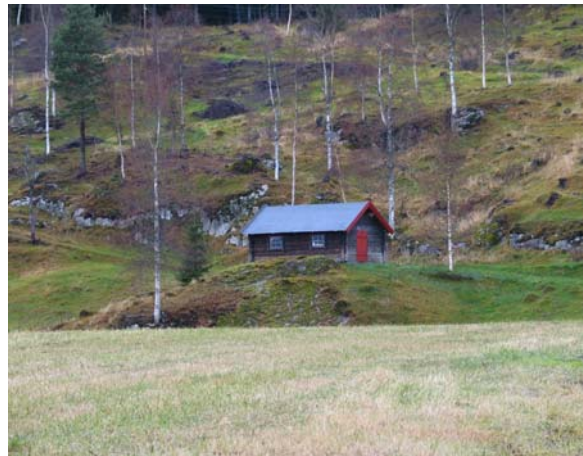
Ved registreringen på Midtflå i 1979 var det meningen å rive masstua som hadde stått uten funksjon lenge. Huset er gammelt, trolig fra 1700-tallet, og man har nå besluttet å ta vare på det. Som et første trinn er det lagt platetak. Istandsettingen er tildelt STILK-midler. (1653-013-019)
