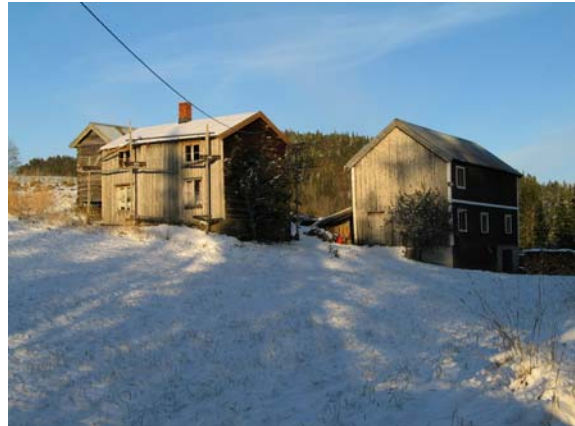
Stuebygningen på plassen Brenna var i ferd med å settes i stand 2003, bl.a. ble det lagt nytt tekke med hjelp av STILK-ordningen. (1653-018-040)
