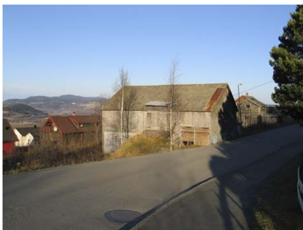
Den tidligere husmannsplassen Østeggen (1653-005-011-14) under Melhus prestegård ligger, i beltet av plasser og småbruk oppe i åsen nordøst for Melhus administrasjonssted. Ingen bodde her ved registreringen i 1983, men jordveien ble ennå brukt. I 2003 er stuebygninger revet og jordveien nedbygget.
