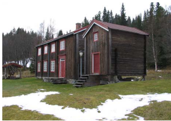
Gåslandsjerdet ligger midt i Hølonda, der skogen dominerer. Bruket var feriested ved registreringen i 1979, og husene holdes fortsatt i hevd som det. (1653-026-013, 012)
