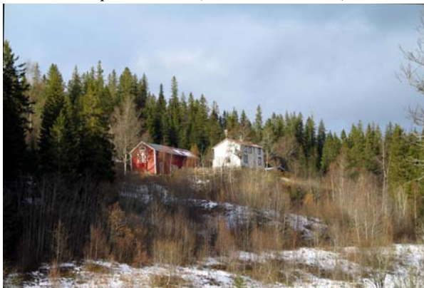
Småbruket Valleråshaugen ligger i en av sidedalene opp fra Ler i Flå. Bruket ble oppgitt å være i drift ved registreringen i 1979, men har i dag kun boligfunksjon. Deler av stuebygningen går for å være svært gammel – fra 1600-tallet. (1653-015-010)
