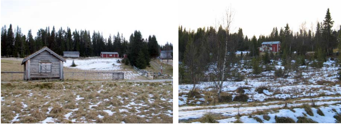
Moagjersvollen (1653-024-052) og Flåttavollen (1653-023 087) ligger begge i setergreider sørvest i Horg og illustrerer kontrastene i seterlandskapet i Melhus. I tillegg til at jordveien er i bruk og åpen på Mogjersvollen, er bygningsmiljøet tilnærmet komplett med mange typer hus bevart. Høyløa til venstre er nylig satt i stand med STILK-midler.
