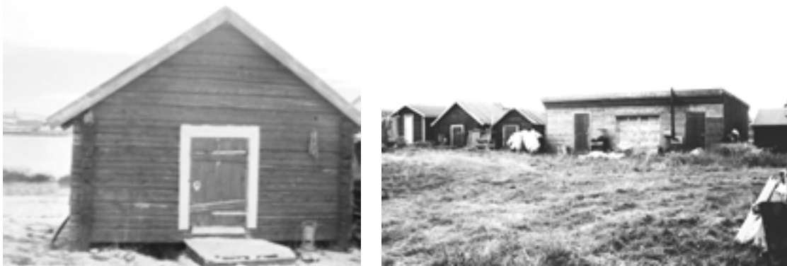
Stabburet til venstre (2011-004-046) tilhører en reineier, og skal være fra slutten av 1800-tallet. Behovet for lagringsmuligheter har ikke blitt mindre, og i 2000 sto det i ei rekke med flere andre nyere lagerhus (til høyre).
