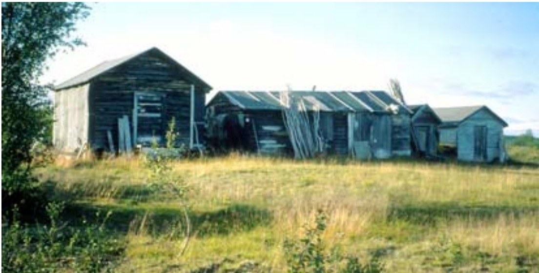
Ved SEFRAK-registrering sto bygningene på Goaskinnjávvi mer spredt i tunet. I 2000 var de organisert i ei rekke. I midten står fjøset (2011-005-004), trolig fra begynnelsen av 1900-tallet. Det er utvidet med et påbygg i lengden til høyre, ei endring klassifisert som endringstype B. Til venstre står våningshuset (2011-005-003) fra ca. 1950 (i flg. eier), i dag i bruk som stabbur. I tunet står også to yngre bolighus.
