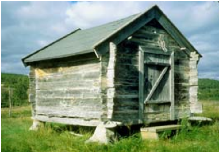
Heammonjávvi 17/21. Til venstre stabburet (2011-004-012) Det er av den tynnveggete typen og står på fururøtter. I SEFRAK er stabburet datert til begynnelsen av 1900-tallet. Det er restaurert etter registrering, bl.a. står det på ny underbygning.
