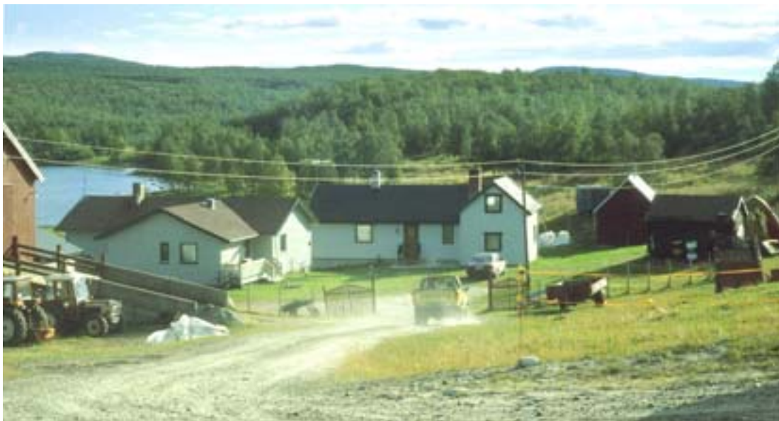
Gårdsbruket Stornes ligger mellom Rv. 93 og Kautokeinoelva, og er fremdeles i drift. I tunet står eldre stabbur (til høyre) og i midten bolighus (2011-004-002) fra ca 1930. Det er oppusset og tilbygd. Til venstre ser man så vidt driftsbygningen og det nye bolighuset.
