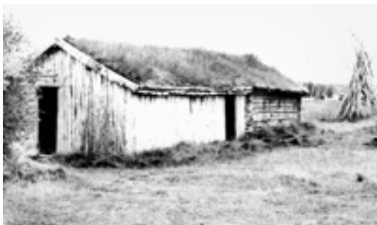
Fjøs på bygdetunet, den tømra delen (2011-006-003) sto i Láhpoluoppal ved registrering. Etter flytting til bygdetunet ble det satt i stand og tilbygd en høysjå. Flere driftsbygninger skal ha sett slik ut i Kautokeino, alle "på rot" er borte. (Borgen:1995).
