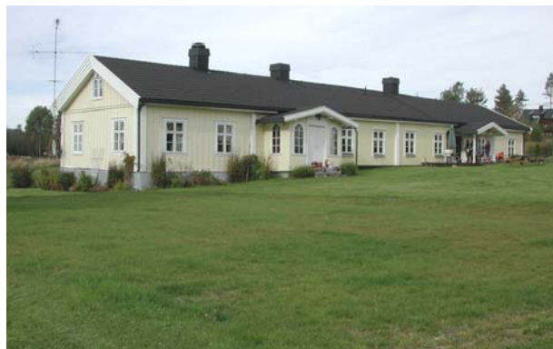
0420-018-048. Hovedbygningen på Nordre Pramhus skal være bygd i flere etapper. Ved SEFRAK-registreringen var den i dårlig stand. Siden er den pusset opp, teglstein er skiftet ut med svart sementstein og andre mindre endringer er gjennomført. Endringene er klassifisert som endringstype C.
