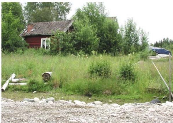
0420-013-065. Veslestua (betegnelse på sidebygning, bryggerhus) på Haugen står til forfalls. Ved SEFRAK-registreringen ble taksteinene betegnet som dårlige, siden da er tunet fraflytt, men jordveien drives. Veslestua er en utsatt hustype i Eidskog.
