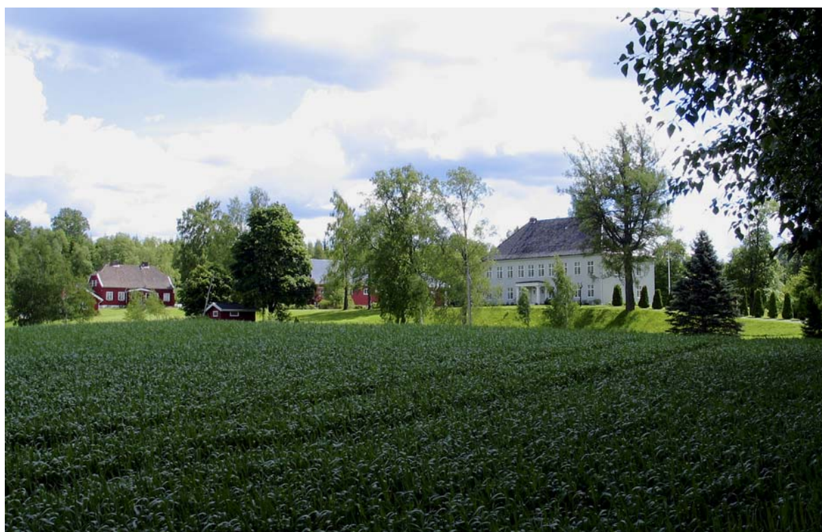
0420-014-021, 023. Lundebygodset. Hovedbygningen fikk sin nåværende utforming på 1920-tallet. Det er bare den og stabburet som er fra før 1900. Til venstre arbeiderbolig fra 1920-tallet.
