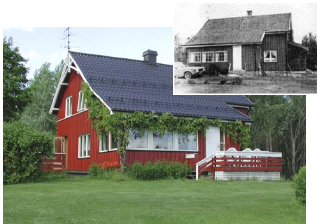
0420-009-017. Våningshuset er tatt i bruk til feriehus, noe som har medført mindre endringer. Takbelegg og noen vinduer er skiftet, og små verandaer tilbygd. Det siste er blitt vanlig i Eidskog i undersøkelsesperioden. Det er valgt å klassifisere dette som en C-endring.
