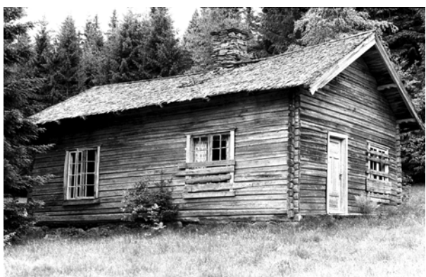
0420-012-018. Stua på husmannsplassen Vangen har trolig opprinnelig vært ei seterstue. Den hadde ikke vært i bruk på flere år, og ble til slutt revet.
