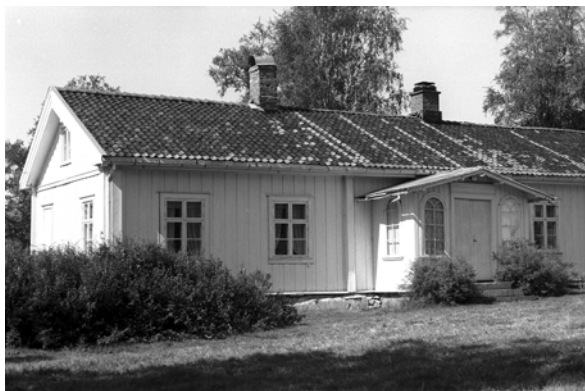
0420-018-048. Hovedbygningen på Nordre Pramhus skal være bygd i flere etapper. Ved SEFRAK-registreringen var den i dårlig stand. Siden er den pusset opp, teglstein er skiftet ut med svart sementstein og andre mindre endringer er gjennomført. Endringene er klassifisert som endringstype C.
