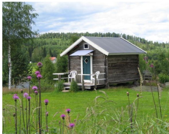
Stabburet på småbruket Sørenga var under oppussing i 2002. Taket var i ferd med å legges om, kledningen på fronten fjernet og ny dør satt inn. Huset er nå ferdig med nytt tekke og en liten veranda. De bare tømmerveggene er beholdt, et typisk trekk ved nåtidens endringer. Huset har endret status fra "Står" til endringstype C. (0420-009-009)
