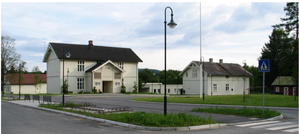
Magnor skole er et anlegg med flere generasjoner skolebygg. To er registrert, det eldste fra 1861 er med i denne undersøkelsen med status som uendret. Her har også Eidskog Museum et anlegg med smie og snekkerverksted. (0420-011-49)
