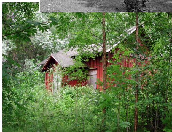
Haugerudhuset like utenfor Skotterud var bolig for smed. Det er planlagt ny innkjøringsveg til sentrum like ved huset som sto ubrukt i en igjengrodd hage i 2002. I 2007 var det revet. (0420-012-019)
