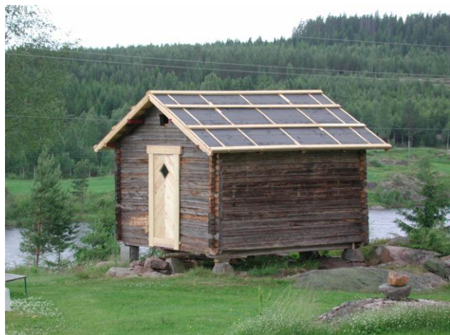
Stabburet på småbruket Sørenga var under oppussing i 2002. Taket var i ferd med å legges om, kledningen på fronten fjernet og ny dør satt inn. Huset er nå ferdig med nytt tekke og en liten veranda. De bare tømmerveggene er beholdt, et typisk trekk ved nåtidens endringer. Huset har endret status fra "Står" til endringstype C. (0420-009-009)
