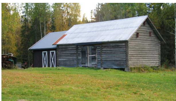
Låven på Almenningssetra er en klassisk tredelt tømmerlåve, datert til rundt 1880. Ved registreringen sto den for seg selv. I 2007 er en garasje bygd til i lengden. Tilbygget følger et tradisjonelt mønster for de sammenstilte uthusrekkene. Endringen er klassifisert som endringstype B.(0420-002-022)
