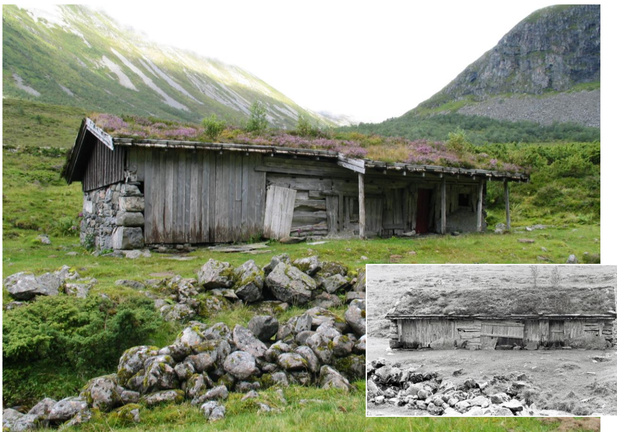
1548-010-008. Sommerfjøset på Røldalsetra var pusset opp under 1. omverv. Det er i hovedsak satt i stand med samme materialer som ved registreringen. Eneste endring er at taket er trukket ut som en sval. Det er vurdert til endringstype C.
