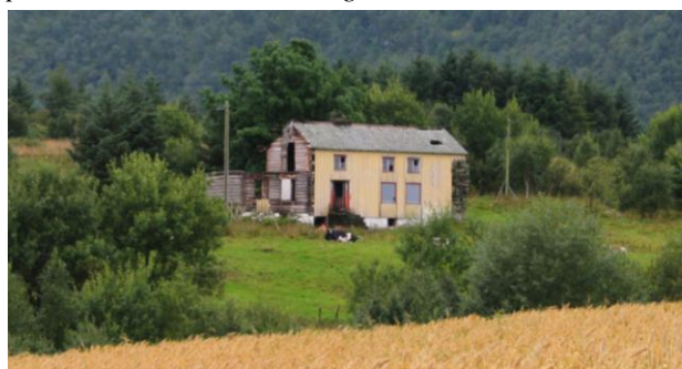
1548-019-033. Våningshus i Skotten-området, i 2000 sto det uendret, i 2005 var det i dårlig stand og halve huset var revet. Når/om huset forsvinner, går enda ett hus med den karakteristiske lemuren i naturstein tapt.
