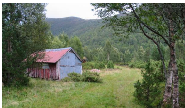
1548-008-010. Seterbua på Storsetra var i god stand ved SEFRAK-registrering i 1980. Den var da i bruk som feriehus. I 2005 var tilstanden forverret.
