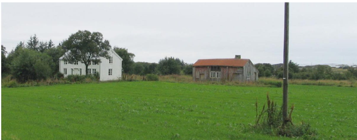
1548-019-038,039. Fra Skotheimsvika i Hustad. Huset til høyre, Massinastua, har fått støtte til oppussing fra Kulturminnefondet, satsingsområde kystkultur. Inne i huset står fremdeles grue og bakerovn.
