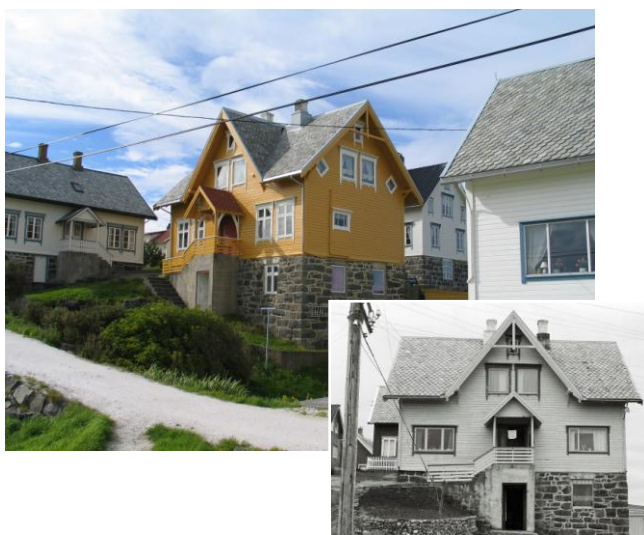
1548-001-129 Fiskerbolig på Nordre Bjørnstad som nylig er pusset opp og ført tilbake. Huset er udatert, men har nok fått sin form etter flytting 1909–13. Endringsstatus er C.
