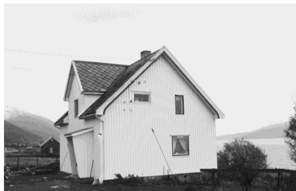
1902-4002-010. Våningshus for fiskerbonde ved Straumbukta, trolig bygd på 1880-tallet. I 2006 var huset pusset opp og bygd ut. Det lille funkisoverbygget ved inngangen er erstattet med større bislag med saltak. Det planlegges terrasse i bakkeplan i solveggen, og mot sjøen er det bygd vinduskarnapp. Status er endringstype B.
