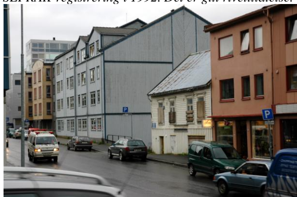
1902-0116-020. Inneklemt blant store nybygg ligger ett av de eldste husene i Tromsø. Det skal være bygd for en skredder ca. 1842. Det ble ombygd noe rundt midten av 1970-tallet. Ved registreringen i 1979 var det ennå i bruk. Mellom 2001 og 2006 har husets tilstand forverret seg.
