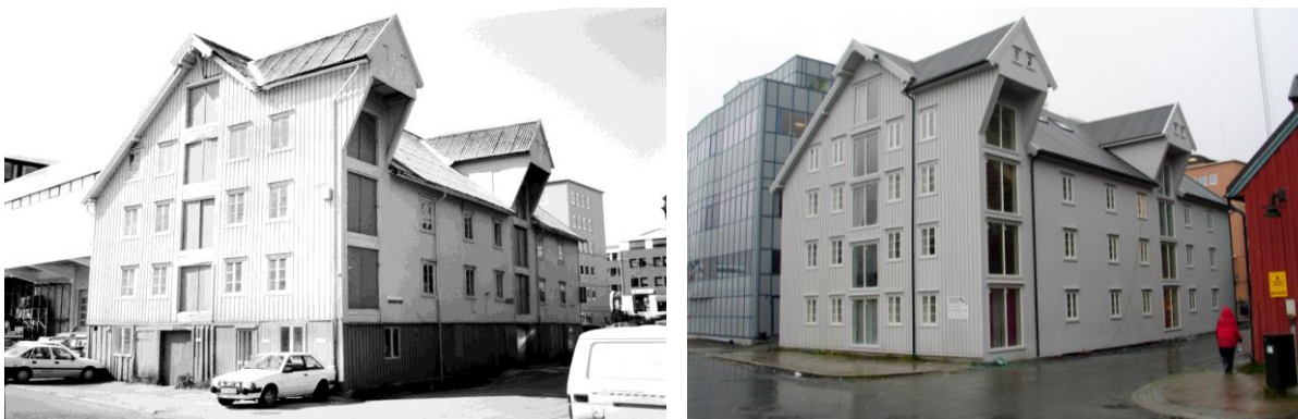
1902-0106-005. Arnesenbrygga er en av tre gjenværende brygger i et eldre bryggemiljø på Prostneset. Omgivelsene er ellers preget av tung sentrumsutbygging. Brygga var i opprinnelig bruk som lagerhus ved registreringen i 1992. Huset er nylig ominnredet til kontorer og pusset opp. Typiske fasadeendringer som speiler funksjonsendringene fra lager til annen bruk, er glassåpningene som erstatter de gamle inntaksdørene under vinsjutbyggene. Endringen er klassifisert som endringstype C.
