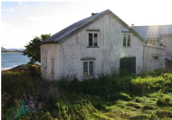
1902-4104-042. Huset skal ha vært bolighus for los og dampskipsekspeditor på Sommarøy. I flere år var det postkontor og rikstelefon her. Også ved registreringen i 1989 ble det opplyst at det var i dårlig stand.
