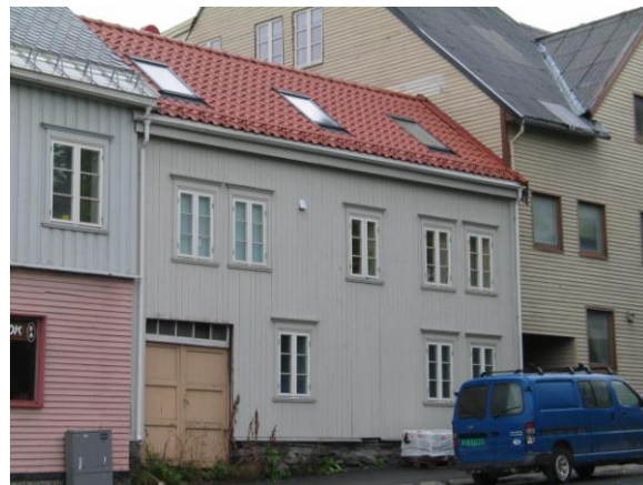
1902-103-023. Liten bygård, til venstre i 2001, til høyre i 2006. I 2006 har den fått takvinduer, nytt takbelegg og gatedøra er panelt igjen. Endringen er klassifisert som endringstype C.
