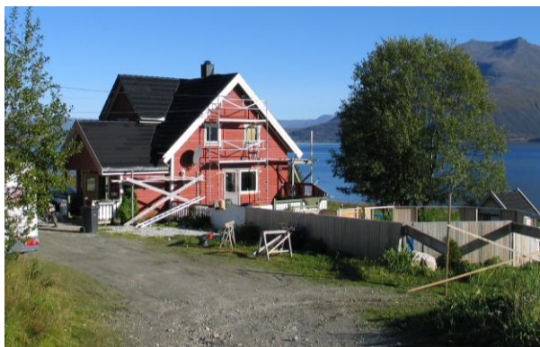
1902-4002-010. Våningshus for fiskerbonde ved Straumbukta, trolig bygd på 1880-tallet. I 2006 var huset pusset opp og bygd ut. Det lille funkisoverbygget ved inngangen er erstattet med større bislag med saltak. Det planlegges terrasse i bakkeplan i solveggen, og mot sjøen er det bygd vinduskarnapp. Status er endringstype B.
