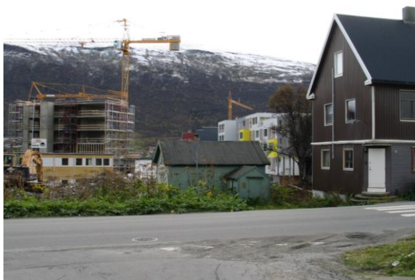
1902-109-002. Lite bolighus som står og forfaller like ved et utbyggingsområde. Det er rest av et eldre lag bebyggelse i Strandvegen. Eiendommen ble etablert i 1860, men ellers er det ingen opplysninger om opprinnelig tilknytting. Det var i forfall også ved SEFRAK-registrering i 1992. Det er gitt rivetillatelse.
