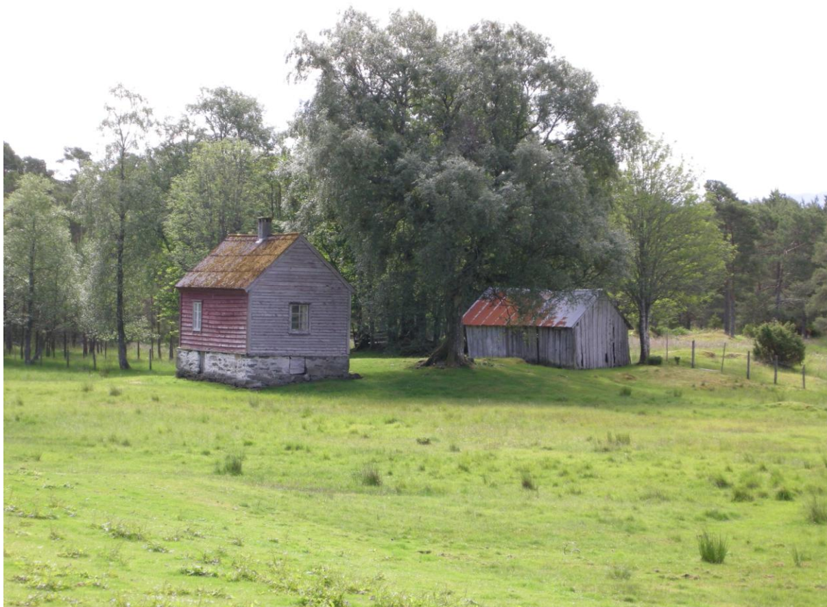
1401-201-032. Husmannsplass på Stavøy som står uten bruk i innhegnet beiteområde. Den var fraflyttet også ved registreringen i 1993. Det er bare våningshuset som er registrert.
