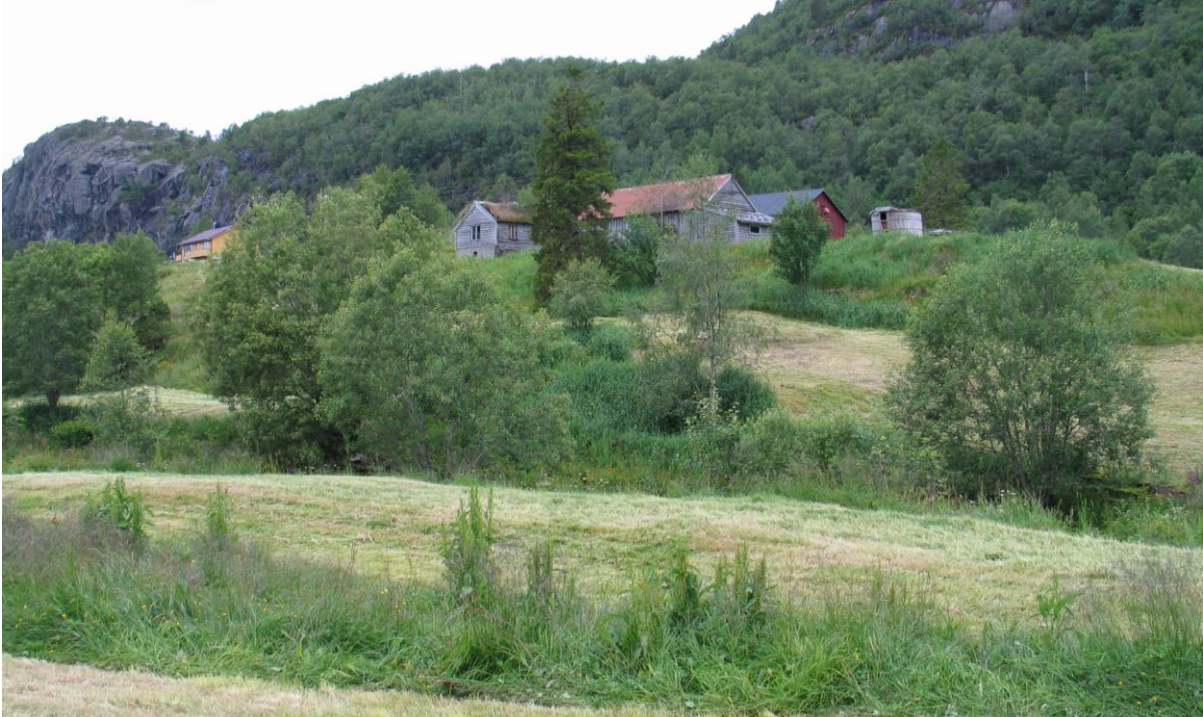
1401-104-002, 003, 004, 005. Fra Steindalen. Den eldre bebyggelsen står ubrukt etter at det er bygd nytt tun litt lenger inn på terrassen bebyggelsen ligger på. Krattskogen kryper nærmere, bare de sletteste partiene av jordveien blir slått og de gamle bygningene forfaller.
