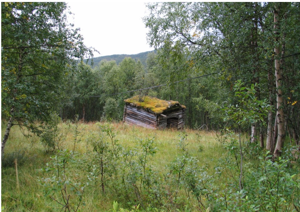
1840-202-102. Høyløa i Evenesdal var for lengst ute av bruk ved registreringen i 1982. Den var alt da forfallen og begynt å sige. Den skal være satt opp i første halvdel av 1800-tallet og er solid bygd. Men den skakker mer på seg nå enn ved 1. omverv, og jordet er i ferd med å gro til. Ca. fem av de tolv gjenstående utmarkshusene av denne typen er i tilsvarende forfatning.
