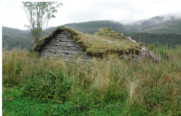
1840-109-017. Sommerfjøsset på Ytter-Setså sto så vidt i 2002 (foto), men var falt ned 2007. Huset var eldhus før, og viser et gjenbruksforløp som var ganske vanlig. Det er relativt få tap blant utmarkshusene i 2. omverv, men flere av de resterende er i like dårlig stand som dette var i 2002.
