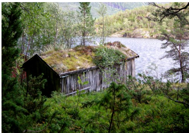
1840-110-136. Nauset ved Litlevatnet er et av få registrerte naust ved innlandsvatn. Det er i enkel stavkonstruksjon. Iflg. registreringen er det en mulighet for at det også har vært brukt som høyløe. Det står i en liten gruppe med noe yngre naust.
