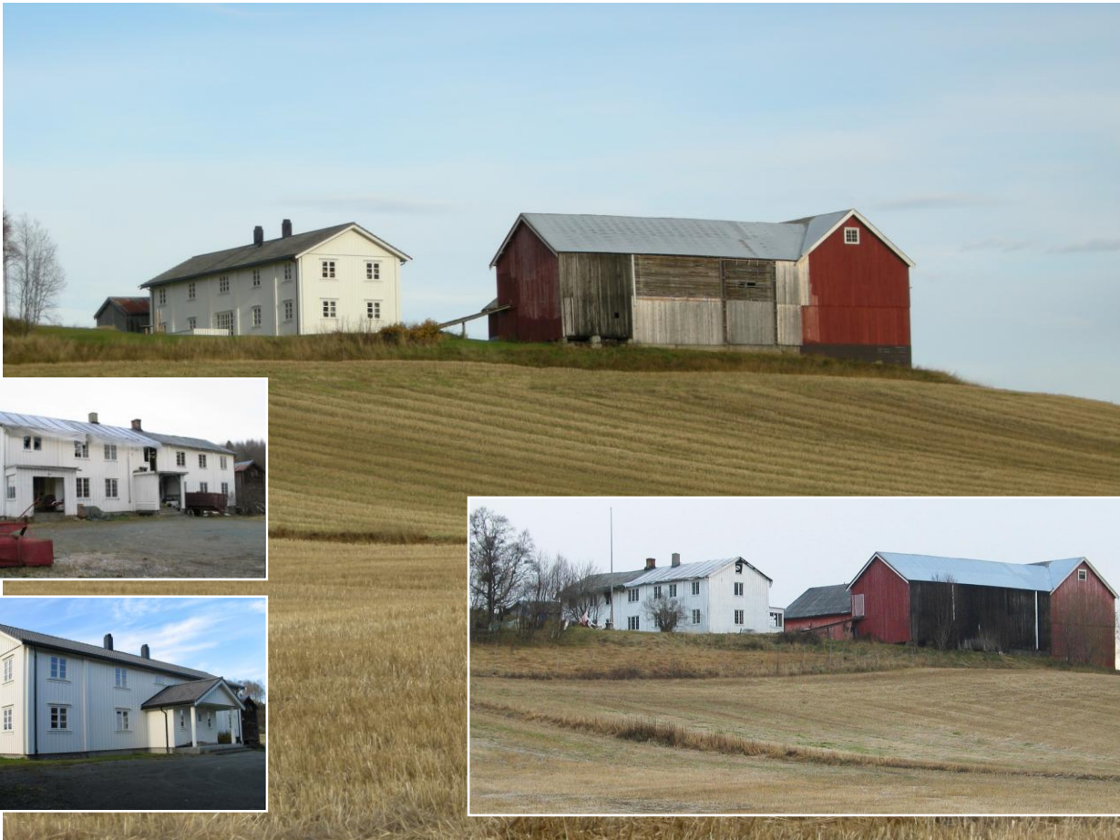
Hovedbygningen på Eid i Hølonda skal være ei av få lån bygd under ett, og er datert til 1821. Det sto på terskelen til å bli satt i stand i 2003, og er nå ferdig. Bislag med pulttak er erstattet av nye med saltak og annen plassering. Vindusaksene er endret med færre på langveggen og flere i endeveggen. Endringsstatus er B. (1653-025-028,029)
