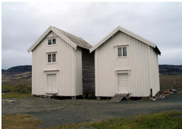
Burene på Nygården på Øysand er ominnredet til boligformål med eksteriørendringer som forteller om den nye funksjonen. Noen av stabburene i materialet har tilsvarende endring. Endringen er klassifisert som type C. (1653-001-004, 005)
