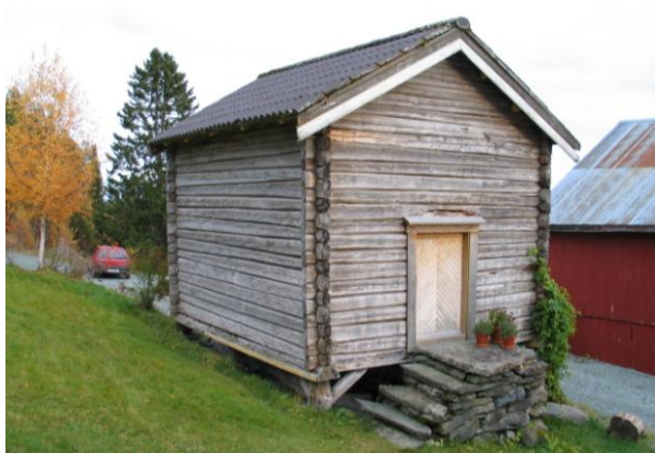
Buret på Lufall i Hølanda ble satt opp i nåværende tun i 1865 og ble trolig kledd da. Det sto før "oppe i gamletunet". Solsvidde sider kom fram da en nylig tok av kledningen, noe som viste at det tidligere var vendt motsatt veg i gamletunet. For stabbur er fjerning av ytterkledning en av de vanligste eksteriørendringene – ved 1. og 2. omverv. (1653-029-035)
