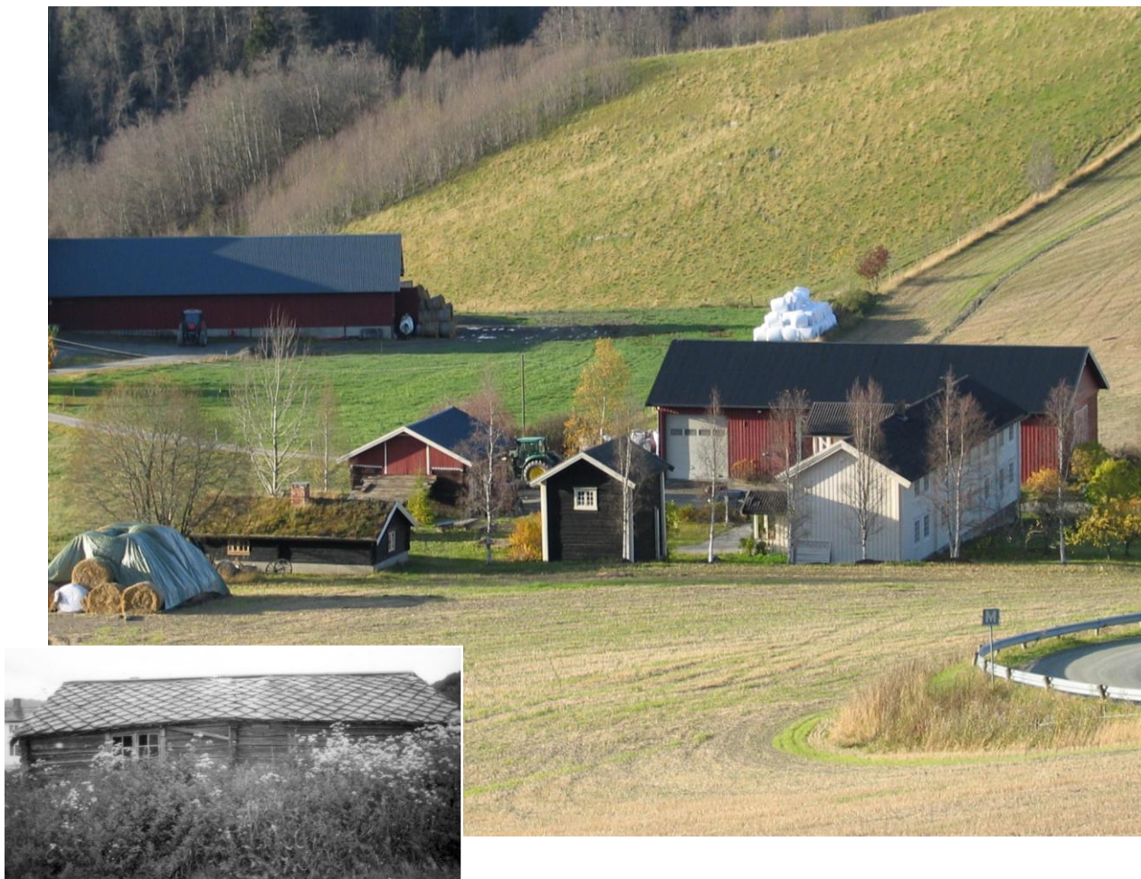
Bebyggelsen på Dal i Flå er mye omorganisert, fornyet og endret siden registreringen i 1989. Det siste huset en tok fatt på var smia – under utbedring sist og nå ferdig. Den er laftet opp på nytt, satt på ny grunnmur og det gamle skifertaket er byttet med torvtak. Endringen er klassifisert som type C.(1653-015-026)
