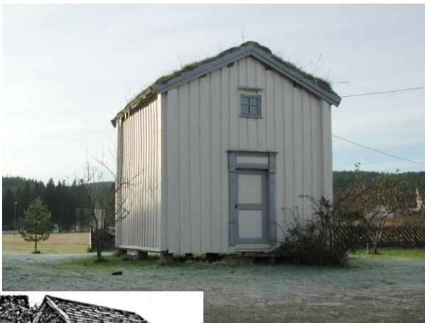
Stabburet på Mælen Hermanstad var ved 1. omverv pusset opp med kledning på vegger der det før manglet, og hadde fått torvtekke til erstatning for sementsteinen det hadde ved registreringen i 1984. Det er nå endret igjen med nytt tak med større utstikk og tekke av shingelpapp. Fortsatt har det endringsstatus C. (1653-008-016)
