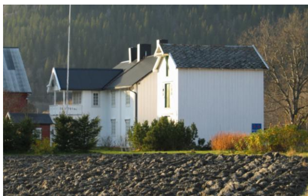
Som så mange av trønderlånene i materialet er hovedbygningen på Høiset Horg bygd ut i flere etapper. Eldste delen skal ligge i midten og denne har nå fått et utbygg med saltak og veranda. Inngangspartier med veranda som tak fra tidligere fasadeendringer utover 1900-tallet blir det stadig færre av. (1653-017-004)
