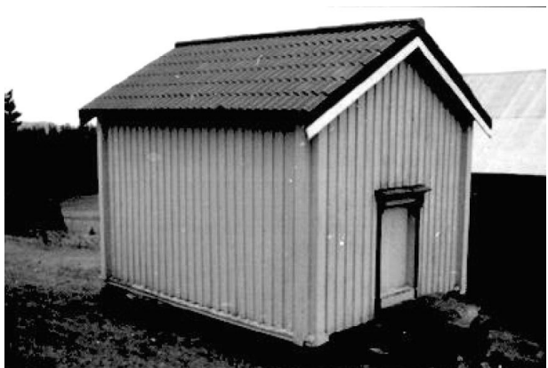
Buret på Lufall i Hølanda ble satt opp i nåværende tun i 1865 og ble trolig kledd da. Det sto før "oppe i gamletunet". Solsvidde sider kom fram da en nylig tok av kledningen, noe som viste at det tidligere var vendt motsatt veg i gamletunet. For stabbur er fjerning av ytterkledning en av de vanligste eksteriørendringene – ved 1. og 2. omverv. (1653-029-035)
