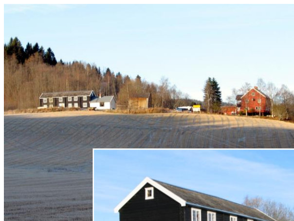
Våningshuset på Stokke var i dårlig forfatning ved 1. omverv. Huset er siden pusset opp, skifertekket og vinduer fornyet og kledning fjerna. Våningshuset på Stokke danner et unntak i det siste. Stort sett er det de mindre uthusene i Melhus som får bare tømmervegger som et nytt element etter oppussing. Endringen er klassifisert som type C.(1653-008-027)
