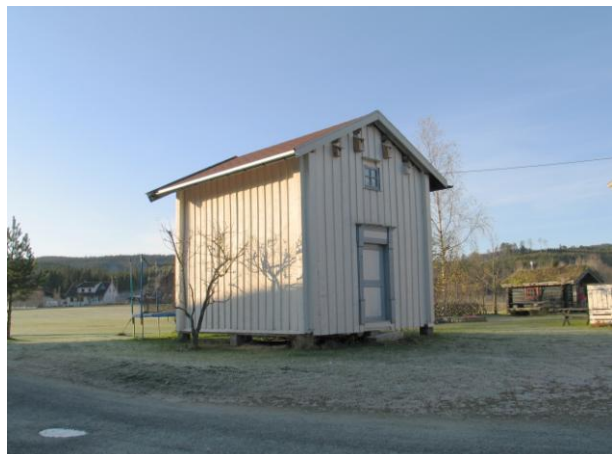
Stabburet på Mælen Hermanstad var ved 1. omverv pusset opp med kledning på vegger der det før manglet, og hadde fått torvtekke til erstatning for sementsteinen det hadde ved registreringen i 1984. Det er nå endret igjen med nytt tak med større utstikk og tekke av shingelpapp. Fortsatt har det endringsstatus C. (1653-008-016)
