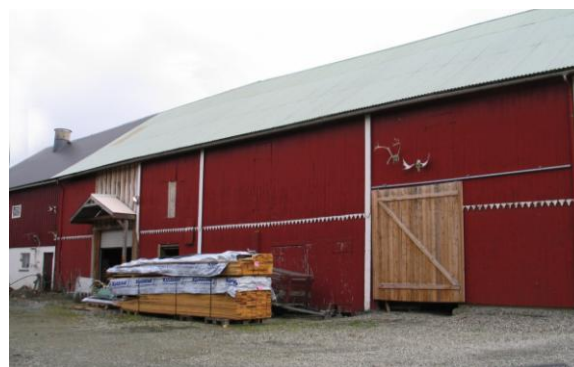
Låven på Nedre Hovind i Horg fikk trolig sin form etter ombygging i 1910, men er nok eldre. Den er en kledd tømmerlåve. Flytting og åpning av nye innganger og dører er den mest vanlige eksteriørendringen på denne typen bygg. Endringen er klassifisert som type C. (1653-022-017)
