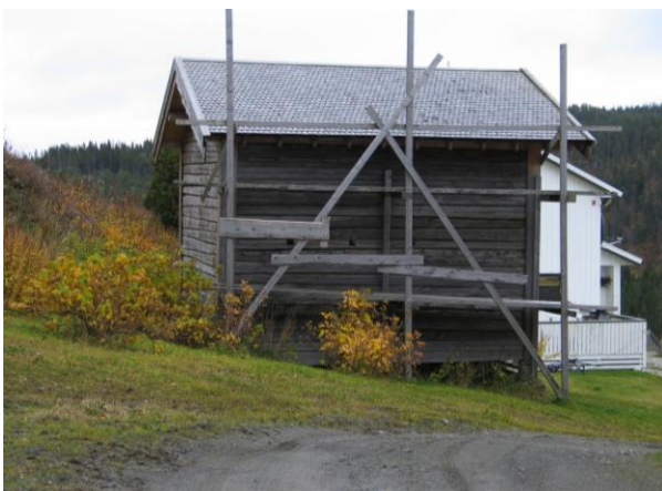
Nylagte burstak på Estenstad til venstre og Kregnes til høyre. Både spon og skifer er forankret i Melhus-materialet som tradisjonelt taktekke, men det er sjelden det legges nye tak i disse materialene, særlig er spontak uvanlige. Begge hadde plater ved registreringen tidlig på 1980-tallet. Men det opplyses at Kregnes-buret skal ha hatt spon før. Endringen er klassifisert som type C. (1653-029-048, 1653-007-016)
