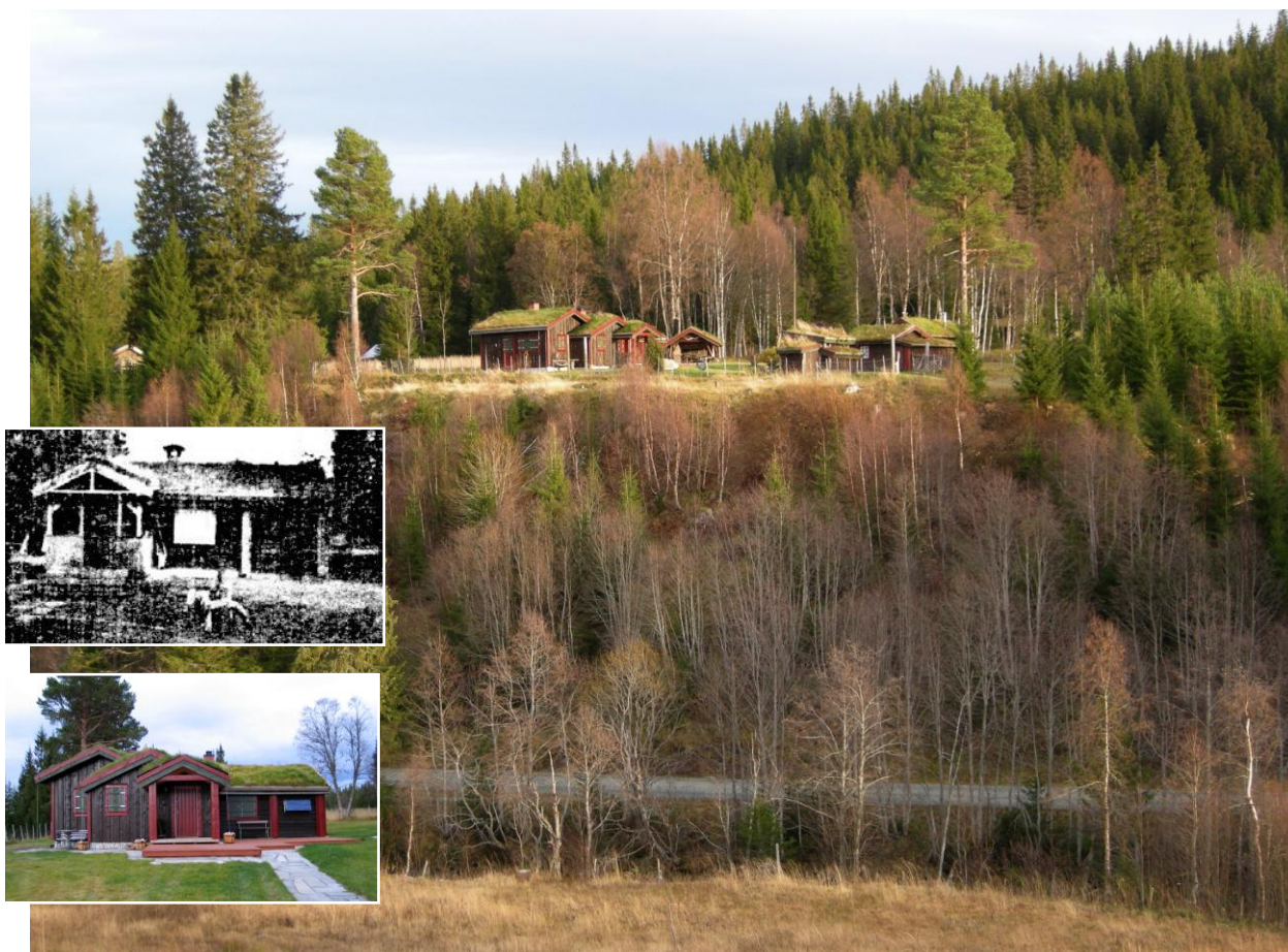
Deler av seteren Midtømmesvollen er bygd ut til hyttetun siden registreringen, men dette huset var i bruk som fritidsbolig også ved registreringen i 1989 (innfelt øverst). Det er siden bygd på i flere lag og har endringsstatus A (innfelt nederst). Nabosetra er intakt. (1653-024-072)
