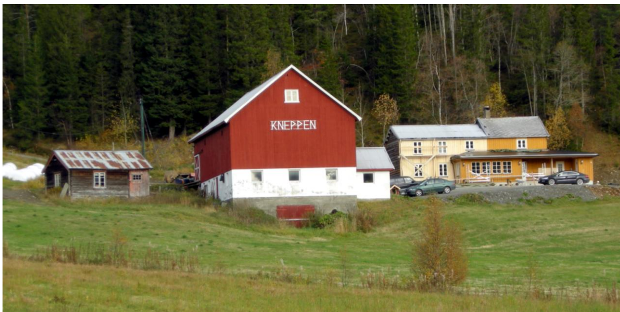
Kneppen i Hølonda har bakgrunn som husmannsplass. Eldste del av våningshuset er en typisk treromsstue fra rundt 1800. Kjøkkenseksjonen til høyre ble tilbygd i 1947. Selv om det nå bygges ut, er alle byggetrinn fortsatt lette "å lese", og slik skiller huset seg fra de fleste tilbygde hus i undersøkelsen. Huset inngår foreløpig med endringsstatus "Står". (1653-027-043)
