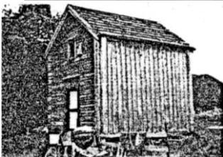
Stabburet på Mælen Hermanstad var ved 1. omverv pusset opp med kledning på vegger der det før manglet, og hadde fått torvtekke til erstatning for sementsteinen det hadde ved registreringen i 1984. Det er nå endret igjen med nytt tak med større utstikk og tekke av shingelpapp. Fortsatt har det endringsstatus C. (1653-008-016)
