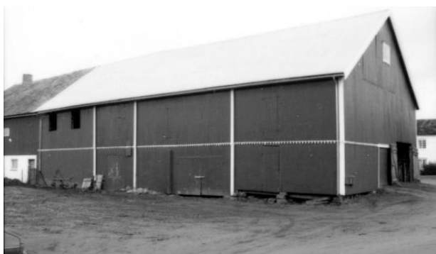
Låven på Nedre Hovind i Horg fikk trolig sin form etter ombygging i 1910, men er nok eldre. Den er en kledd tømmerlåve. Flytting og åpning av nye innganger og dører er den mest vanlige eksteriørendringen på denne typen bygg. Endringen er klassifisert som type C. (1653-022-017)
