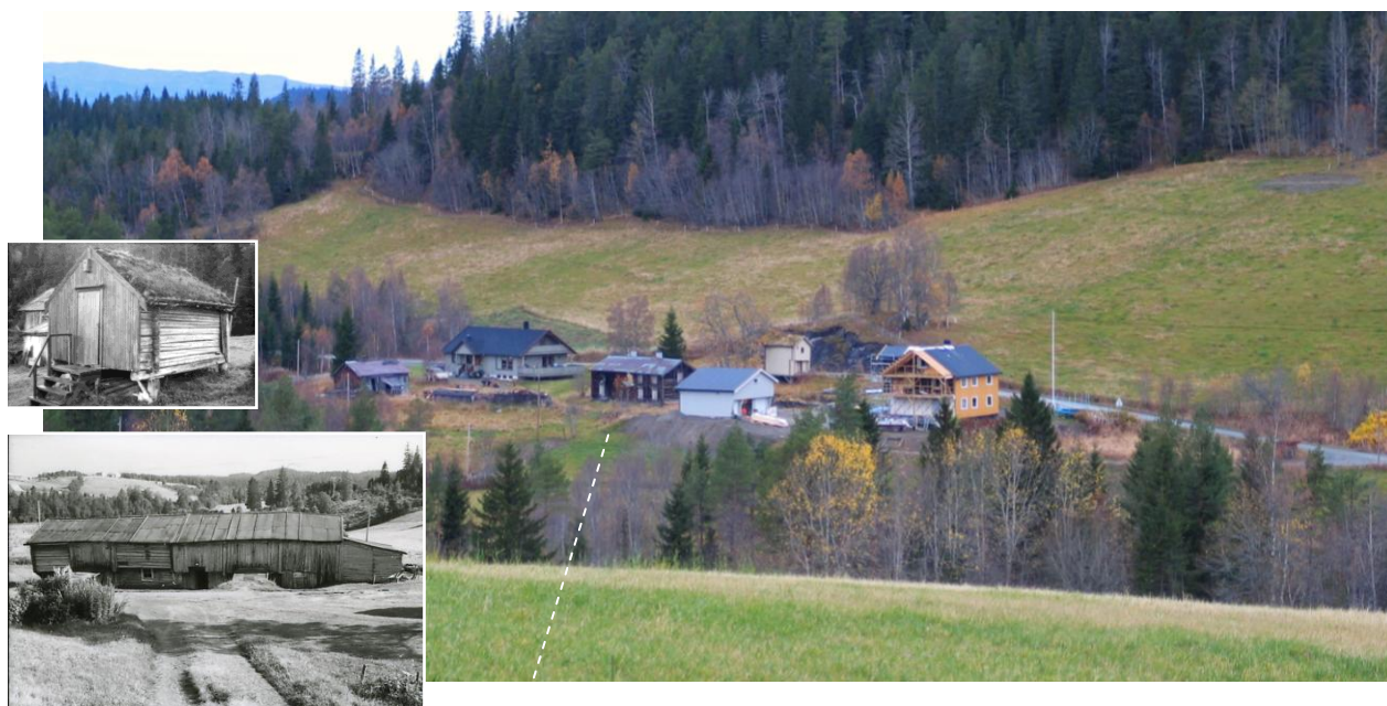
Hammerås i Hølonda hadde flere intakte hus fra det eldste sjiktet ved registreringen i 1982. I dag står det gamle våningshuset fra 1700-tallet (midt i bildet) og en yngre masstue (ikke registrert) tilbake. Driftsbygningen og stabbuet er demontert og ligger lagret på museet på Gåsbakken. De inngår likevel som tap i denne undersøkelsen. (1653-027-016, 017).
