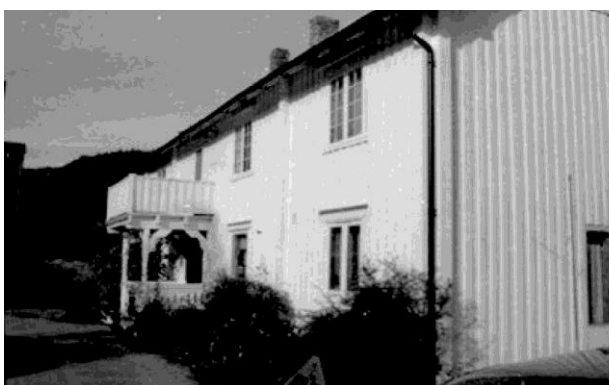
Som så mange av trønderlånene i materialet er hovedbygningen på Høiset Horg bygd ut i flere etapper. Eldste delen skal ligge i midten og denne har nå fått et utbygg med saltak og veranda. Inngangspartier med veranda som tak fra tidligere fasadeendringer utover 1900-tallet blir det stadig færre av. (1653-017-004)
