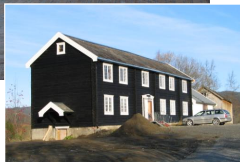
Våningshuset på Stokke var i dårlig forfatning ved 1. omverv. Huset er siden pusset opp, skifertekket og vinduer fornyet og kledning fjerna. Våningshuset på Stokke danner et unntak i det siste. Stort sett er det de mindre uthusene i Melhus som får bare tømmervegger som et nytt element etter oppussing. Endringen er klassifisert som type C.(1653-008-027)
