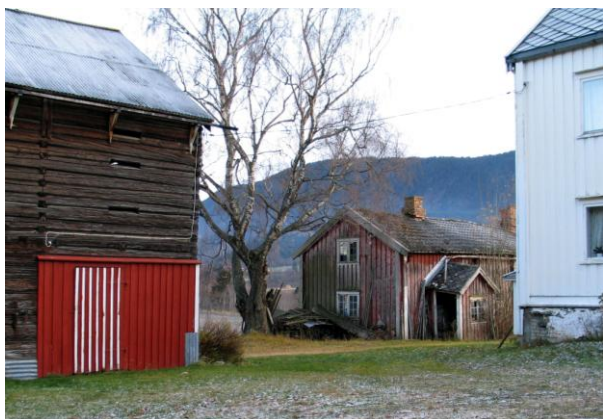
Masstua på Kregnes i delområdet Melhus er datert til 1700-tallet. Ved registreringen i 1984 var funksjonen redusert til vedlager. Til tross for store tapsandeler ved 1. og 2. omverv, ligger andelen truede av de som står igjen fortsatt godt over gjennomsnittet. (1653-007-017)
