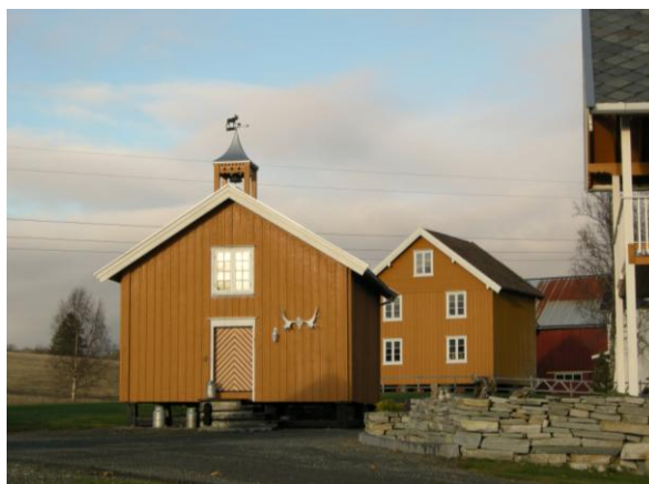
Buret på Nerstu Hegdal var i dårlig forfatning og skulle rives ved registreringen i 1983. Det er nå løftet opp fra bakken og pusset opp med bl.a. skifertekke og klokketårn. Endringen er klassifisert som type C. (1653-002-046)
