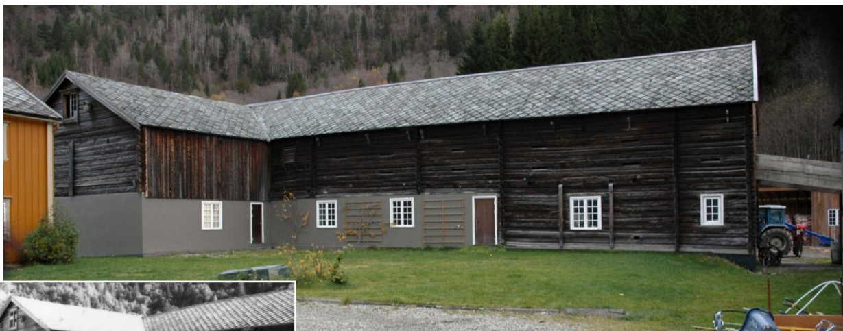
Fjøset på Hage i Horg var under utbedring ved 1. omvern og er nå ferdig pusset opp. Det er en stor vinkelbygd tømmerbygning, med fjøsskasse i gråstein. Huset er antatt fra siste del av 1800-tallet. Fjøs muren og deler av underetasjen er fornyet. Husets funksjon nå er i hovedsak ulike lagerformål. Sammen med andre gamle hus er fjøsbygningen del av et stramt og lukket firkanttun. (1653-020-004)
