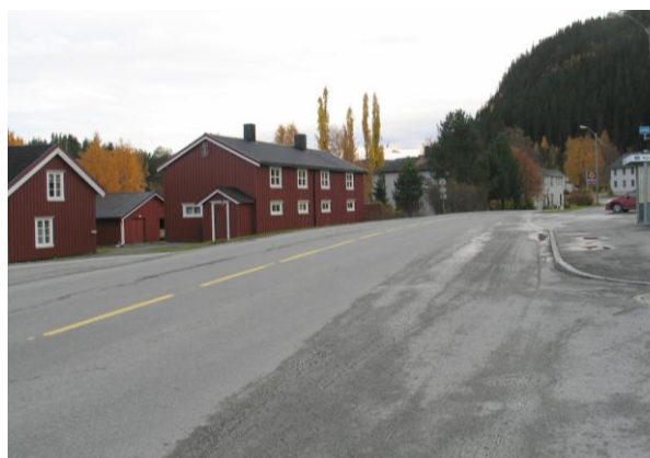
"Posthuset" i tettstedet Hølanda er pusset opp siden 1. omverv. Fasaden er "strammet" opp med likartete vinduer. Slik oppstramming er ofte et element ved fasadeendringer. Huset er også bygd ut mot bakgården og endringsstatus er derfor B. (1653-026-064)
