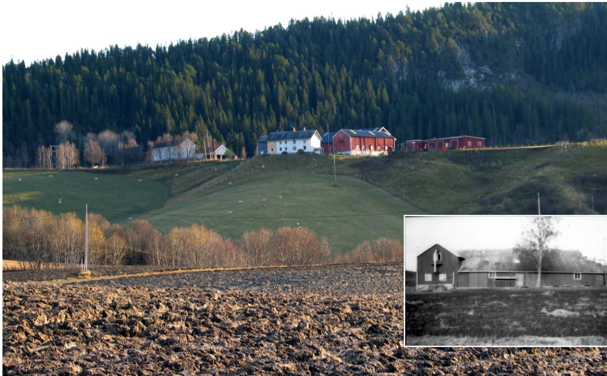
Fjøset på Rognbrauta var del av en stor driftsbygning som utgjorde to fløyer i et stramt firkanttun. Låvedelen er nå revet (innfelt foto) og erstattet med ny driftsbygning, som er trukket noe lenger ut i forhold til den gamle. Fjøset står som før og er det som vises mot bygda. Endringsstatus er B. Fortsatt står husene i firkanttun, men med litt større åpenhet. 1653-017-017)
