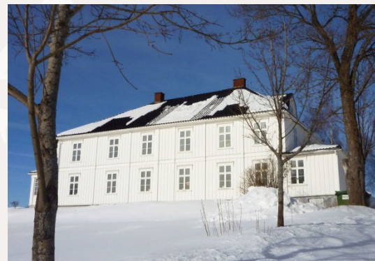
Hovedbygningen på Skansgården i Kongsvinger kommune ble fredet i 1923. Bygningen har regelmessig plasserte vinduer og pilasterkledd laftehoder.
