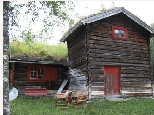
Stuebygningen på Nystu Undset i Rendalen kommune er et eksempel på en barfrøstue fra siste halvdel av 1700-tallet.
