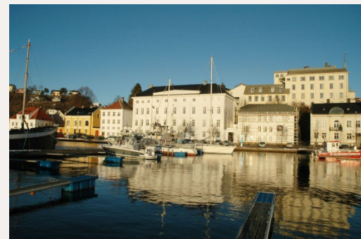
Arendal rådhus/Kallevigpaléet er eksempel på et empirepalé, utformet i tråd med kontinentale strømninger. Bygningen ble oppført i 1813 med Arendals den gang rikeste trelastkjøpmann, Morten Michael Kallevig, som byggherre.
