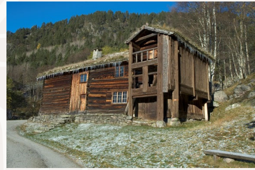
På Rygnestad i Valle er et våningshus av mandalsk stueform og et tre-etasjes loft (Trihågelopt) bygget sammen. Trihågelopt er et eksempel på en svært sjelden loftsform.
