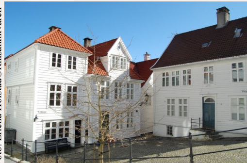
Sliberget 1-3 ligg ved plassen Sliberget, lengst ute på austsida av Nordneshalvøya. Bygningane er typiske representantar for 1700- og 1800-tals byhus i Bergen.
