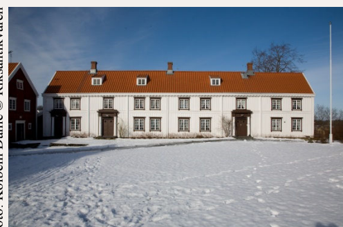
Brusve nedre i Levanger består av to midtkammerbygninger og er satt opp i to omganger i 1803 og 1811.
