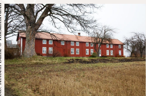
Låna på Logstein på Frosta er hele 43 meter lang. Sammen med Mo i Levanger, er bygningen ei av landets lengste låner.
