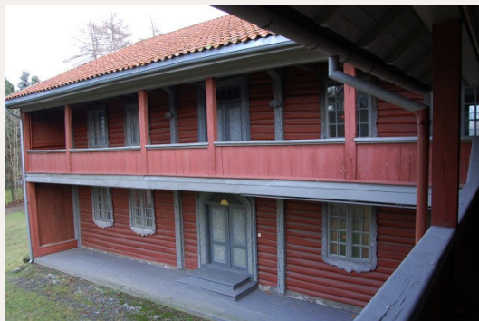
Gjetmyren er et løkkeanlegg i rokokkostil der hovedbygning og sidebygning er eksempler på svalgangsbygningen.
