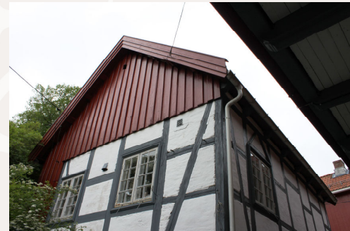
Annekset på Thornegården i Vestby er et eksempel på utmurt bindingsverk
