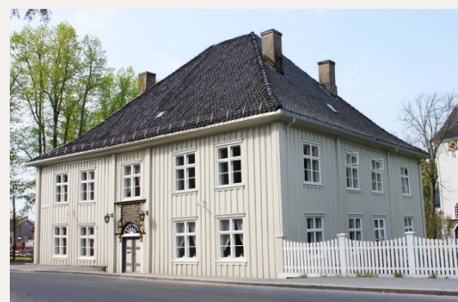
Drøbak hospital med tradisjonell 1700-talls fasade og tavle med gulldekor og tekst i portalen
