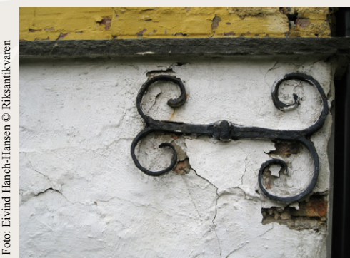
Detalj fra Den gamle tollbod i Larvik. Bygningen er restaurert i 2010- 2012.
