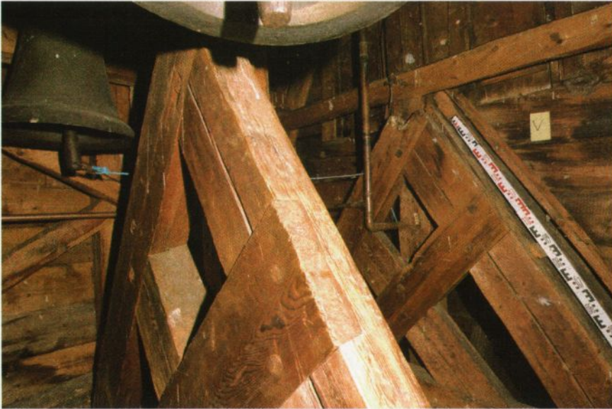
Fig. 17. Høre stavkirke. Skipets hevete midtrom. Øvre del av sperrebindene, sett mot sør-vest. Foto BRL 2005
