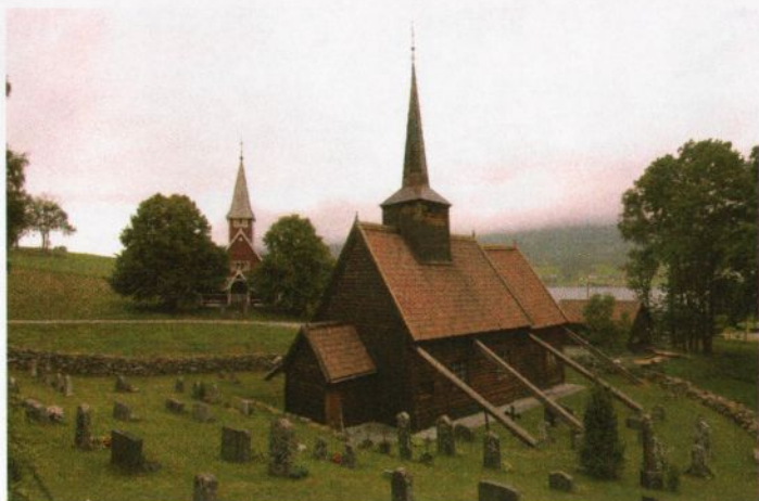
Fig. 2. Rødven stavkirke, sett mot nord-øst. Foto BRL 2005
