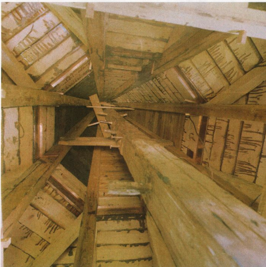
Fig. 7. Rødven stavkirke. Innsiden av takrytterens hette. Foto BRL 2005
