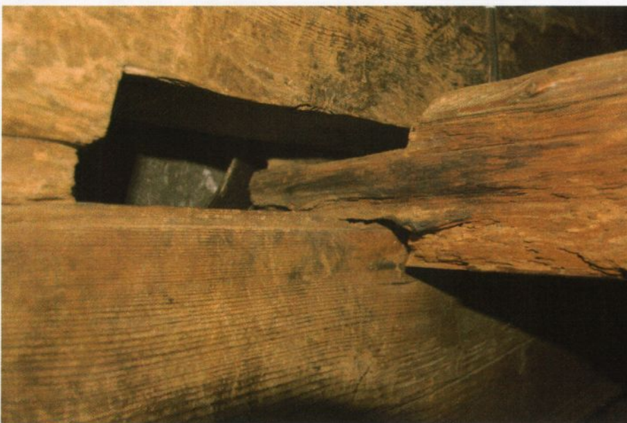
Fig. 5. Rødven stavkirke. Styrebjelkens innfesting i skipets vestre stavlegje. Foto BRL 2005
