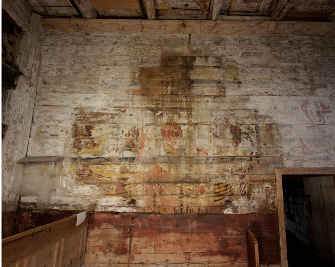
Nordveggen med området som har vært dekket av epitafiet og ikke har vært overmalt og avdekket. Området har vært behandlet i 1960-70-årene, da de øvrige veggflatene ble behandlet
