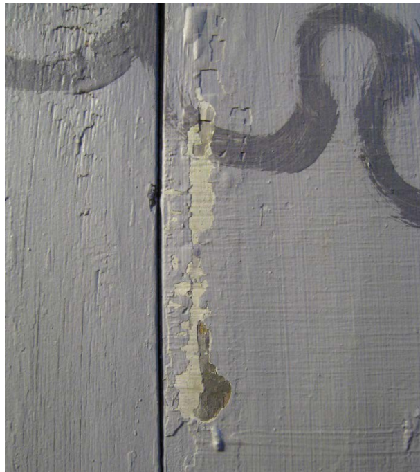
Figur 3. Bildet viser tre malingslag i dekorfeltet; det øverste grå oljemalingslaget, deretter det hvite malingslaget fra slutten av 1800-tallet, og et underliggende mørkere malingslag.
