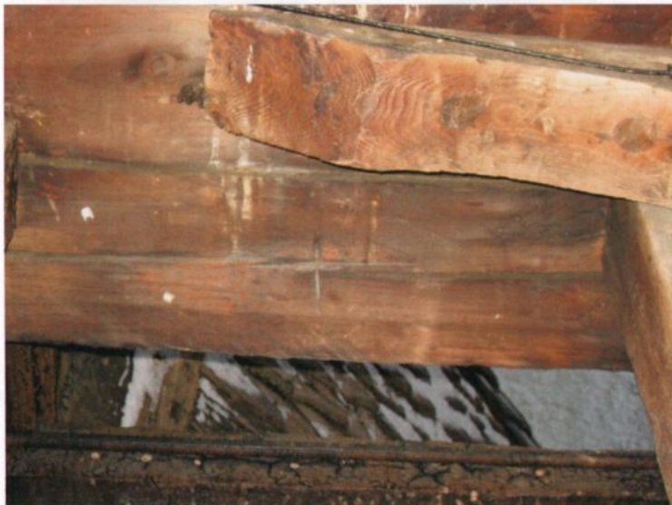
Takrytteren, underbygget. Det sør-østre hjørnet. OS 07
