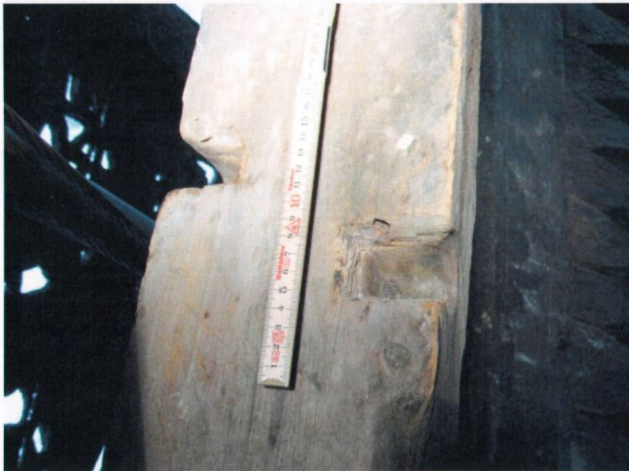
Takrytteren, underbygget.. Spor for klokkeakslinger i den midtre bjelken. OS 07
