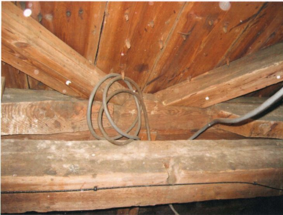
Takrytteren, underbygget. Skråstiverne i den nordre takflaten. OS 07
