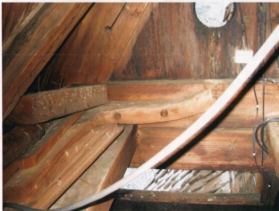
Takrytteren, underbygget. Det sør-vestre hjørnet med innfestet kne. OS 07
