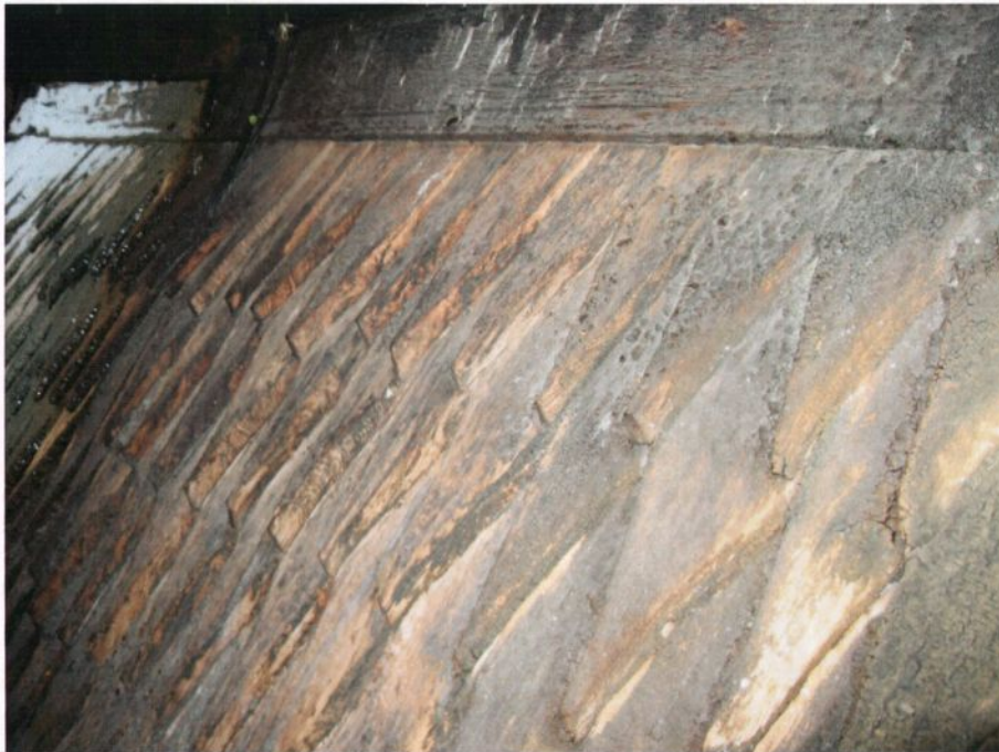
Takrytteren. Søndre takflate på skipets midtrom. OS 07
