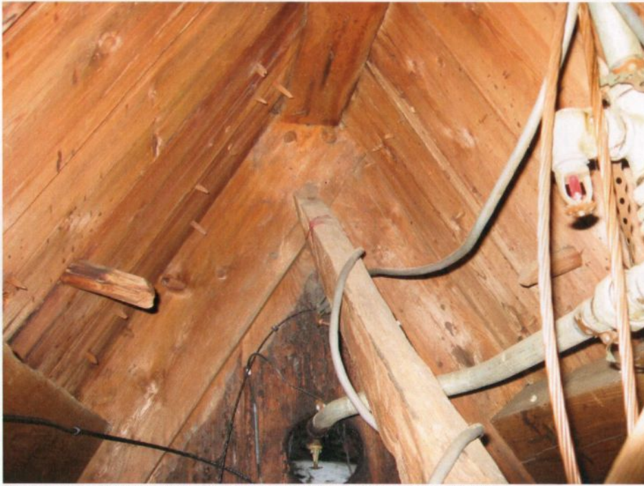
Takrytteren, underbygget. Feste for skråstiver i vestre gavl. OS 07
