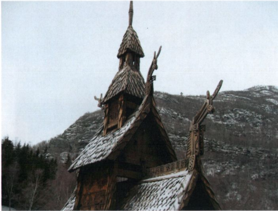
Takrytteren, sett mot nord-vest. OS 07
