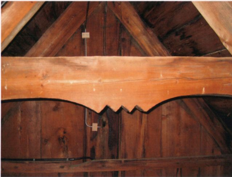
Skipets østre sperrebind, hanebjelken, sett mot øst. OS 06
