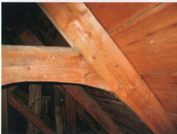
Vestre sperrebind i skipets utvidelse mot vest, sett mot øst. Merk vankanten på hanebjelken! OS 06
