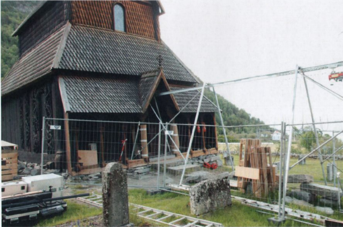
Figur 4 - Rigg for fundamenteringsstein. Foto: Knut Paasche, NIKU.
