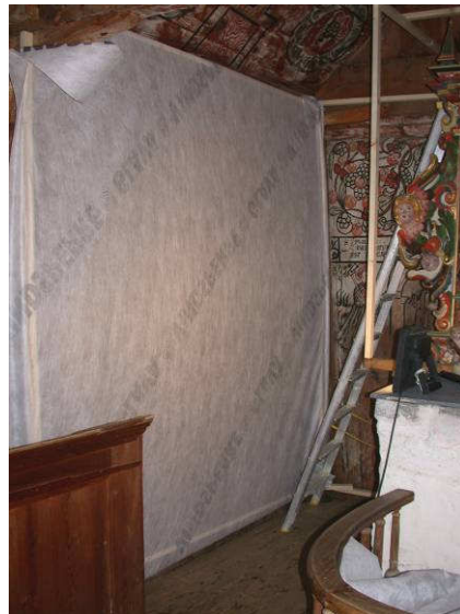
Figur 1. Limfargedekoren i Urnes stavkirke beskyttes med vindsperre mens bygningsarbeidet pågår. Foto: Tone Marie Olstad, januar 2008
