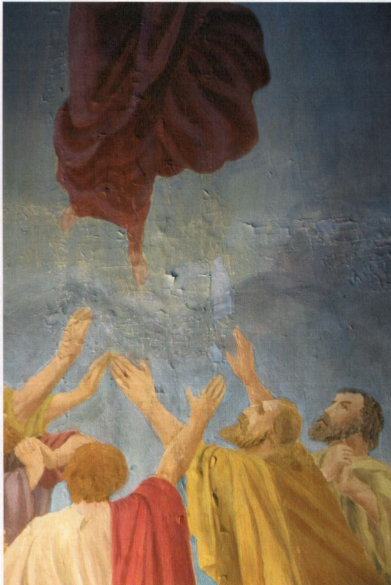
Fig. 1. Reinli stavkirke. Detalj fra albertavlen midtfelt. Eksempel på løs maling: Malingen løfter seg fra underlaget. Splittingen skjer i sparkelen som ligger over rester av middelalderdekor. Foto: Iver Schonhowd, Riksantikvaren, 2007
