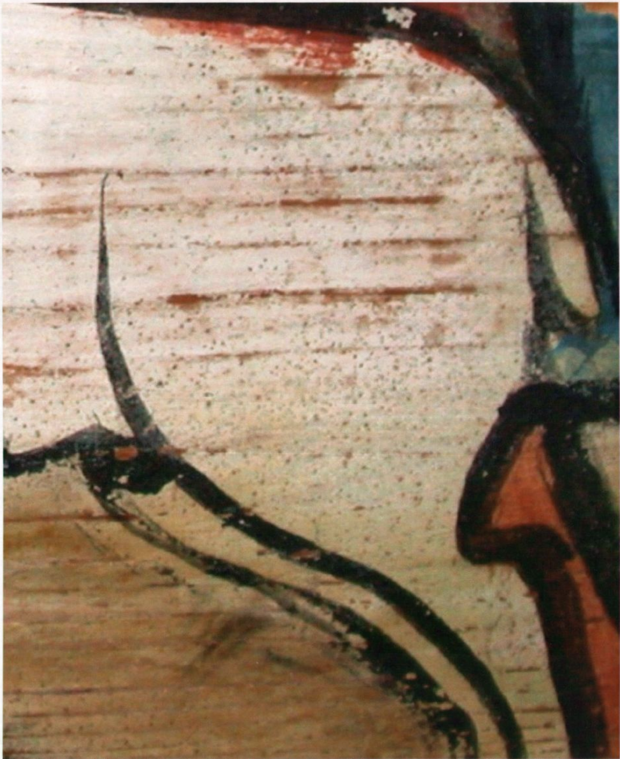
Fig.5. Torpo stavkirke, limfargedekor i baldakinen, nordveggen. Eksempel på sopp/mugg(?), detalj av fig. 4. Foto: M. Stein, NIKU 2007
