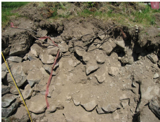
Fig. 4. Støttemuren med ytterliv fjernet. Sett mot nord.
