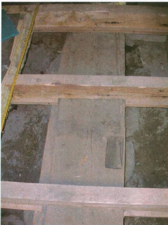
Fig. 7 Østre grunnstokk med steinfundament. Sett fra syd.
