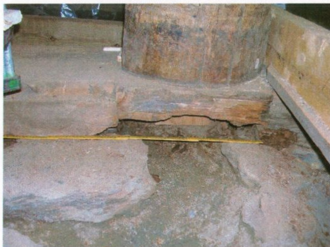
Fig. 4. Nordøstre stav med fundamentsteiner, sett fra vest. Steinene på bildet er fjernet for å få plass til en større fundamentstein under staven.
