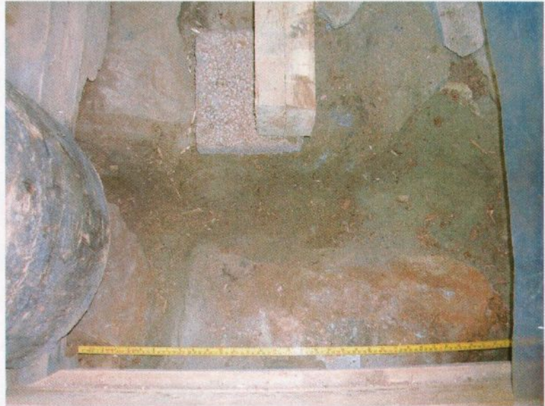
Fig. 6. Østre del av nordre grunnstokk fjernet. Fundamentstein som fortsetter mot syd. Moderne gulvdrager lagt på Lecablokk som hviler på steiner nord for grunnstokken. Ovenfra fra syd.
