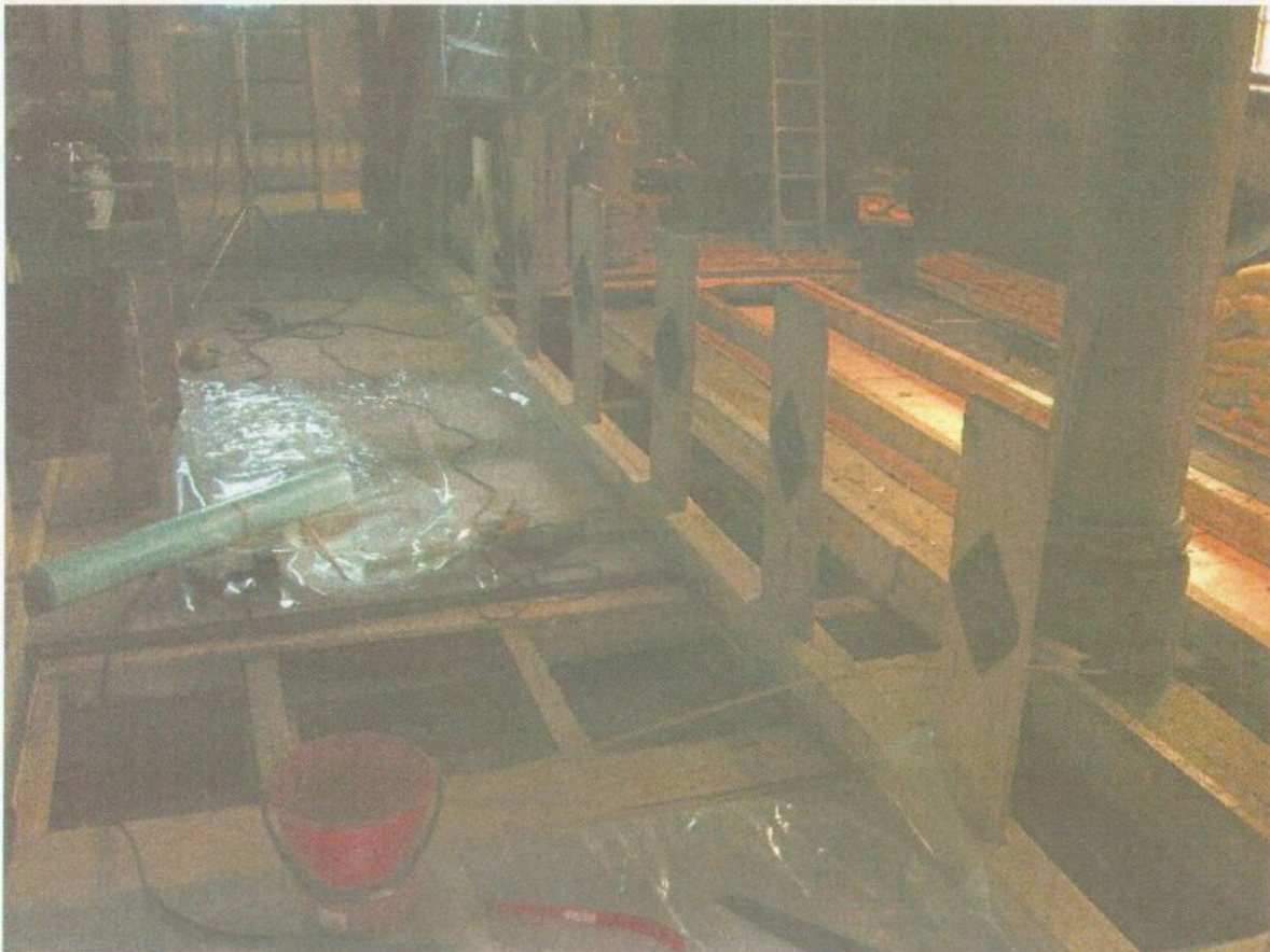
Fig. 1 Kirkebenker demontert og vestre og søndre grunnstokk frilagt. Sett fra nordvest.
