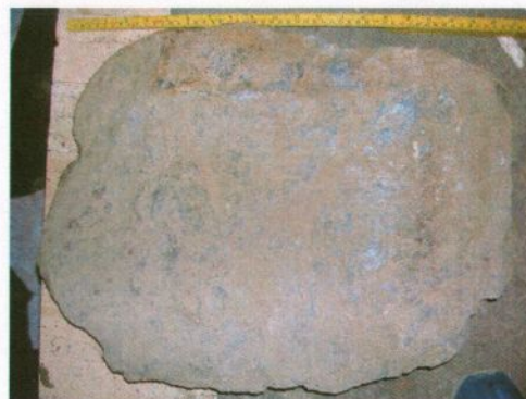
Fig. 5. Stein under østre grunnstokk tatt opp og snudd. Til høyre merker etter undersiden av stokken.
