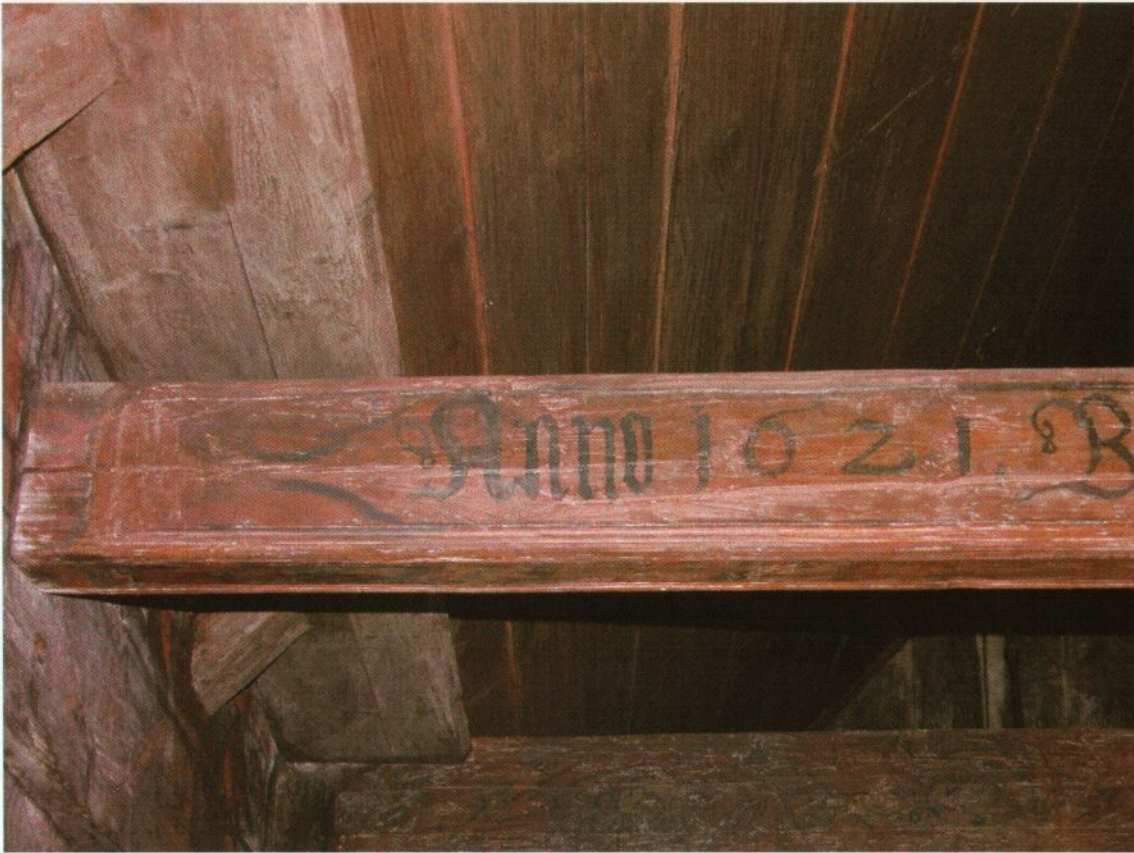
Figur 9. Tidligere overmalt takbjelke med innskrift i limfarge som ble sterkt retusjert på 1930-tallet. Foto: KSo - 2006
