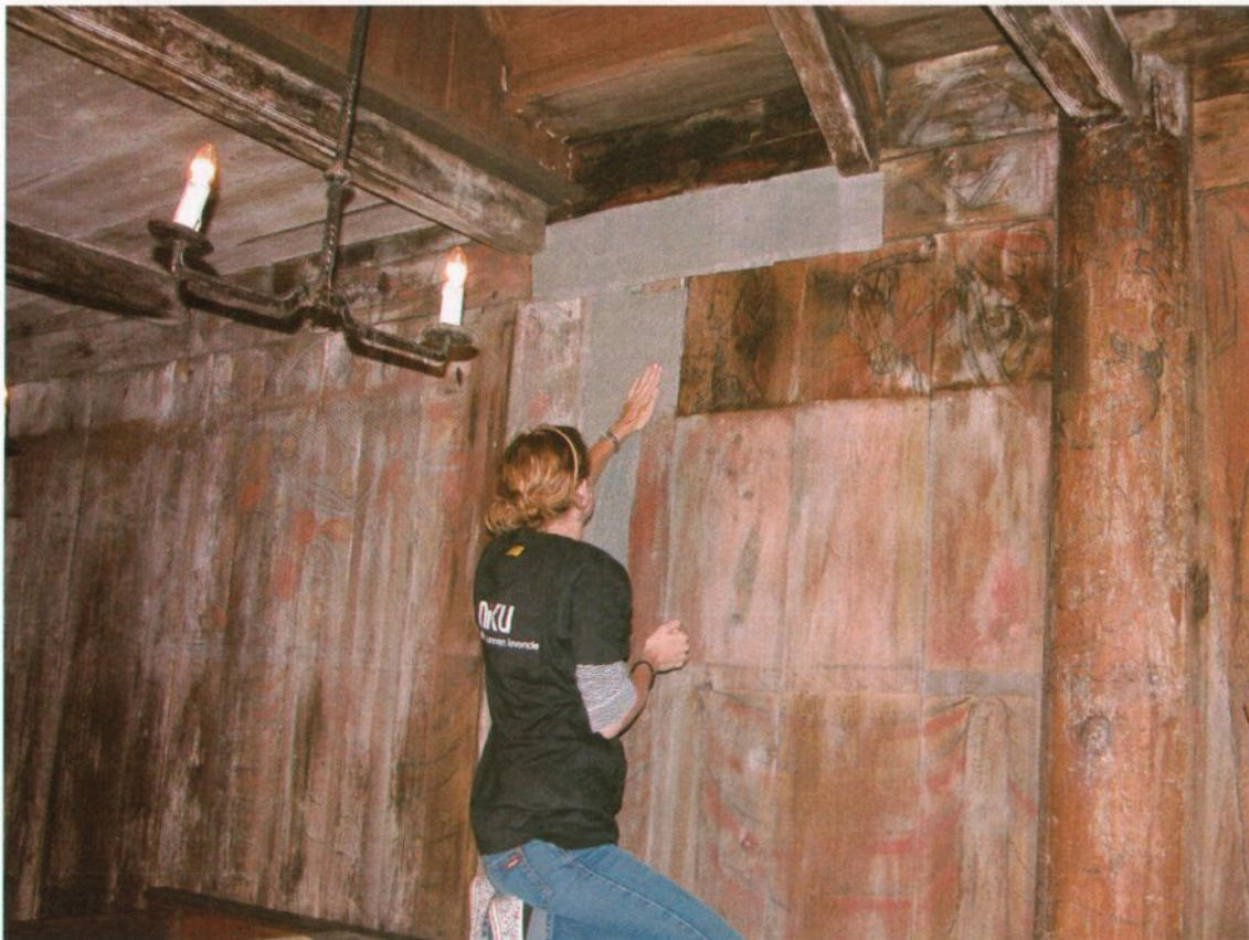
Figur 1. Limfargedekor fra 1600-tallet på nordveggen. Det ble brukt våte papirkompresser til å rense bort mørke skjolder. Foto: KSo - 2006
