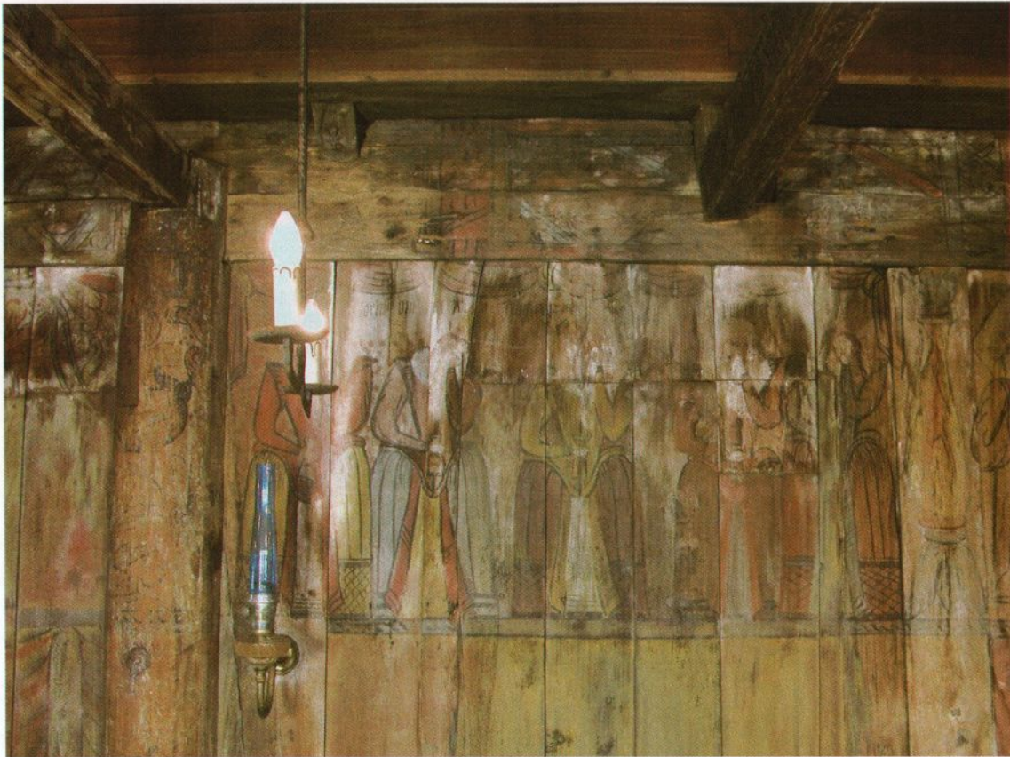
Figur 2. Parti på nordveggen i skipet før rensing og konsolidering. Foto: KSo -2006
