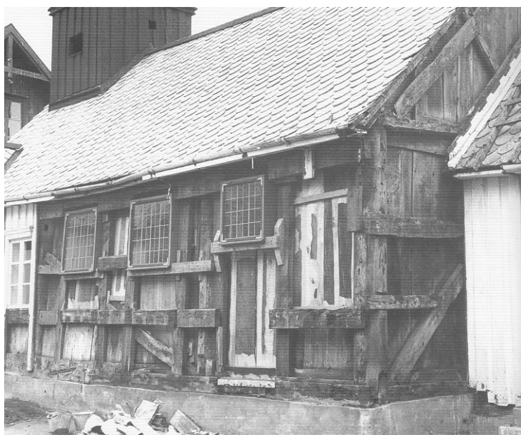
Grip stavkirke, sør- og østveggen, fra arbeidene på 1930-tallet. Iversen 1998
