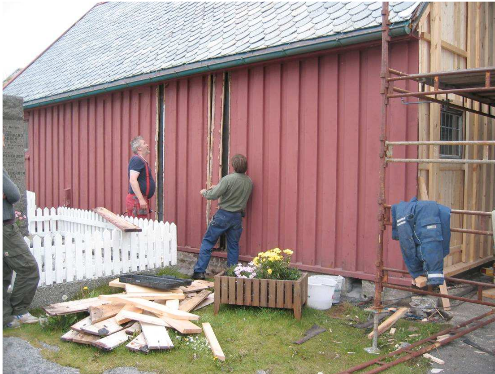
Grip stavkirke, åpning av felt i nordveggen. OS 06
