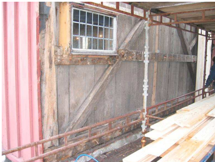
Grip stavkirke, vestgavlens nedre del, tilsynelatende opprinnelig skråstiver til venstre i bildet. OS 06
